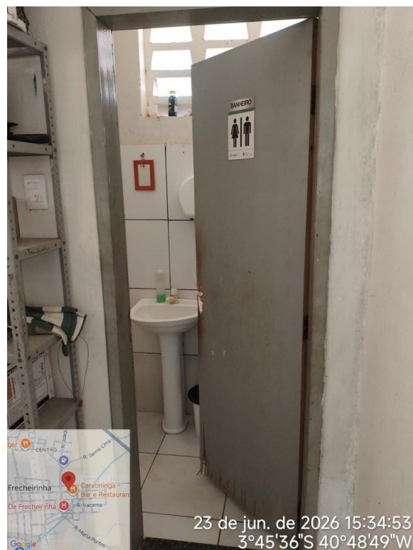
Foto 44 - Núcleo: banheiro localizado em área administrativa de acesso restrito.
