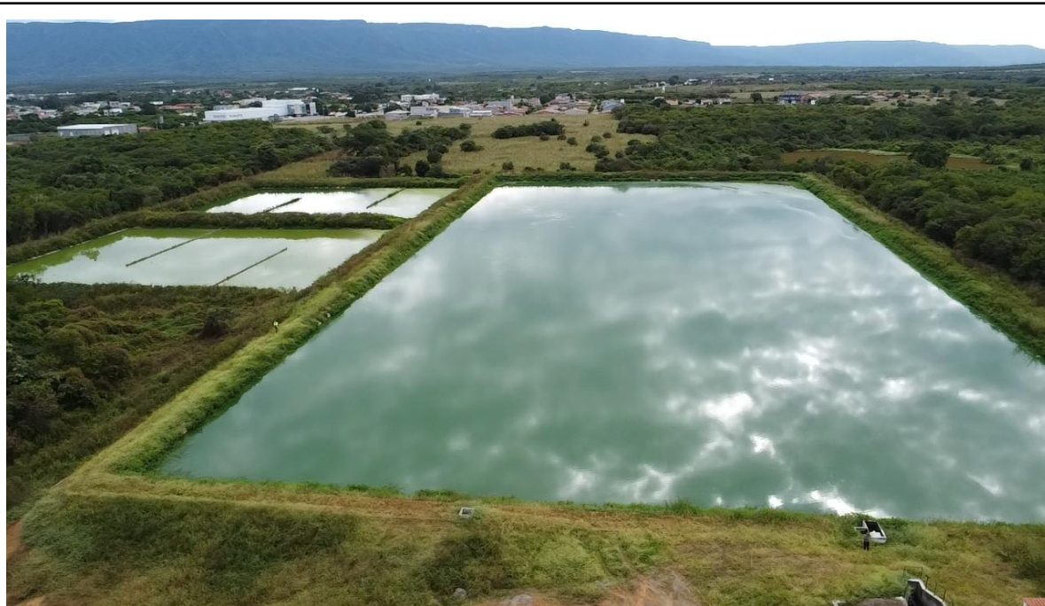
Foto 75 - ETE: lagoas com taludes tomados por vegetação crescida, avançando sobre a área de circulação.
