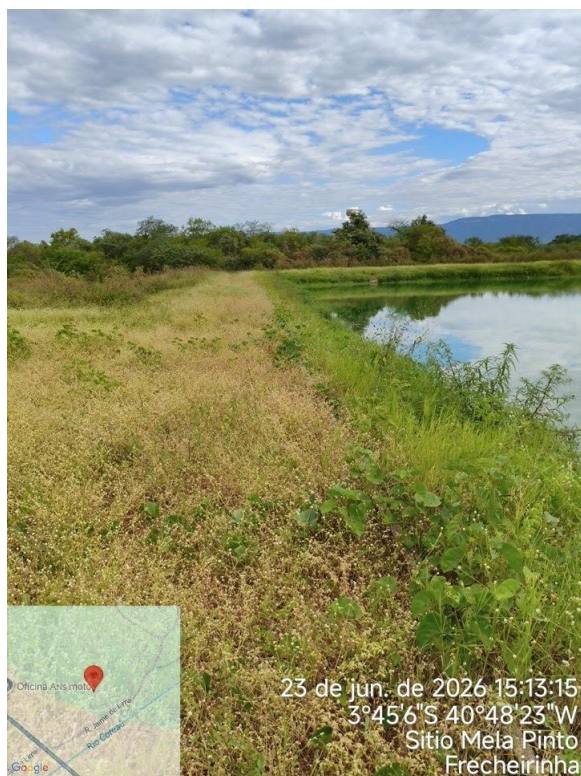
Foto 73 - ETE: lagoas com taludes tomados por vegetação crescida, avançando sobre a área de circulação.
