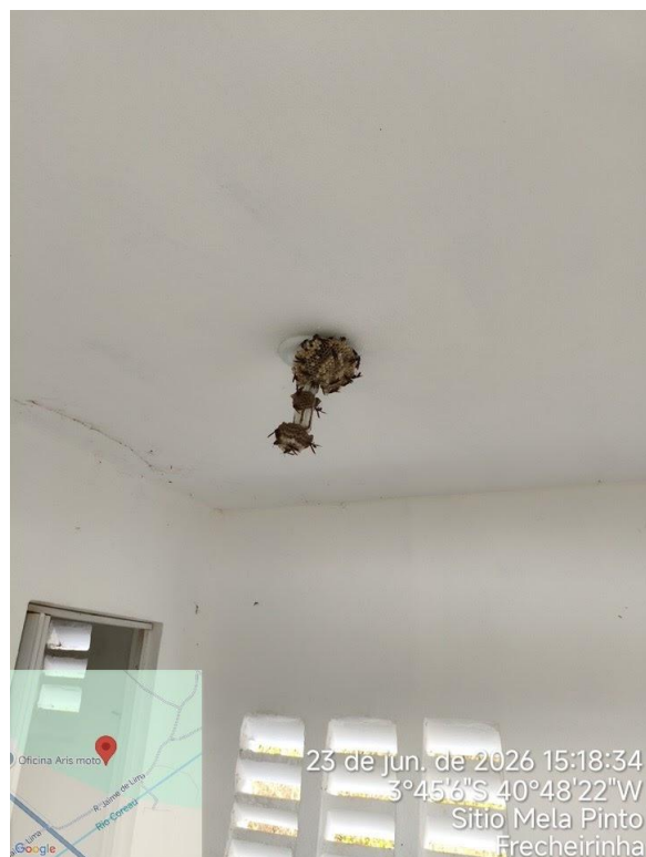
Foto 42 - ETE: sem iluminação na área externa e na casa de apoio.
