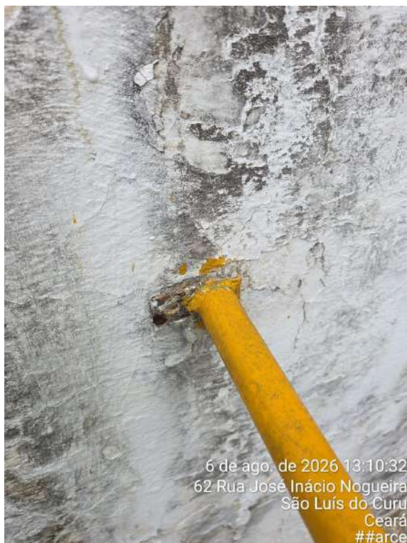
Foto 74 - Filtros de alvenaria (F-01 e F-02) da ETA: escada de acesso ao patamar superior sem fixação.
