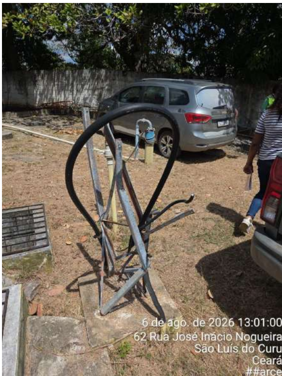
Foto 46 - Área de circulação e acesso operacional da ETA: resquícios de estrutura metálica de antiga torre de rádio dispostos inadequadamente no local.
