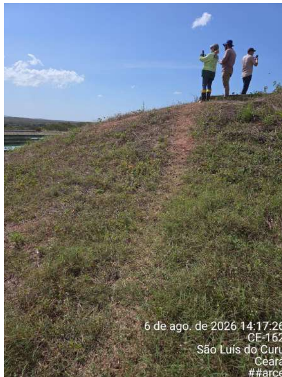
Foto 115 - Área de circulação e acesso operacional da lagoa facultativa e de maturação: acesso dificultado às lagoas, com ausência de caminho adequado e presença de terreno irregular com vegetação.
