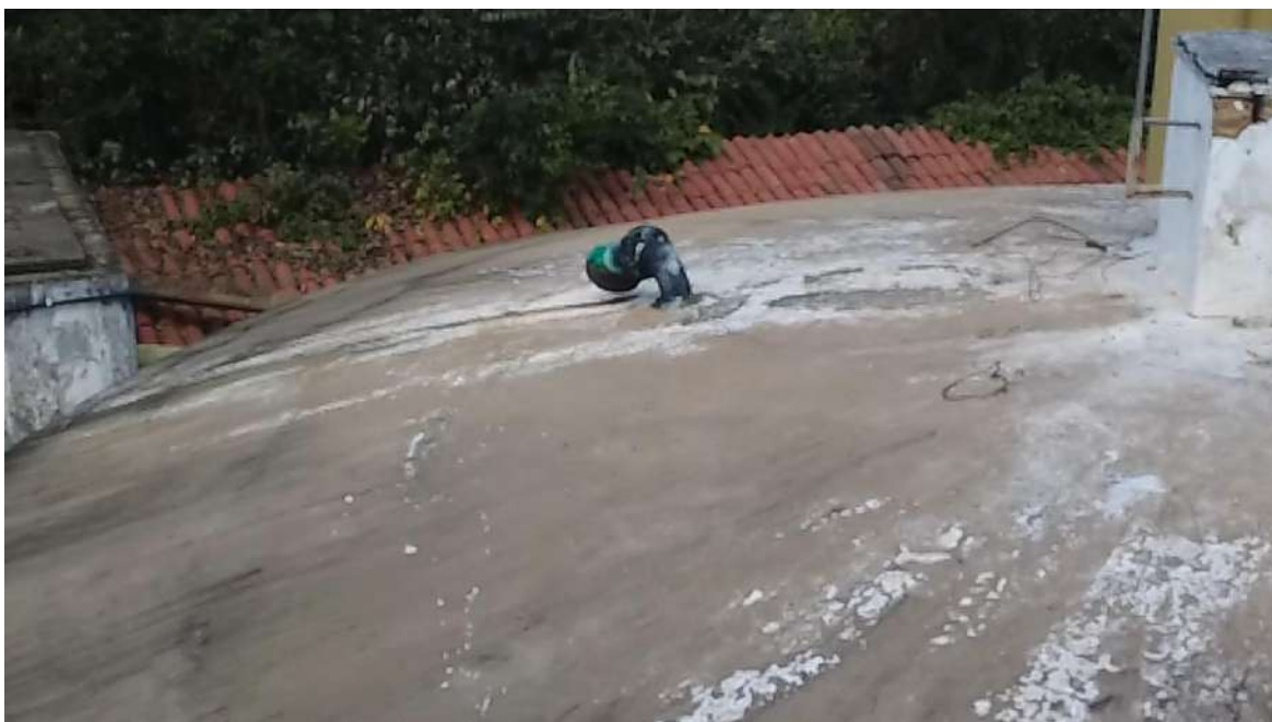
Foto 53 - RAP-01: suspiro oxidado e sem tela de proteção, patamar superior desprovido de guarda-corpo, sinais de umidade e deterioração do revestimento, associado a presença de fissuras.
