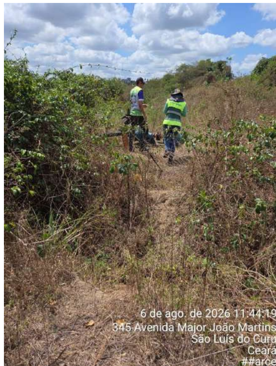
Foto 101 - Captação do Rio Curu: acesso ao conjunto motobomba dificultado pela presença de vegetação e de desníveis no percurso, dificultando a circulação.
