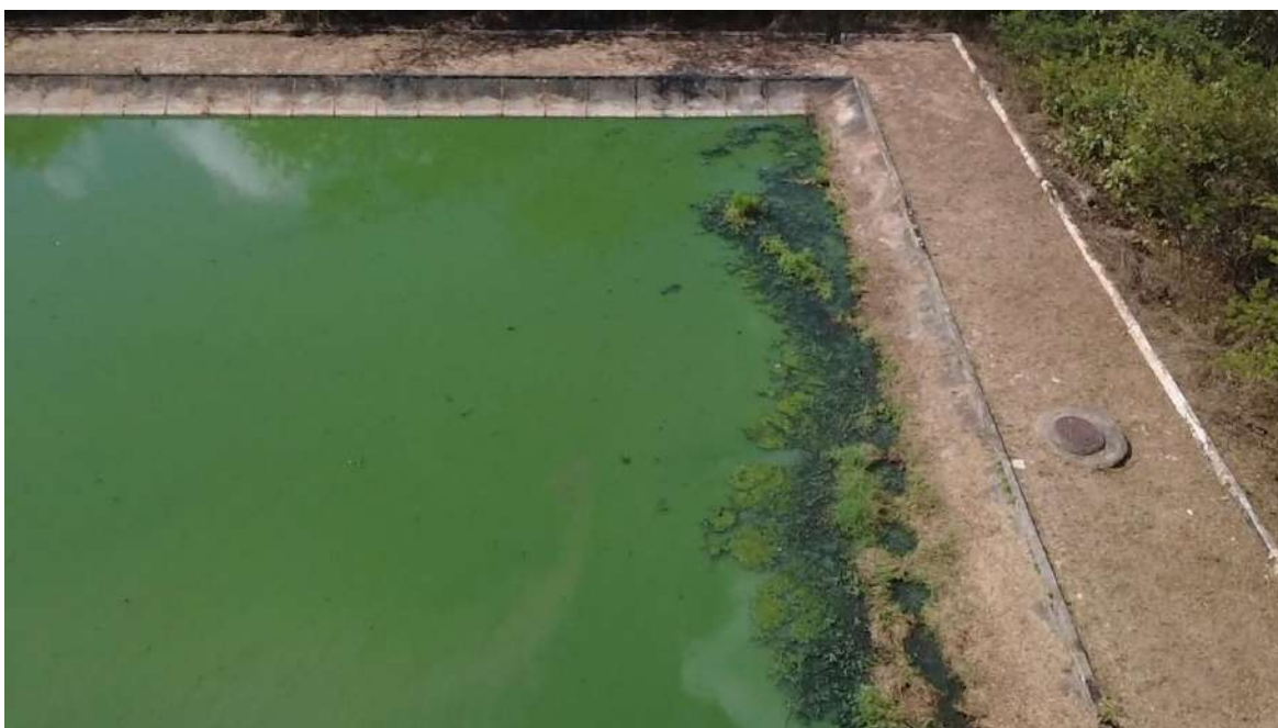
Foto 118 - Lagoa facultativa: presença de vegetação e de sujeira, reduzindo a área útil de tratamento.
