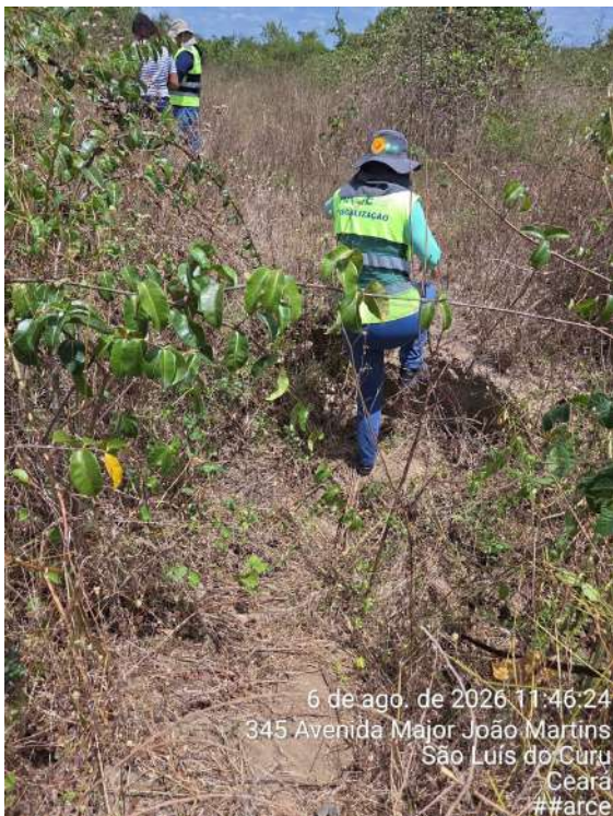
Foto 100 - Captação do Rio Curu: acesso ao conjunto motobomba dificultado pela presença de vegetação e de desníveis no percurso, dificultando a circulação.
