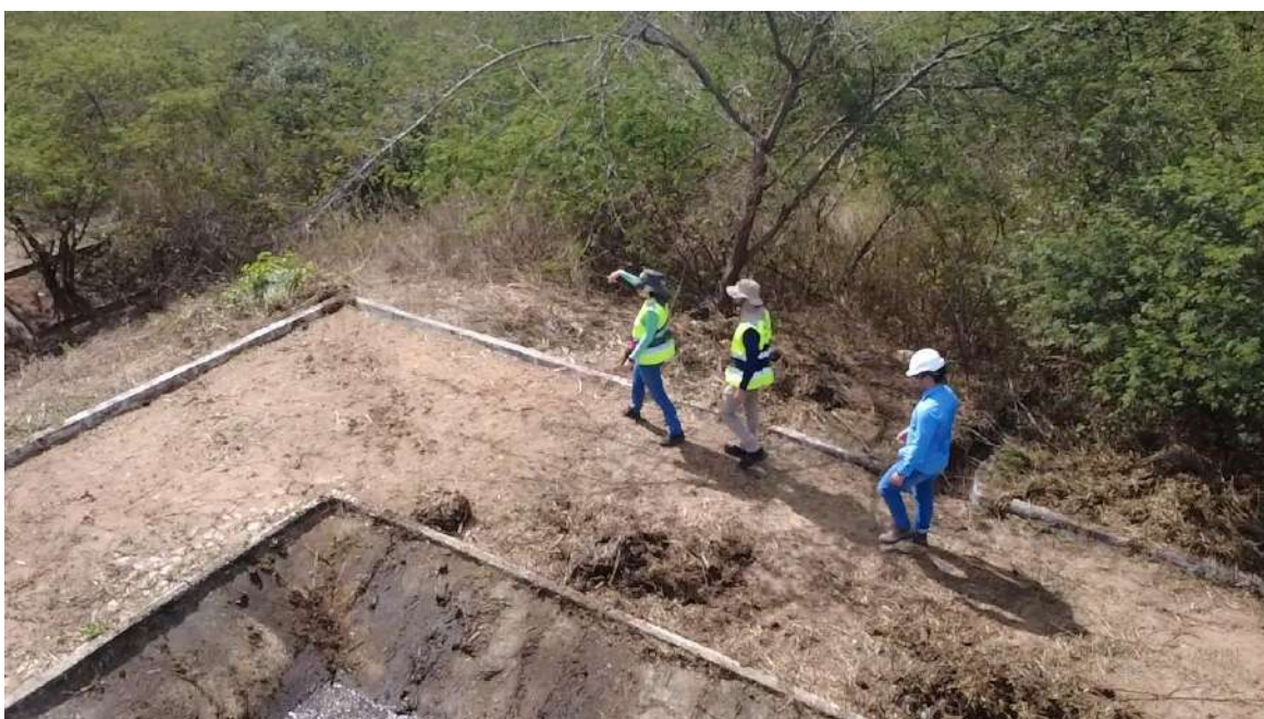
Foto 109 - Área de circulação e acesso operacional da lagoa facultativa e de maturação: via com presença de resíduos potencialmente contaminados, comprometendo as condições de higiene e segurança da circulação, além de ausência de cercamento no perímetro da lagoa, permitindo livre acesso à área.
