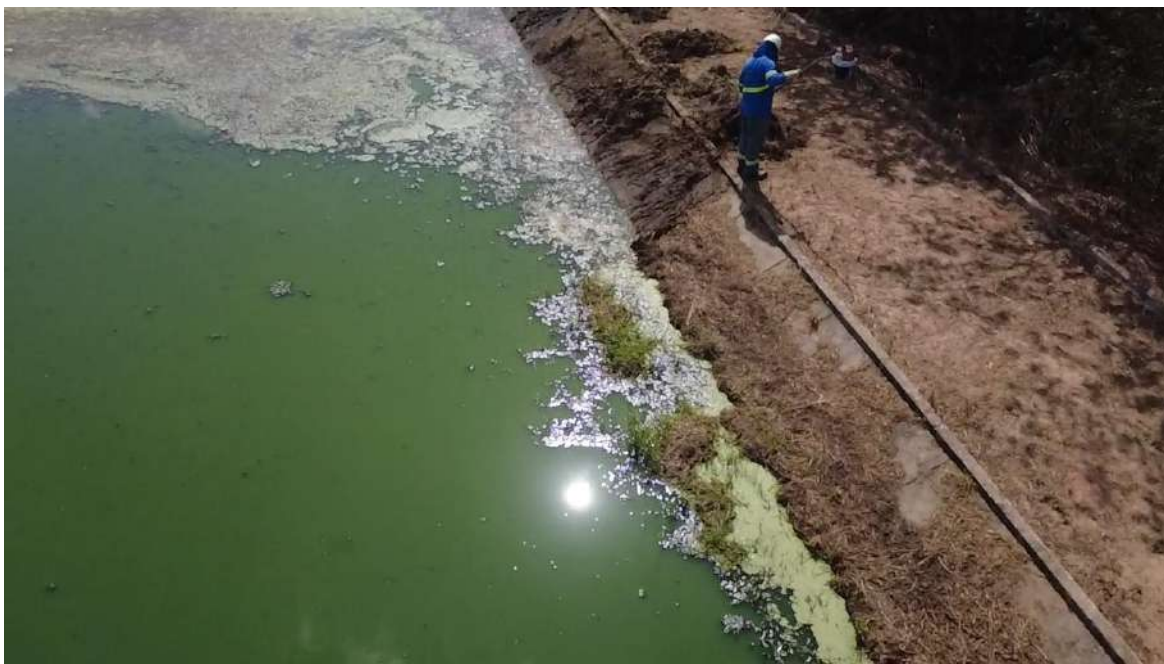
Foto 120 - Lagoa facultativa: presença de vegetação e de sujeira, reduzindo a área útil de tratamento.
