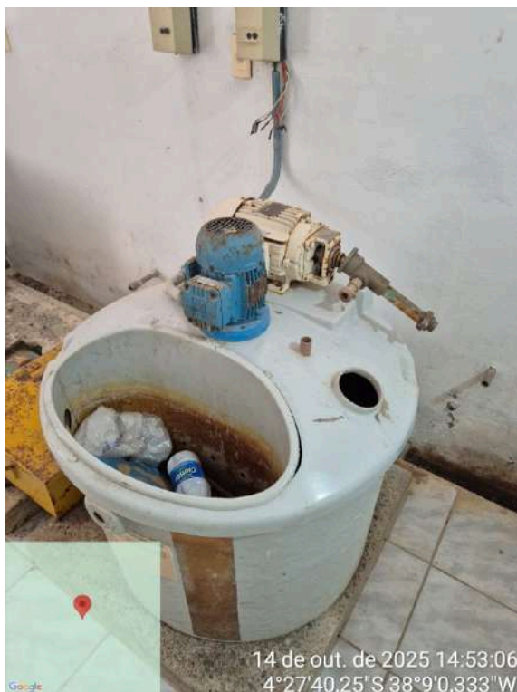
Foto 87 - ETA/Casa de química (Serra do Félix): tanques de preparação de produtos usados como descarte.
