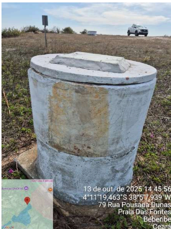
Foto 11 - Poços (Sede): PT-03 com manchas de ferro.
