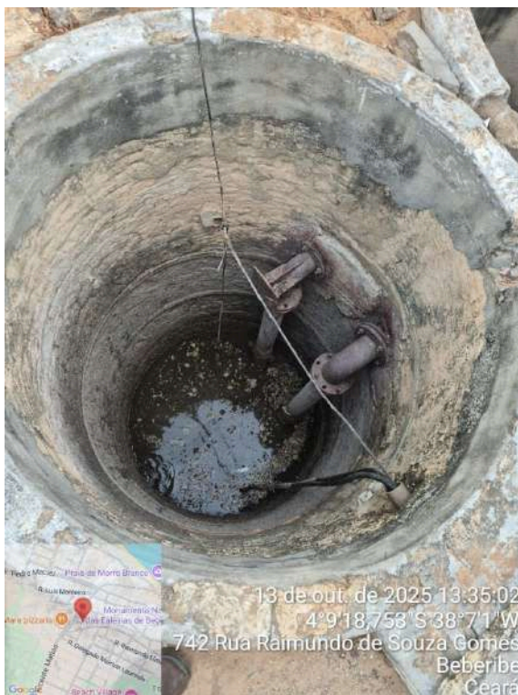
Foto 134 - EEE-03: tubulação oxidada.
