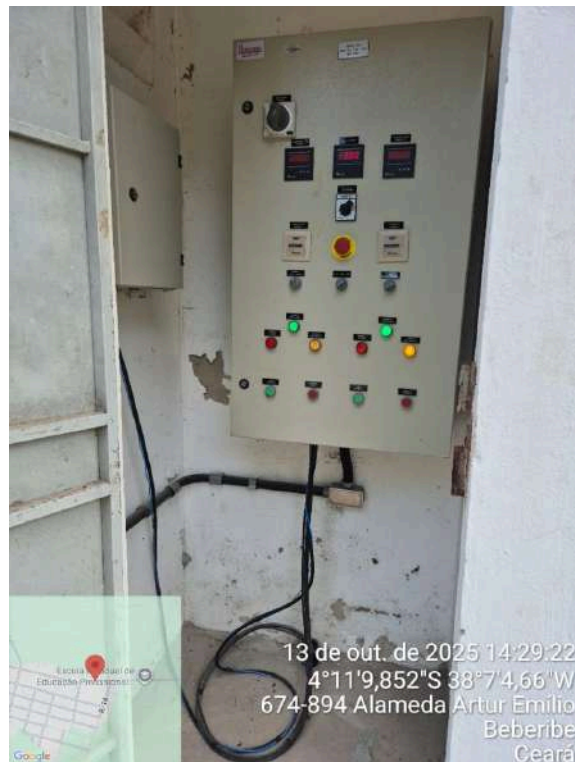
Foto 16 - Poços (Sede): PT-13 com painel com fiação sem eletroduto.
