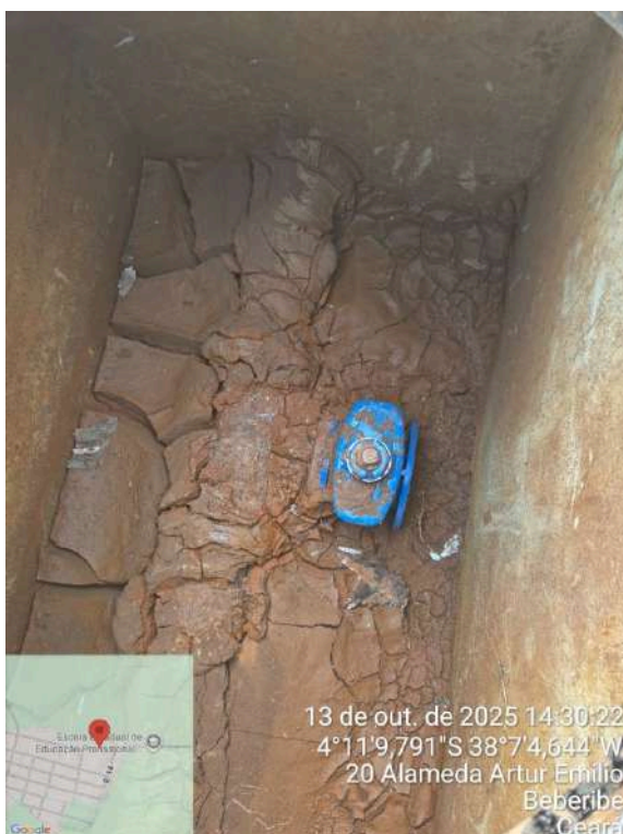
Foto 21 - Poços (Sede): descarga da adutora com alto teor de ferro.
