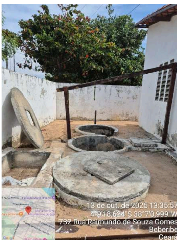
Foto 136 - EEE-03: caixas de concreto quebradas.
