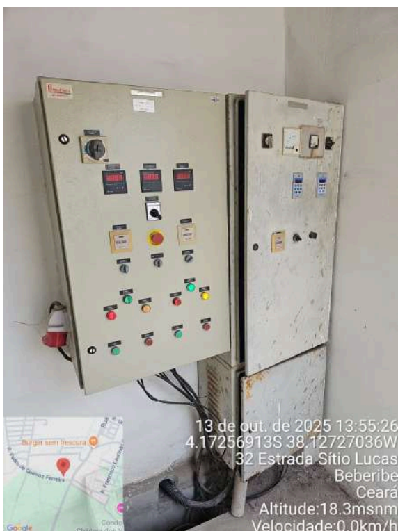
Foto 128 - EEE-02: quadro com fiação sem eletrodutos.
