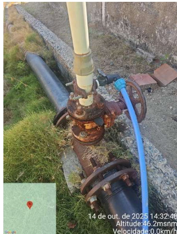
Foto 99 - ETA (Serra do Félix): vários materiais na mesma tubulação, com oxidação na parte metálica.
