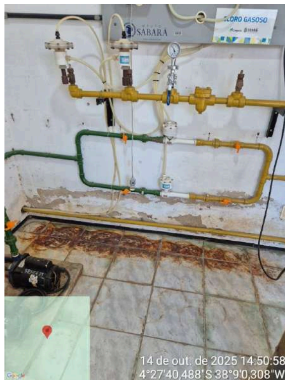
Foto 84 - ETA/Clorador (Serra do Félix): piso próximo a dosagem de cloro corroído.
