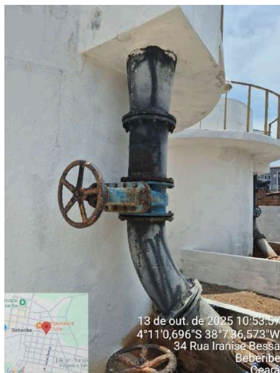
Foto 30 - ETA (Sede): tubulação do F-01 com válvula e tubulação oxidadas.
