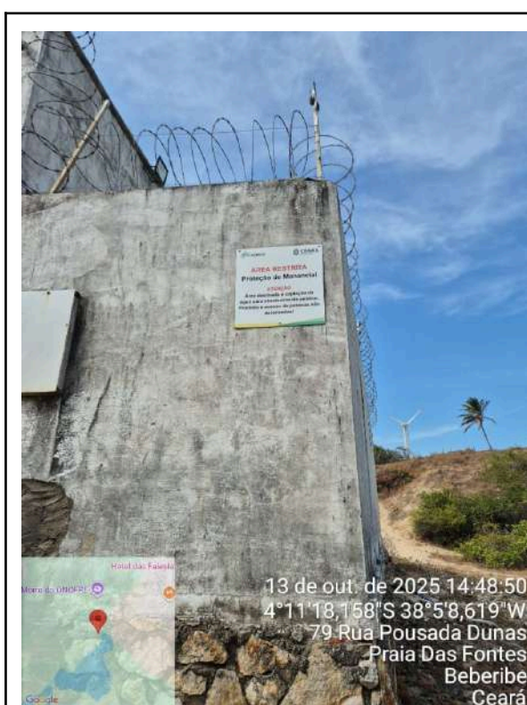
Foto 1 - Captação (Sede): sem identificação adequada e com pintura desgastada.
