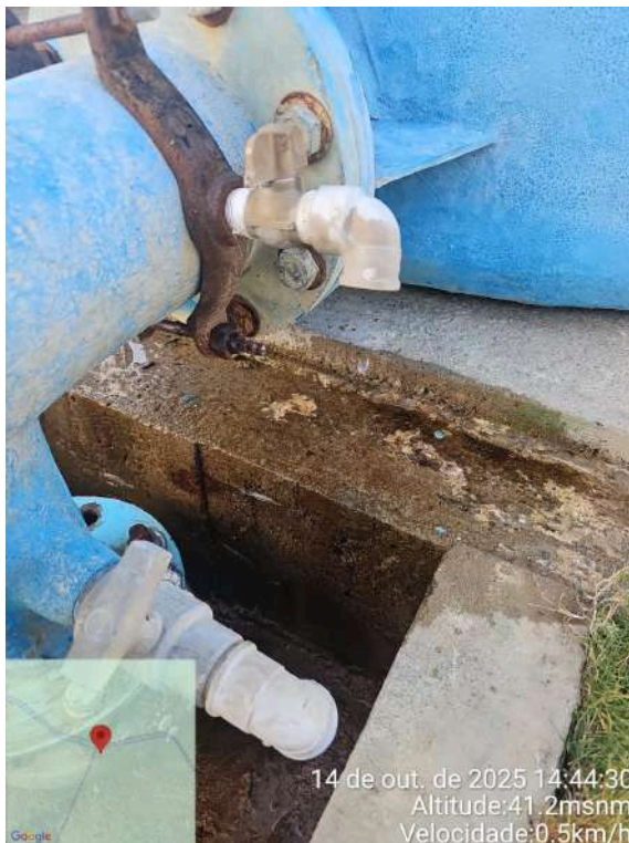
Foto 98 - ETA (Serra do Félix): vazamento no registro do filtro.
