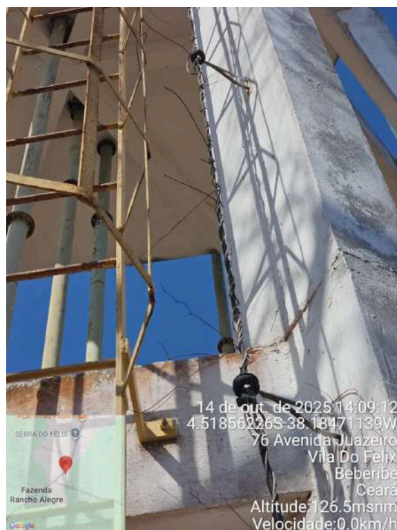
Foto 72 - REL-01 (Serra do Félix): fiação para-raios descascando.
