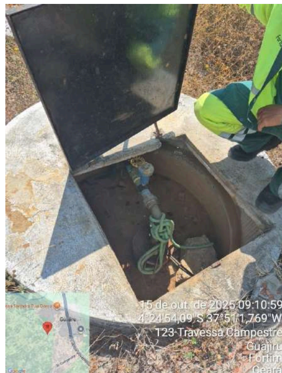
Foto 44 - Poços (Parajuru): Poço 4 com tampa soltando e estrutura interna oxidada.
