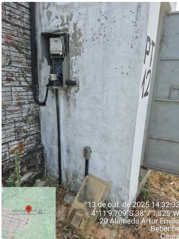
Foto 15 - Poços (Sede): PT-12 com caixa de energia exposta.
