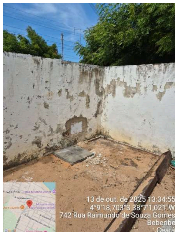
Foto 133 - EEE-03: parede desgastada.
