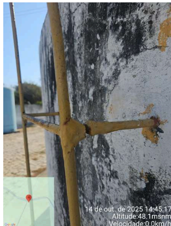
Foto 101 - ETA (Serra do Félix): RAP-01 com escada quebrada.
