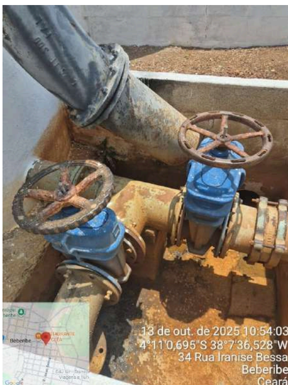
Foto 29 - ETA (Sede): tubulações dos filtros oxidadas, com indícios de presença de ferro.
