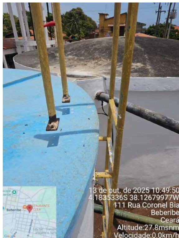
Foto 24 - ETA (Sede): escada dos filtros sem guarda-corpo, com ponto de fixação oxidado.
