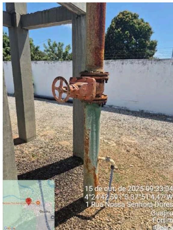
Foto 50 - ETA (Parajuru): Aerador com tubulação, estrutura e escada oxidados.
