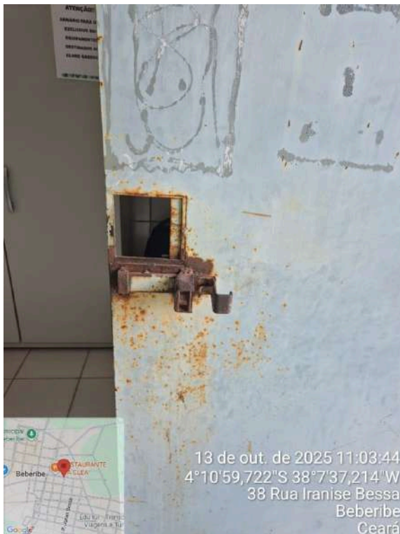
Foto 31 - ETA (Sede): Laboratório com porta oxidada.
