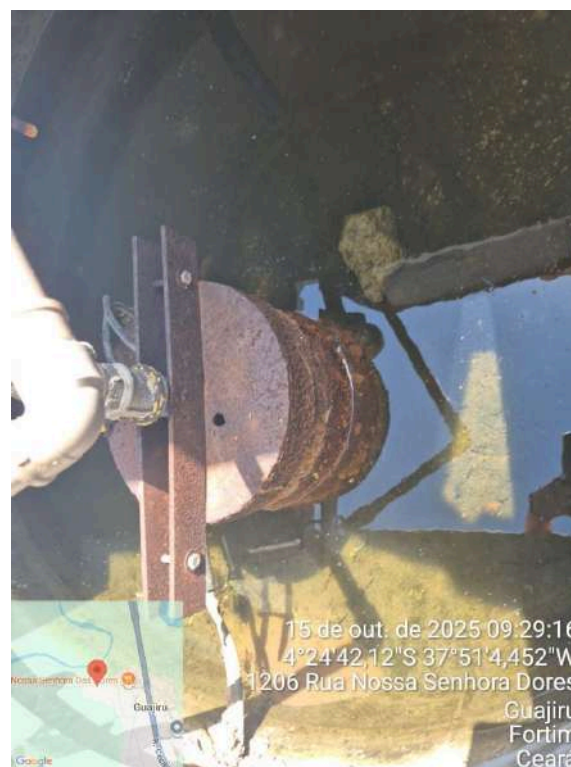
Foto 40 - Poço 1 com tampa e estrutura interna oxidadas.
