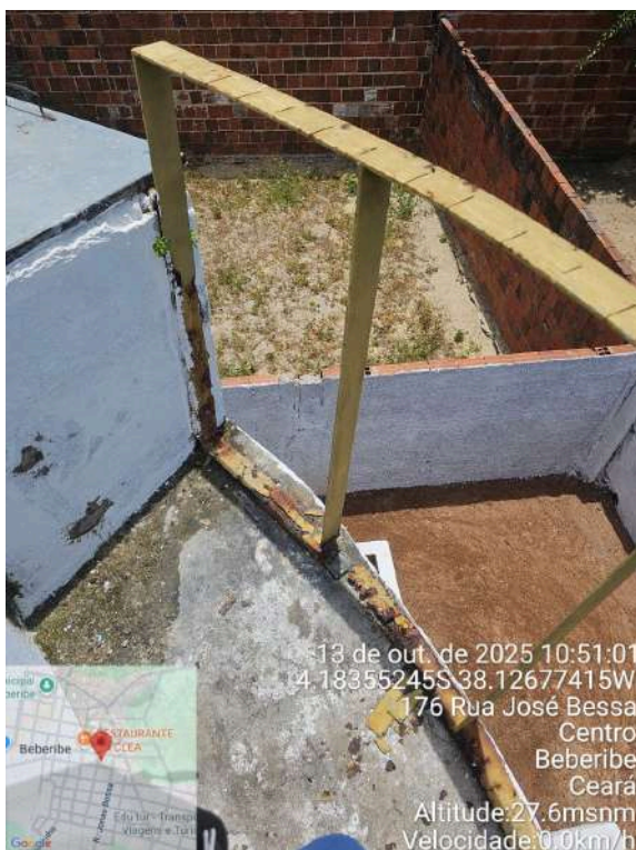
Foto 25 - ETA (Sede): guarda-corpo do filtro oxidado.
