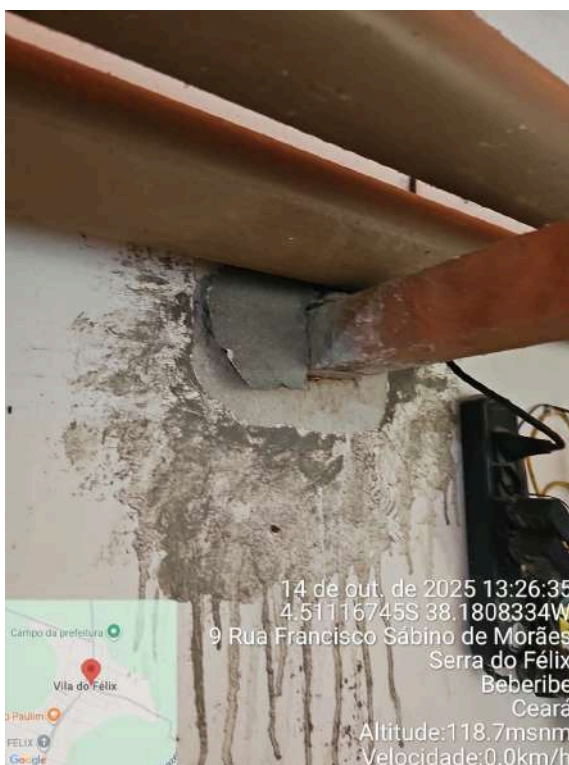
Foto 63 - Almojarifado (Serra do Félix): viga de apoio da tubulação soltando.
