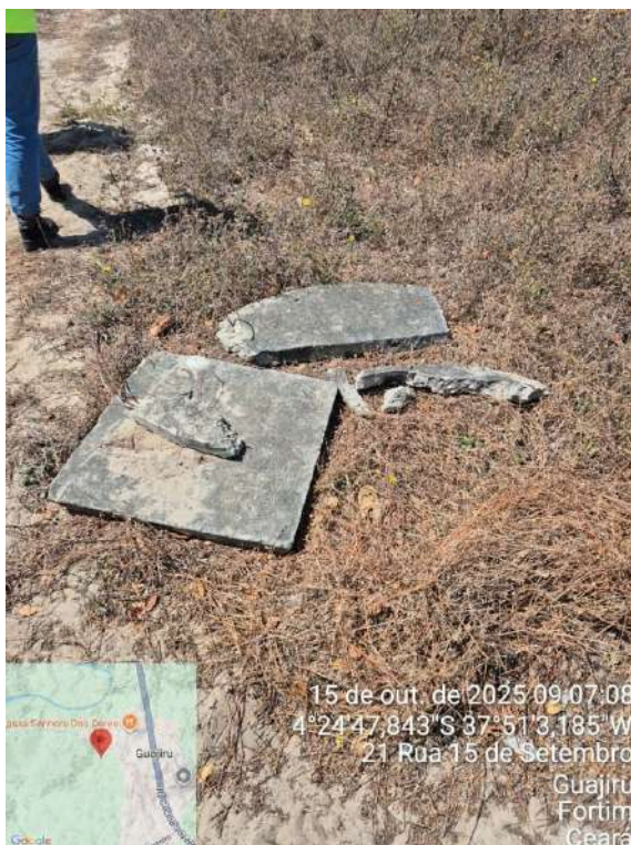
Foto 43 - Poços (Parajuru): tampa quebrada descartada inadequadamente.
