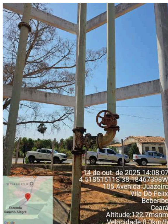
Foto 68 - REL-01 (Serra do Félix): tubulação com oxidação.
