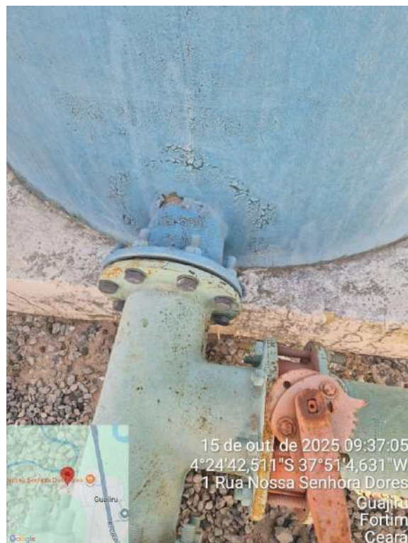
Foto 54 - ETA (Parajuru): Filtros com tubulação oxidada e com tinta descascando.
