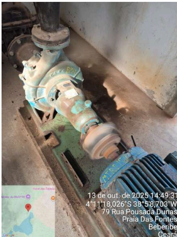
Foto 7 - Captação (Sede): bomba sem caixa de proteção e com pontos de oxidação.
