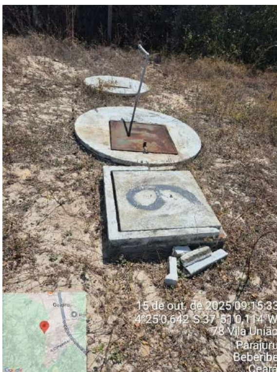
Foto 47 - Poços (Parajuru): Poço 6 com tampa e estrutura interna oxidadas e base de concreto quebrada.
