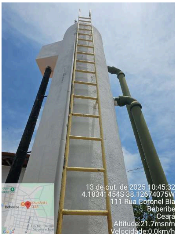
Foto 23 - ETA (Sede): escada do tanque de equalização sem guarda-corpo.
