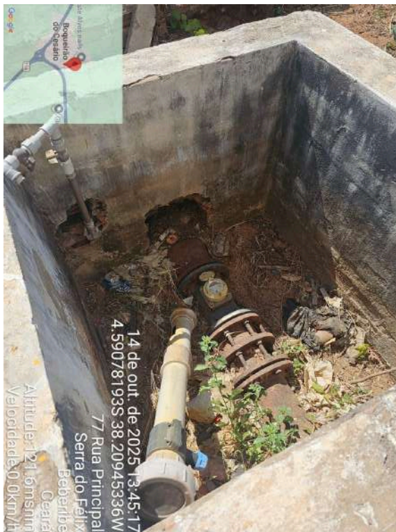
Foto 76 - REL-02 (Serra do Félix): hidrômetro oxidado e caixa danificada.
