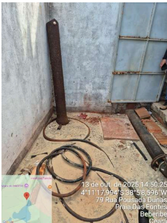
Foto 9 - Captação (Sede): acúmulo de fiação em local inadequado.
