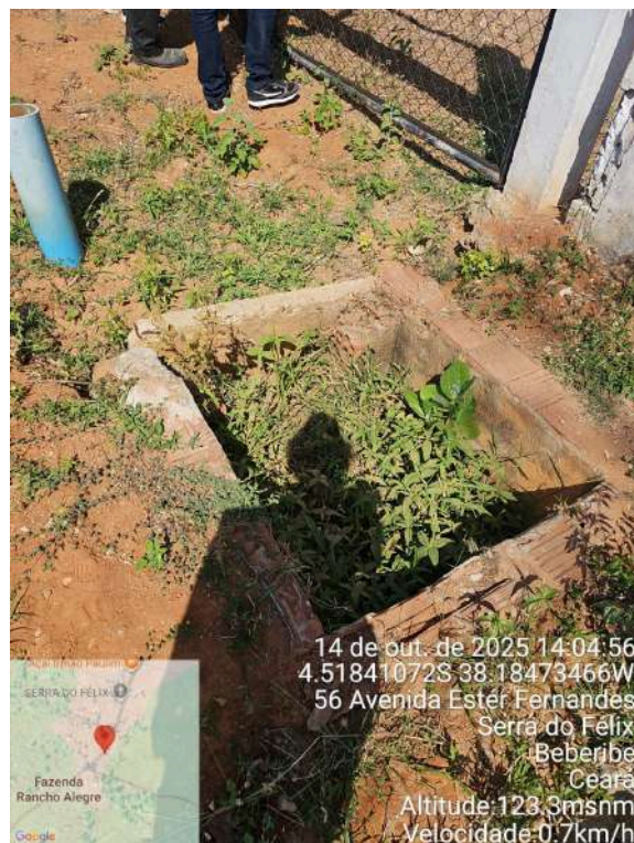
Foto 66 - REL-01 (Serra do Félix): caixa sem proteção e com acúmulo de vegetação.
