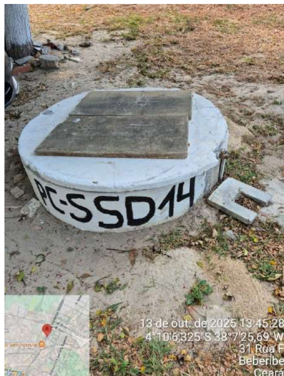
Foto 18 - Poços (Sede): PC-SSD 14 com tampa inadequada, sem fechamento.
