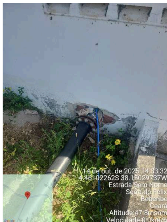
Foto 94 - ETA (Serra do Félix): tubulação com mangueira amarrada saindo da parede sem vedação adequada.
