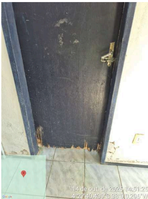
Foto 83 - ETA/Clorador (Serra do Félix): porta da sala do clorador desgastada.
