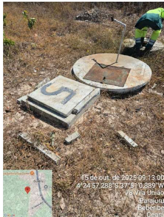
Foto 46 - Poços (Parajuru): Poço 5 com tampa do poço oxidada e base de concreto quebrada.
