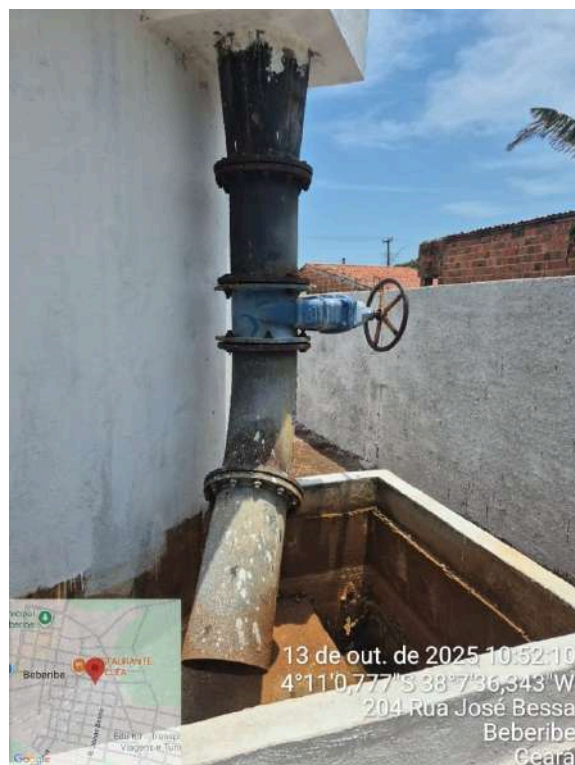
Foto 26 - ETA (Sede): tubulações dos filtros oxidadas.
