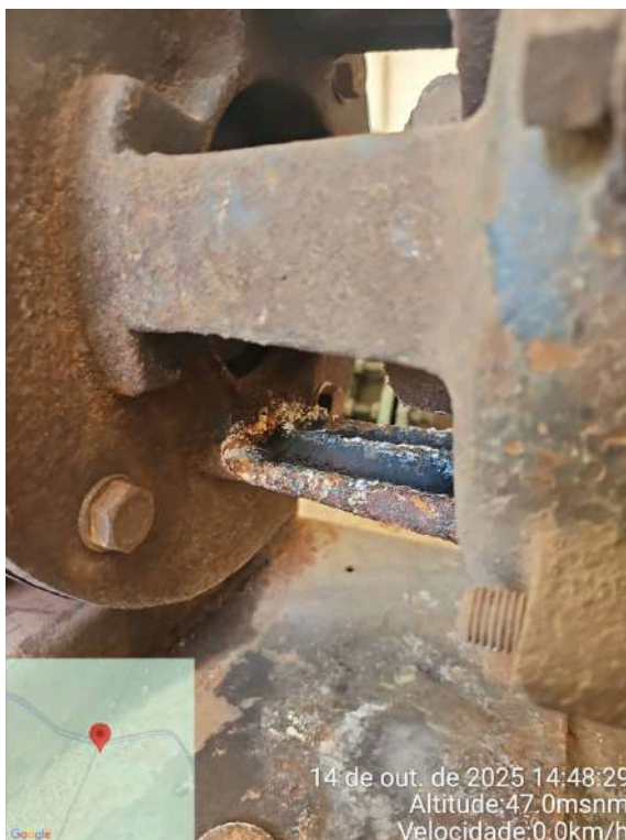
Foto 100 - ETA (Serra do Félix): bomba com oxidação.
