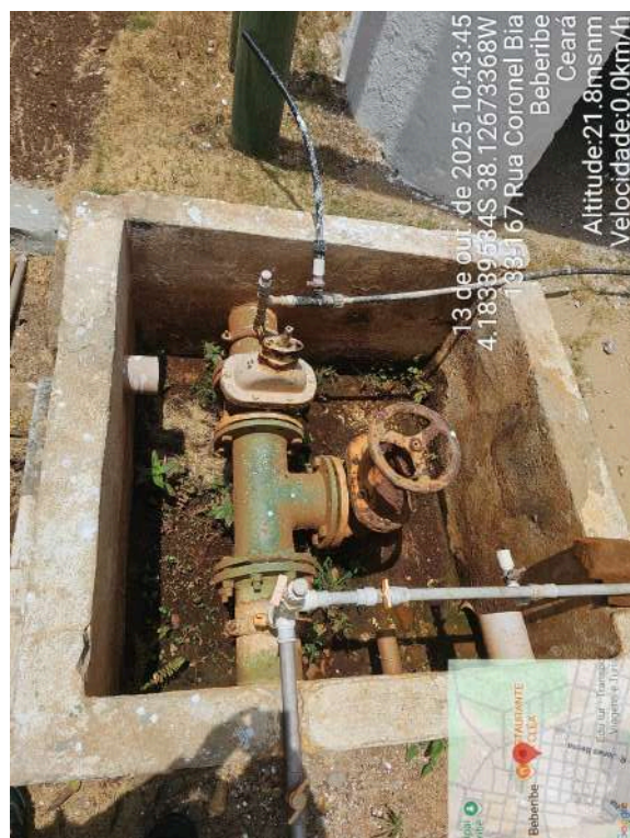
Foto 22 - ETA (Sede): entrada de água bruta com tubulação oxidada.
