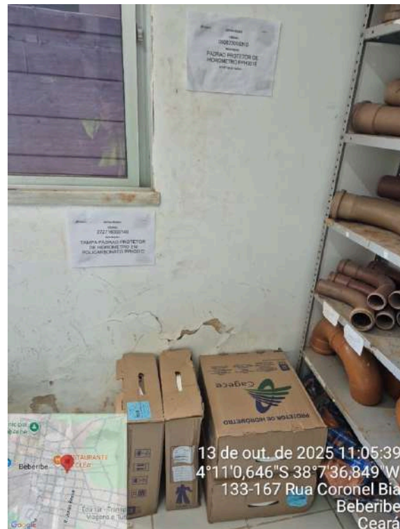
Foto 32 - ETA (Sede): Almoxarifado com parede descascando.
