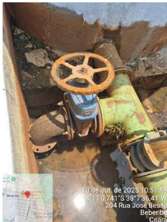
Foto 28 - ETA (Sede): tubulações dos filtros oxidadas.
