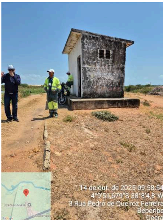
Foto 106 - ETE Sítio Lucas: casa de apoio destruída, sem identificação visível.
