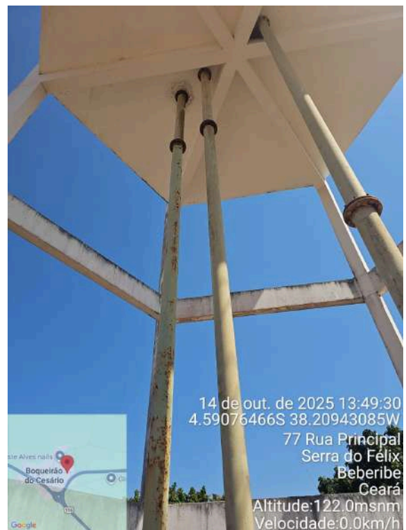
Foto 79 - REL-02 (Serra do Félix): oxidação na tubulação.
