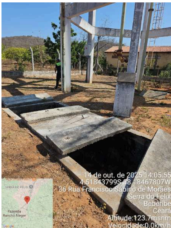
Foto 69 - REL-01 (Serra do Félix): tampas deslocadas, sem fechamento adequado.
