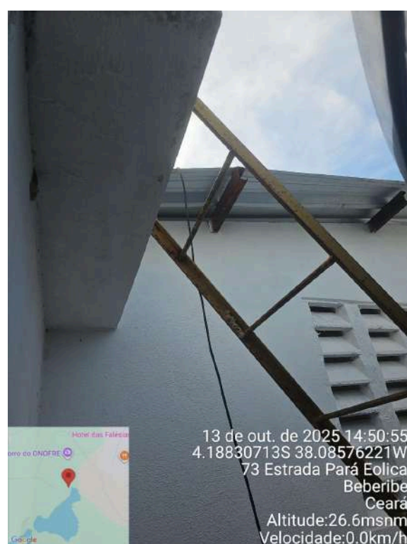
Foto 2 - Captação (Sede): fiação e escada inadequadas.
