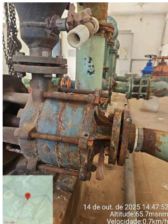
Foto 103 - ETA (Serra do Félix): madeira estancando furo no registro com vazamento, tubulação oxidada.
