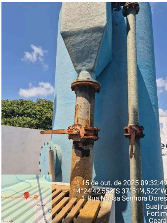
Foto 53 - ETA (Parajuru): Filtros com tubulação oxidada e com tinta descascando.
