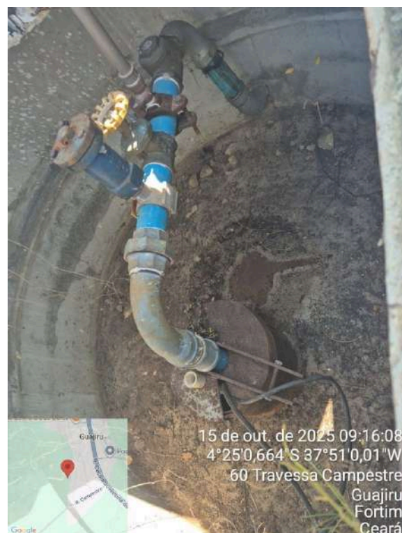
Foto 48 - Poços (Parajuru): Poço 6 com tampa e estrutura interna oxidadas.
