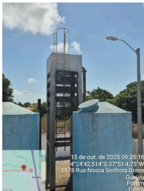
Foto 52 - ETA (Parajuru): Aerador com tubulação, estrutura e escada oxidados.
