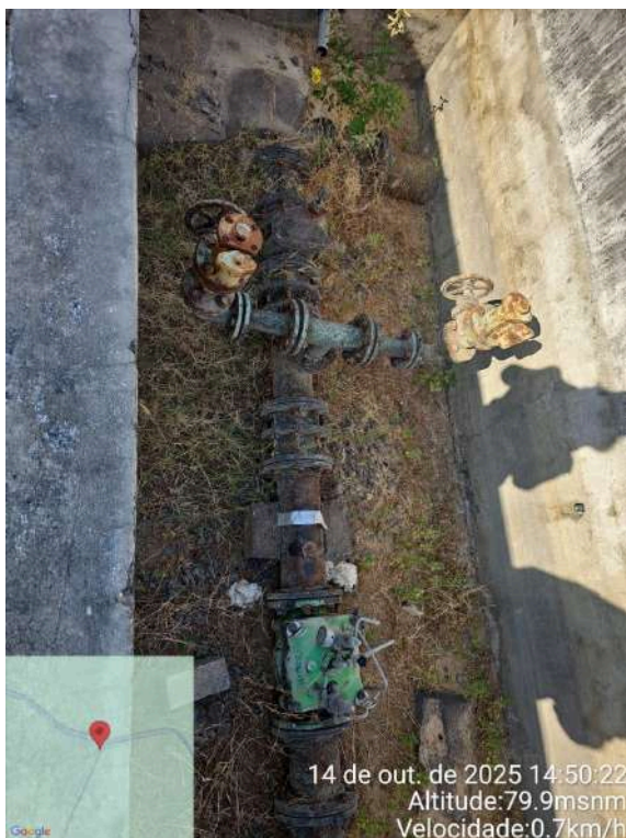
Foto 95 - ETA (Serra do Félix): vazamento severo na tubulação oxidada com furo vedado com fita.
