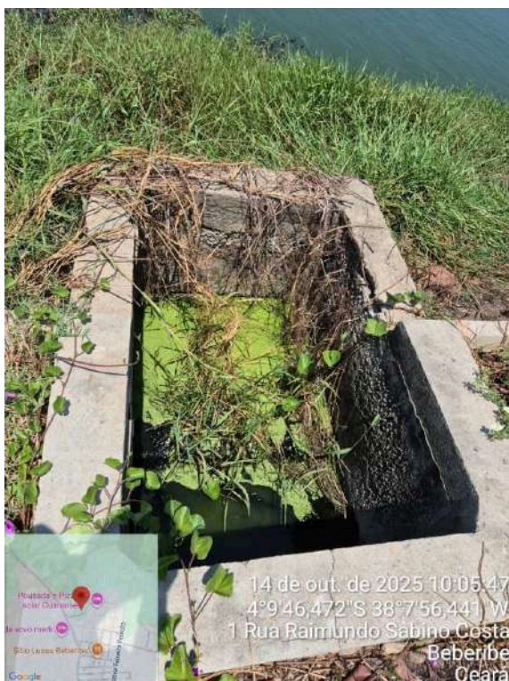
Foto 112 - ETE Sítio Lucas: Lagoa 2 com caixa com acúmulo de vegetação.
