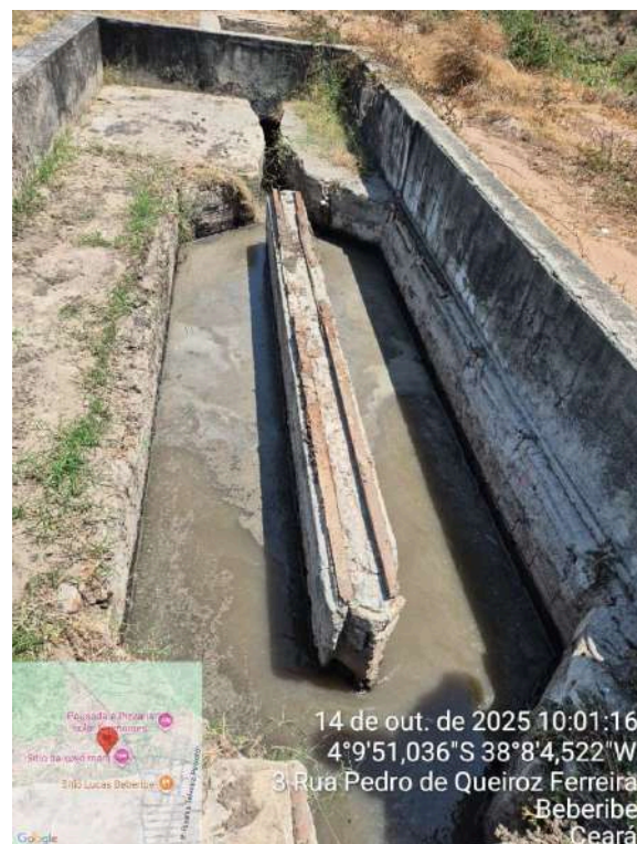
Foto 109 - ETE Sítio Lucas: estrutura desgastada e com armadura exposta
