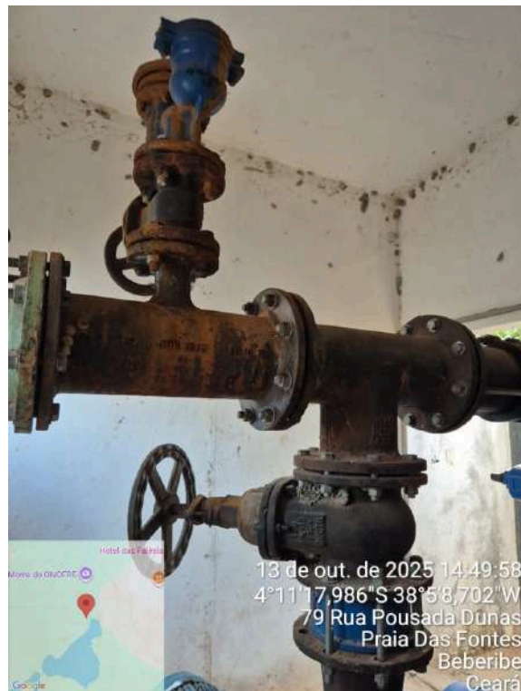
Foto 8 - Captação (Sede): tubulação oxidada.
