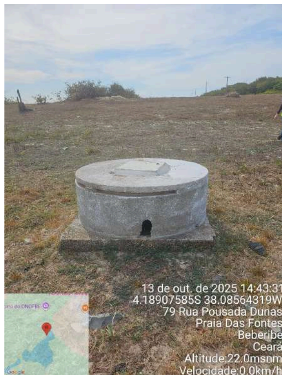
Foto 20 - Poços (Sede): PT sem identificação com abertura na base inadequada.
