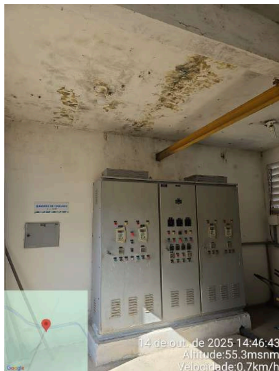
Foto 92 - ETA/Casa de comando (Serra do Félix): teto com mofo e iluminação precária.
