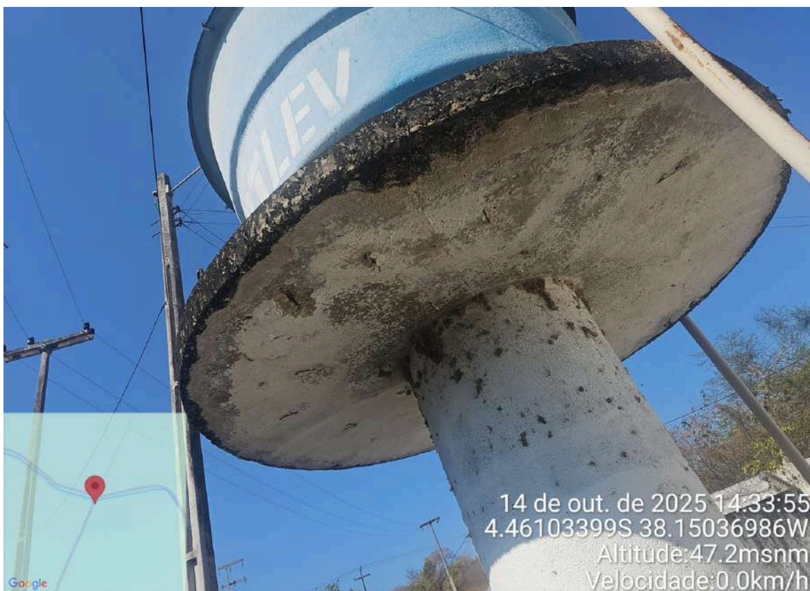
Foto 97 - ETA (Serra do Félix): caixa d'água sem escada de acesso e base desgastada com armadura aparente.
