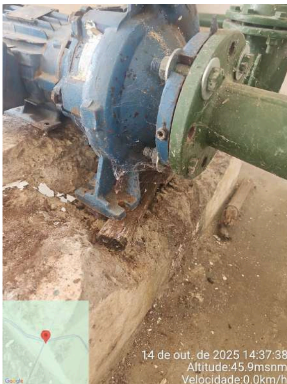
Foto 102 - ETA (Serra do Félix): bomba com base degradada, com madeira de apoio.
