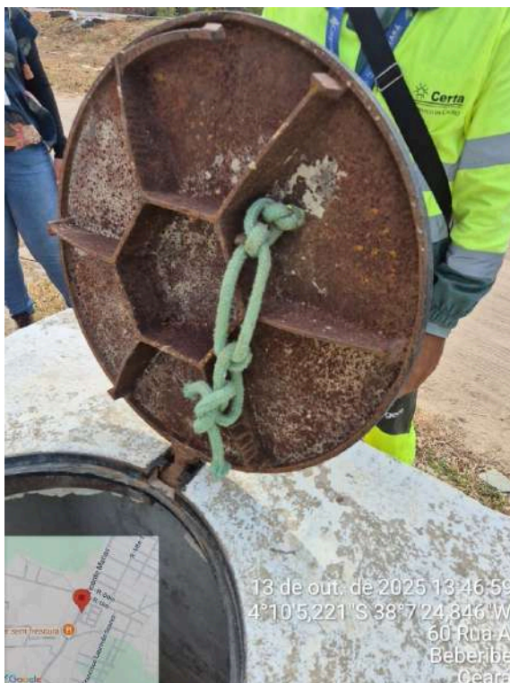
Foto 17 - Poços (Sede): PT-19 com tampa oxidada.
