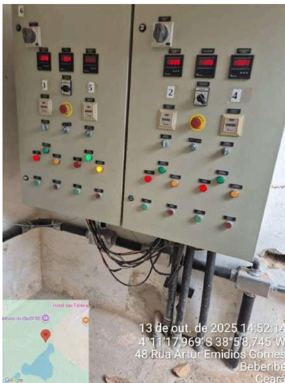
Foto 3 - Captação (Sede): painéis com fiação sem eletrodutos.
