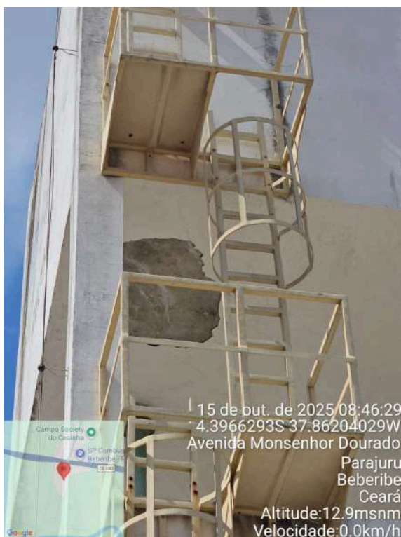
Foto 36 - REL-01 (Parajuru): fundo do reservatório desgastado.
