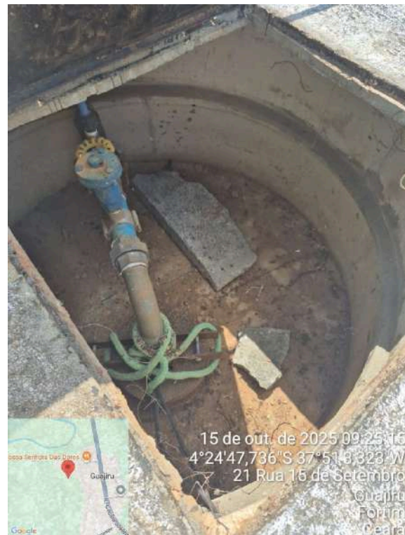
Foto 42 - Poços (Parajuru): Poço 2 com tampa e estrutura interna oxidadas.
