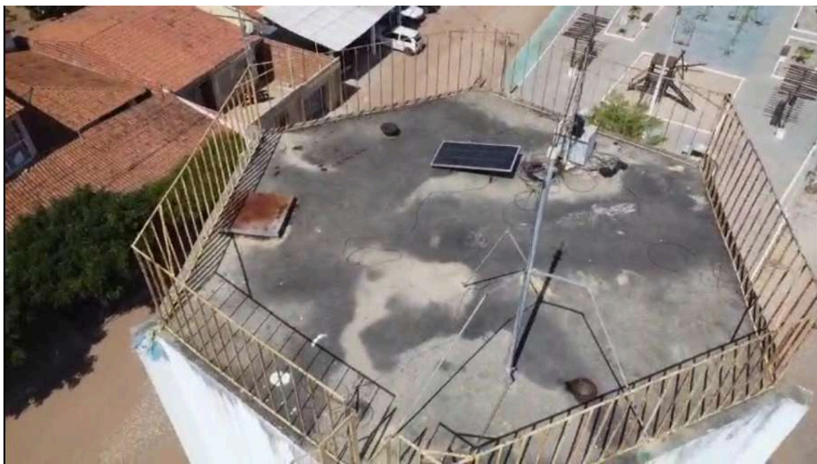
Foto 82 - REL-02 (Serra do Félix): tampa e guarda-corpo oxidados.
