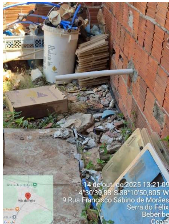
Foto 62 - Almojarifado (Serra do Félix): tubulação de saída da pia do banheiro sem encanamento adequado.
