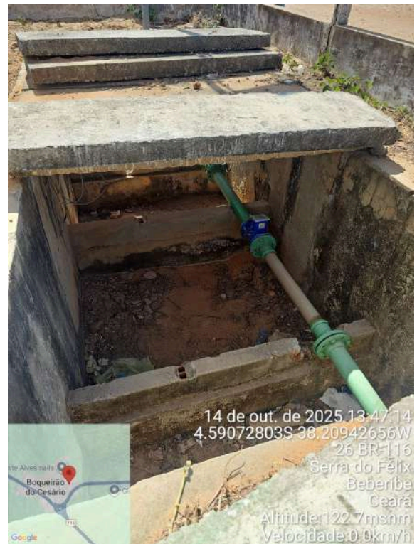
Foto 77 - REL-02 (Serra do Félix): caixa do macromedidor aberta, com fiação solta.
