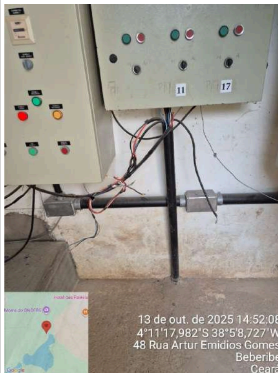
Foto 4 - Captação (Sede): painéis com fiação sem eletrodutos.
