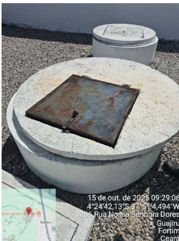
Foto 39 - Poços (Parajuru): Poço 1 com tampa e estrutura interna oxidadas.
