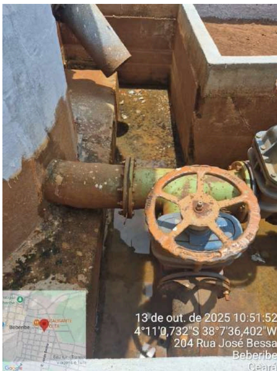
Foto 27 - ETA (Sede): tubulações dos filtros oxidadas.
