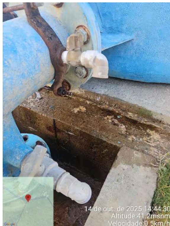
Foto 96 - ETA (Serra do Félix): filtro com vazamento no registro.
