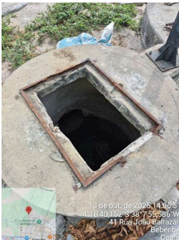
Foto 122 - EEE-01: PV sem tampa, com estrutura ao redor oxidada.
