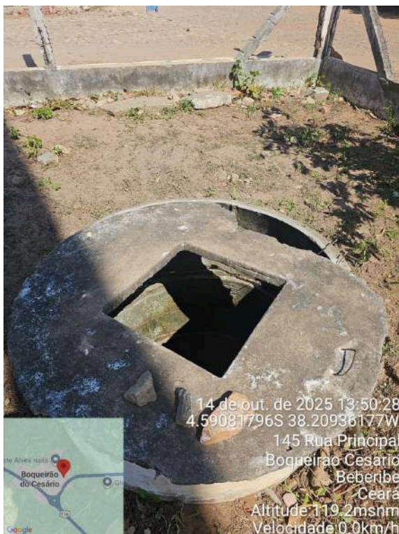
Foto 80 - REL-02 (Serra do Félix): poço sem vedação e utilização.
