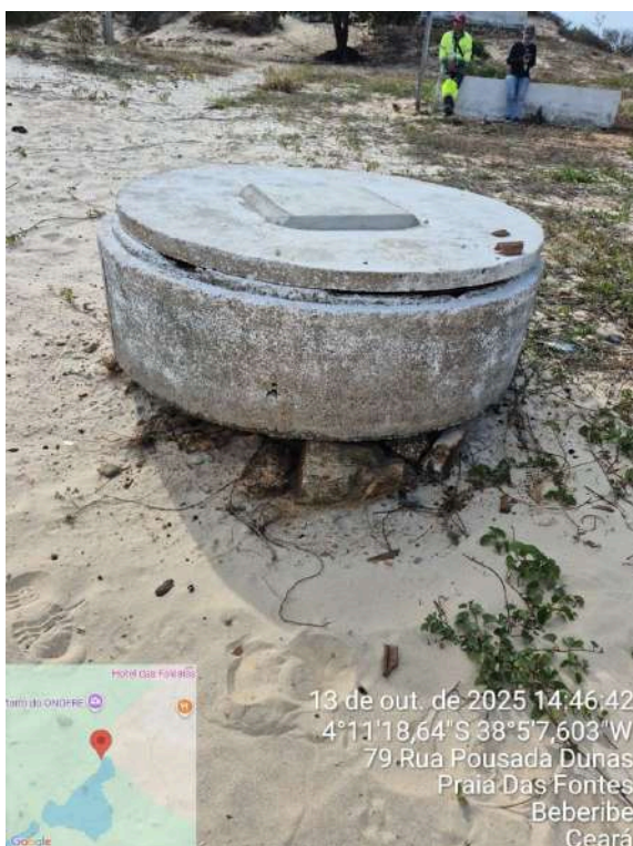
Foto 13 - Poços (Sede): PT-16 com base inadequada, com pedras de apoio.
