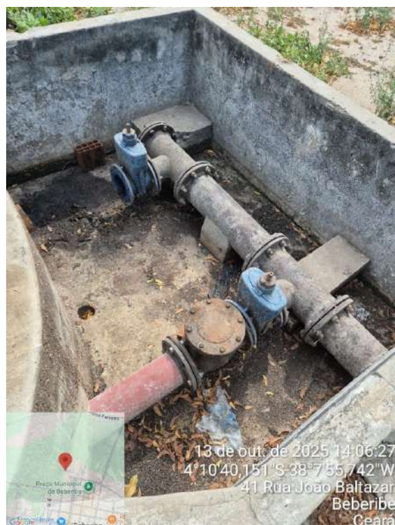
Foto 125 - EEE-01: bomba oxidada e sem reserva.
