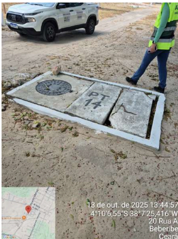
Foto 19 - Poços (Sede): PT-14 com tampa quebrada.
