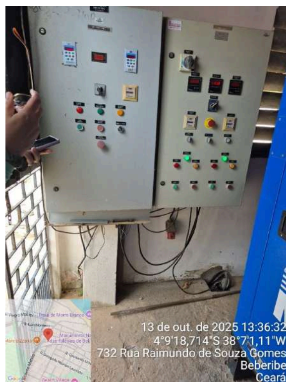
Foto 137 - EEE-03: fiação do painel sem eletrodutos e adesivos de perigo.
