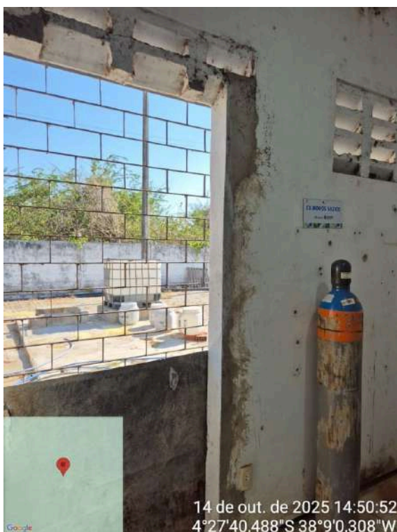
Foto 85 - ETA/Clorador (Serra do Félix): portão corroído e com parede desgastada.
