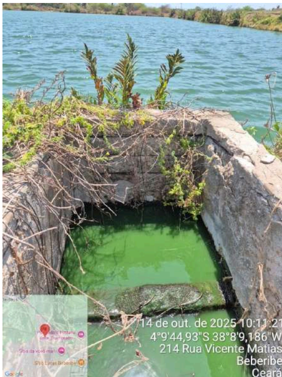
Foto 114 - ETE Sítio Lucas: Lagoa 3 com caixa com armadura exposta.
