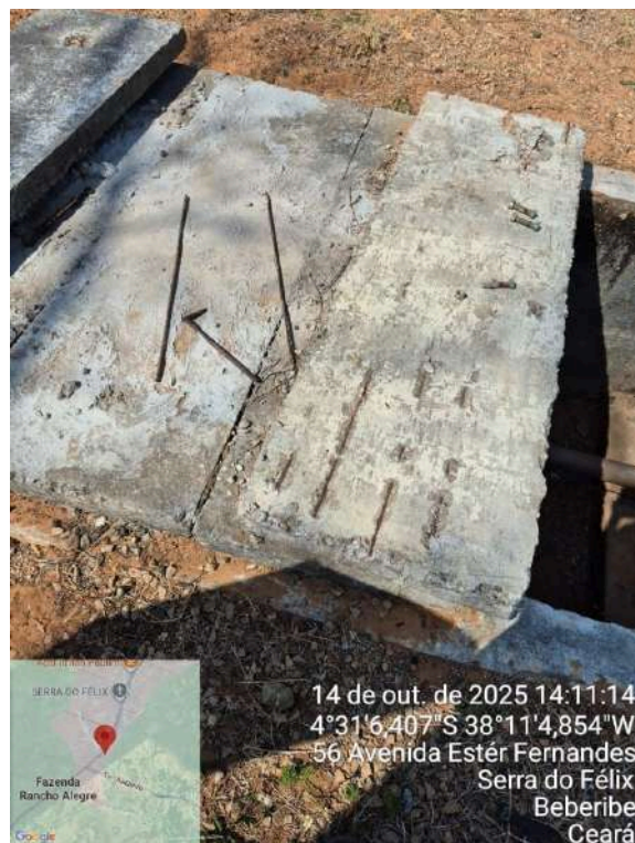
Foto 70 - REL-01 (Serra do Félix): tampas com armadura exposta.
