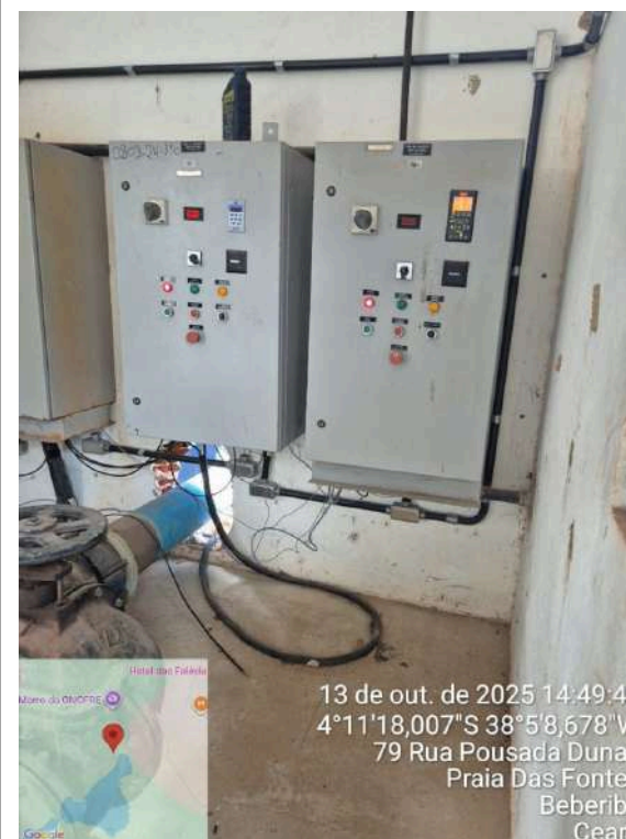
Foto 6 - Captação (Sede): painéis com fiação sem eletrodutos, abertura para tubulação da bomba na parede inadequada.
