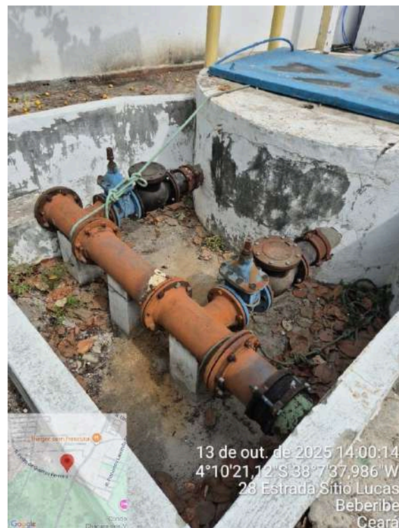
Foto 131 - EEE-02: tubulação oxidada e com pintura desgastada.
