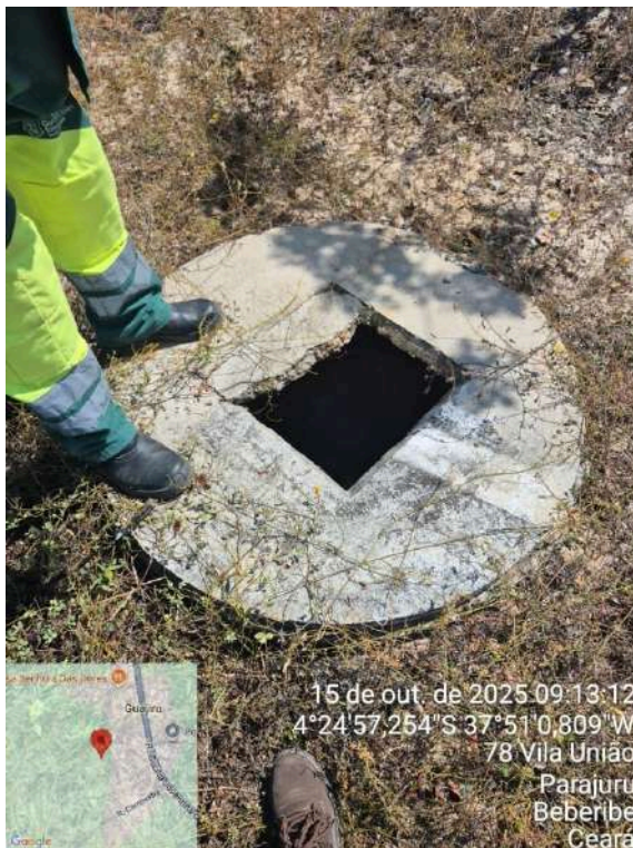
Foto 45 - Poços (Parajuru): Poço 5 sem tampa na proteção da bomba.
