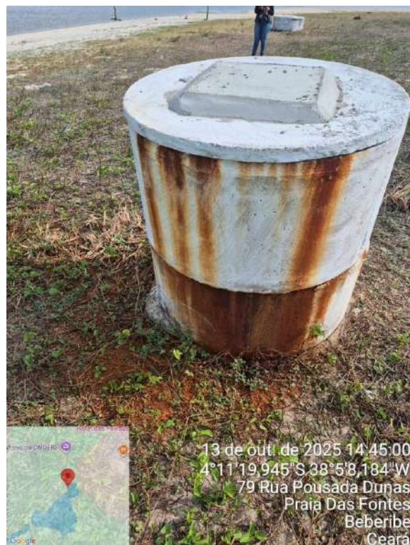
Foto 12 - Poços (Sede): PT-04 com presença de ferro.
