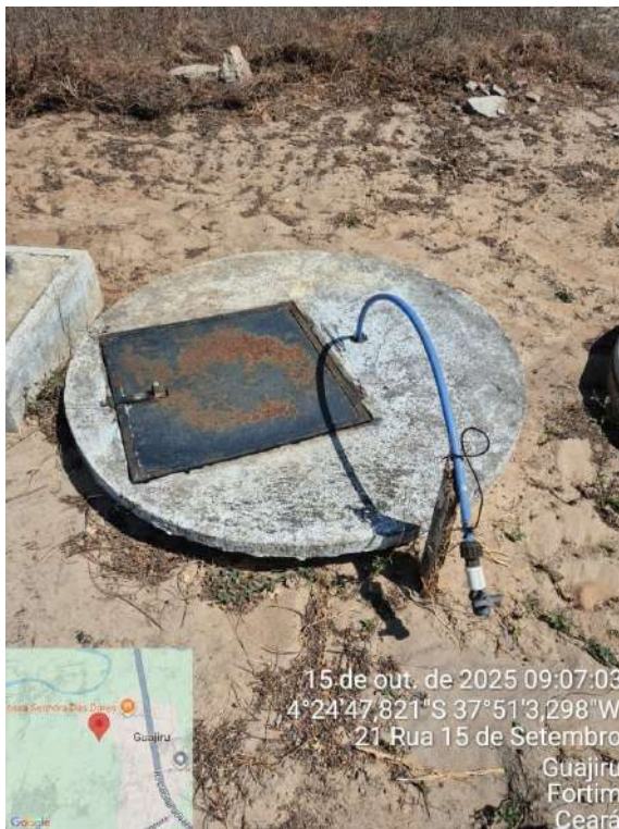
Foto 41 - Poços (Parajuru): Poço 2 com tampa e estrutura interna oxidadas.
