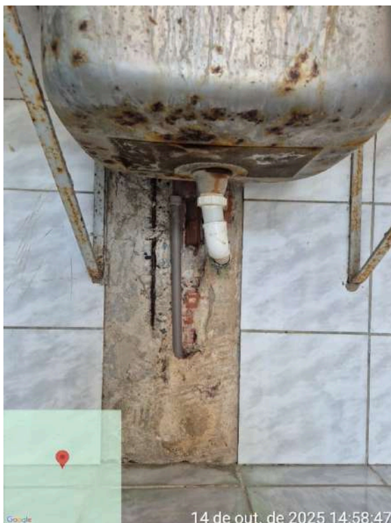
Foto 89 - ETA/Casa de química (Serra do Félix): pia com oxidação e parede com armadura exposta.
