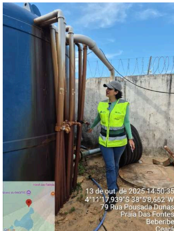
Foto 10 - Captação (Sede): tubulação da caixa d'água com manchas de ferro.
