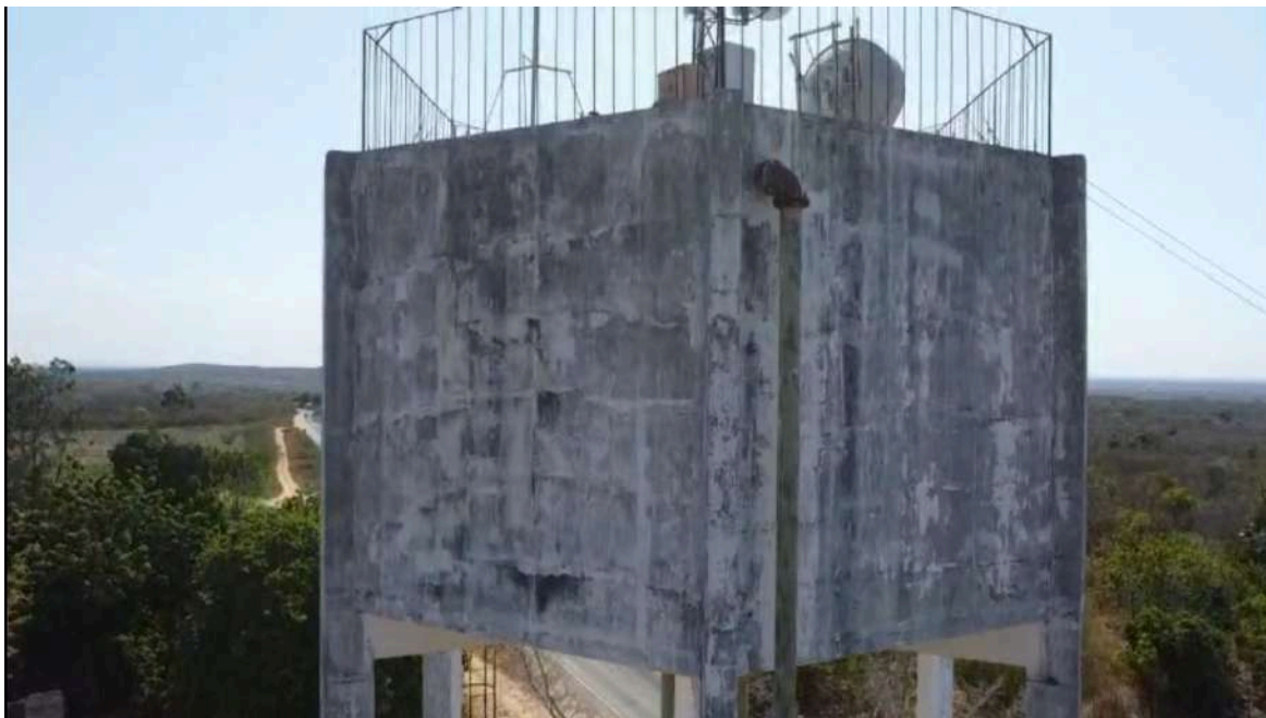
Foto 73 - REL-01 (Serra do Félix): pintura desgastada e tubulação com oxidação.
