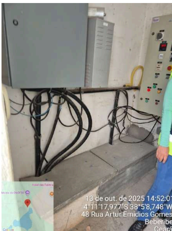
Foto 5 - Captação (Sede): painéis com fiação sem eletrodutos.
