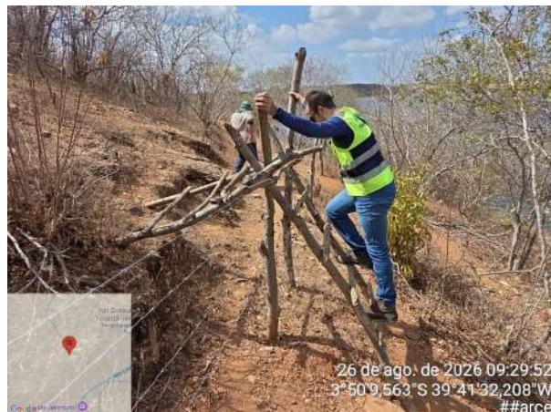
Foto 2 - Captação (Açude Jerimum): acesso operacional improvisado e rudimentar, instalado em terreno íngreme e irregular.
