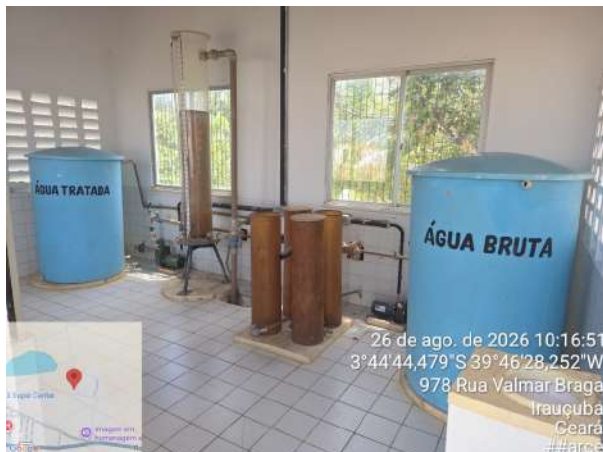
Foto 28 - ETA Piloto: desativada e mantida na área operacional, necessitando de desmobilização.
