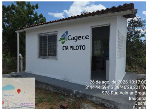
Foto 29 - ETA Piloto: desativada e mantida na área operacional, necessitando de desmobilização.
