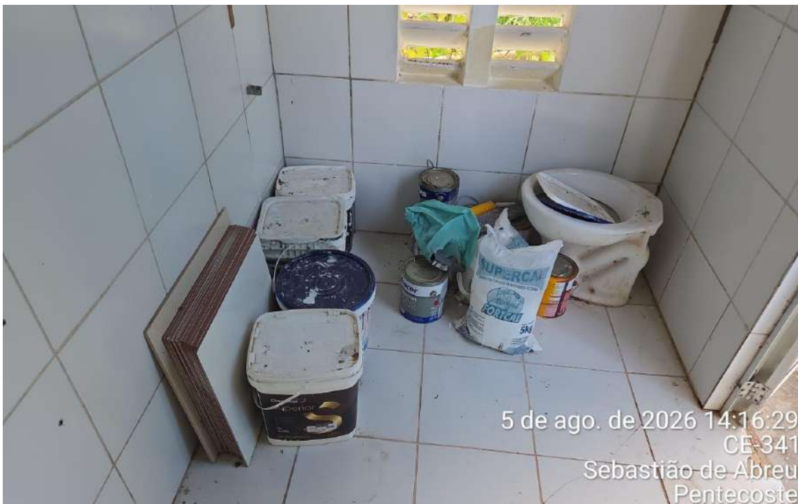
Foto 80 - ETA Sebastião de Abreu: presença de sujidades no piso, armazenamento inadequado de materiais de construção, recipientes de tinta e demais resíduos na fábrica de cloro desativada, comprometendo a higiene e a utilização do ambiente.
