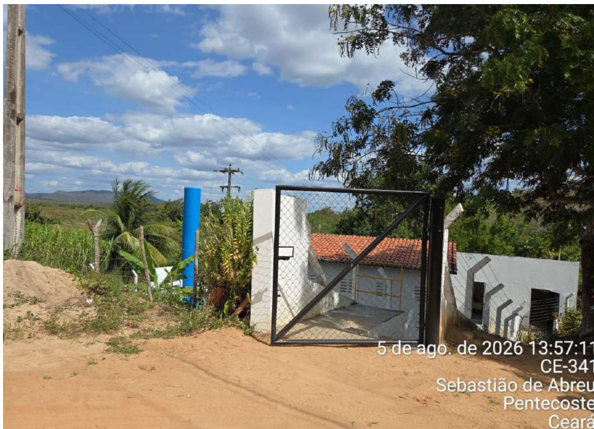
Foto 52 - ETA Sebastião de Abreu: ausência de identificação na área de acesso operacional.
