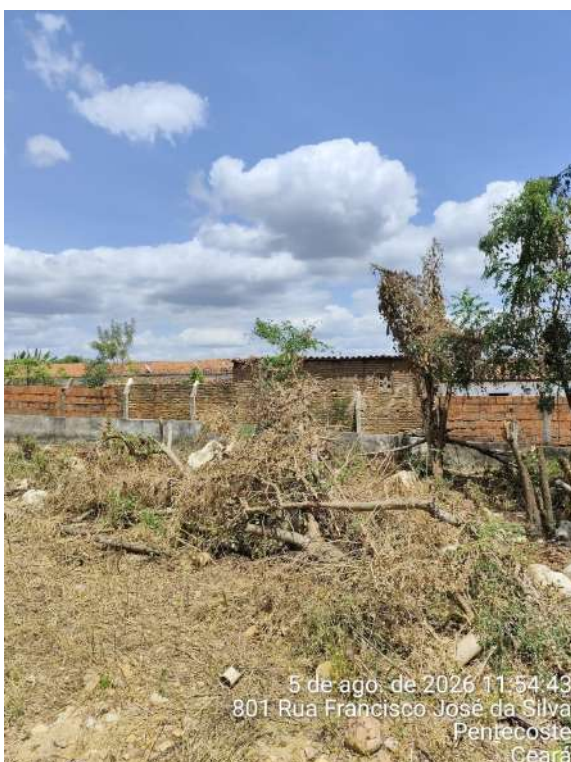
Foto 19 - REL-02 (Sede): terreno irregular, com acúmulo de resíduos sólidos, vegetação, entulho e materiais diversos.
