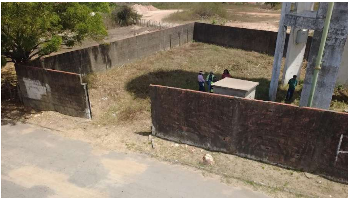
Foto 44 - REL-04 (Sede): acesso à área operacional sem fechamento adequado, não possuindo portão ou identificação.
