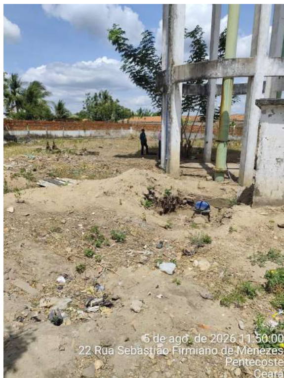
Foto 14 - REL-02 (Sede): terreno irregular, com acúmulo de resíduos sólidos, vegetação, entulho e materiais diversos.
