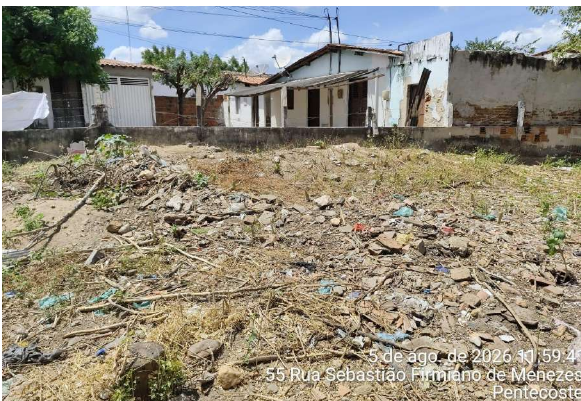
Foto 4 - REL-02 (Sede): acúmulo de resíduos sólidos, vegetação, entulho e materiais diversos no terreno, além de cercamento incompleto, com mourões danificados e isolamento de área deficiente. A disposição inadequada de resíduos no terreno representa risco à vizinhança.
