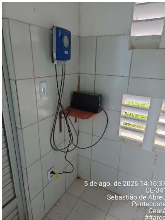
Foto 79 - ETA Sebastião de Abreu: fiação solta e desorganizada na fábrica de cloro desativada, com equipamento apoiado em suporte precário, além da presença de sujidades no piso.
