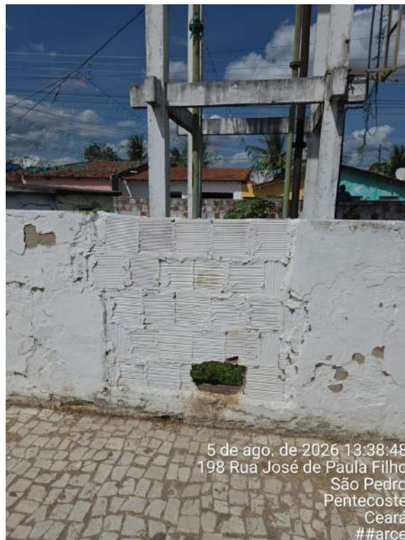
Foto 40 - REL-03 (Sede): muro de isolamento da área operacional com abertura na parte inferior.
