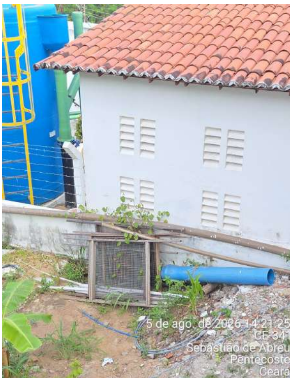
Foto 81 - ETA Sebastião de Abreu: armazenamento inadequado de materiais e tubulações, com presença de entulho e vegetação, comprometendo a organização e a segurança da área operacional.
