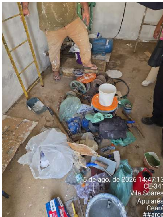
Foto 96 - RSE-02 (Sebastião de Abreu): acúmulo e armazenamento inadequado de materiais, peças e resíduos no piso, com obstrução da circulação e do acesso à área operacional.
