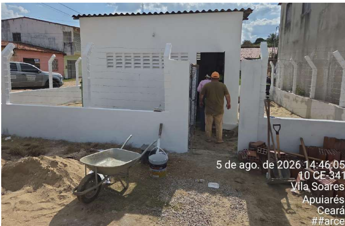
Foto 94 - RSE-02 (Sebastião de Abreu): acesso à unidade sem identificação.
