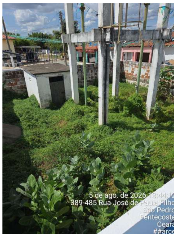
Foto 34 - REL-03 (Sede): presença de vegetação no interior da área operacional.
