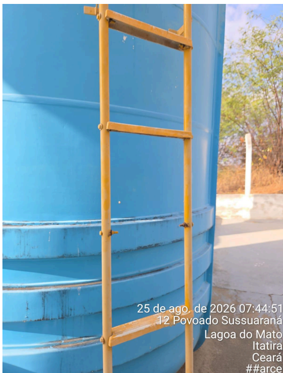
Foto 23 - Filtro 2 (ETA - Lagoa do Mato): escada de acesso com ausência de degrau e com sinais de corrosão, além de ausência de dispositivo adequado de proteção contra quedas.
