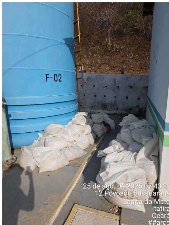
Foto 24 - Filtro 2 (ETA - Lagoa do Mato): sacos armazenados de forma inadequada na área operacional, obstruindo parcialmente a circulação e o acesso ao filtro.
