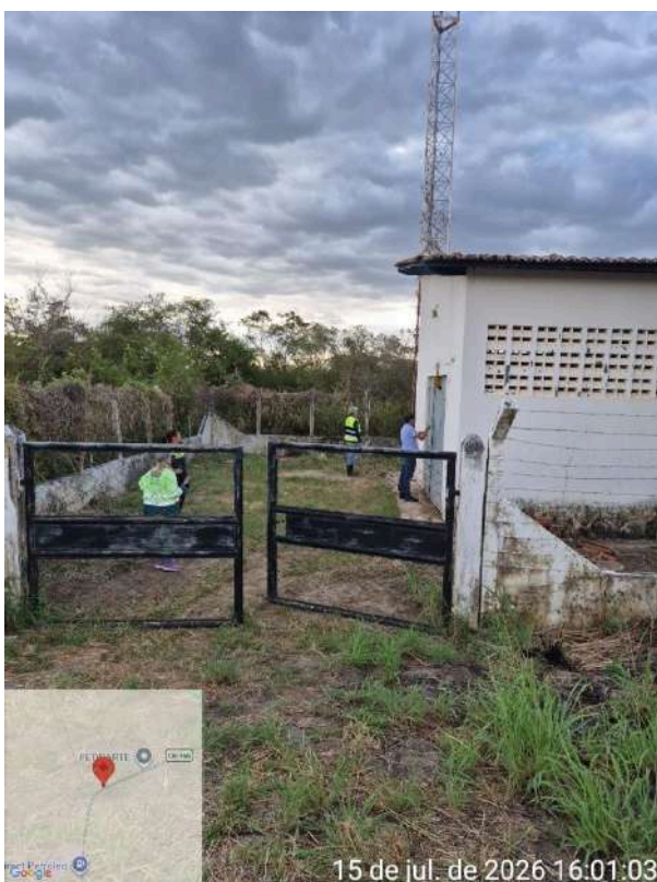
Foto 31 - EEAT-02 (Sítio Mororó): sem identificação; portão sem cadeado.
