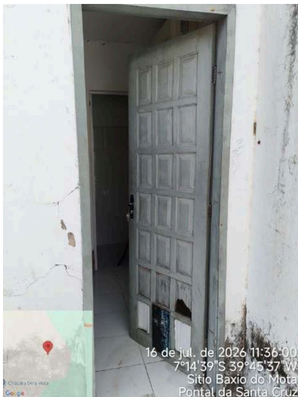
Foto 25 - ETA / Casa do Operador (Brejo Grande): sem identificação.
