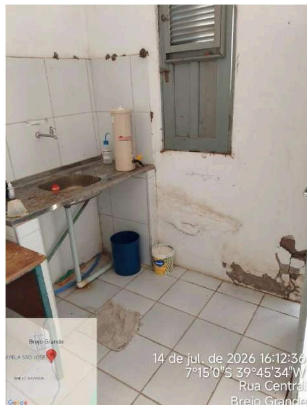
Foto 82 - Núcleo (Brejo Grande): laboratório com pia em processo avançado de oxidação.
