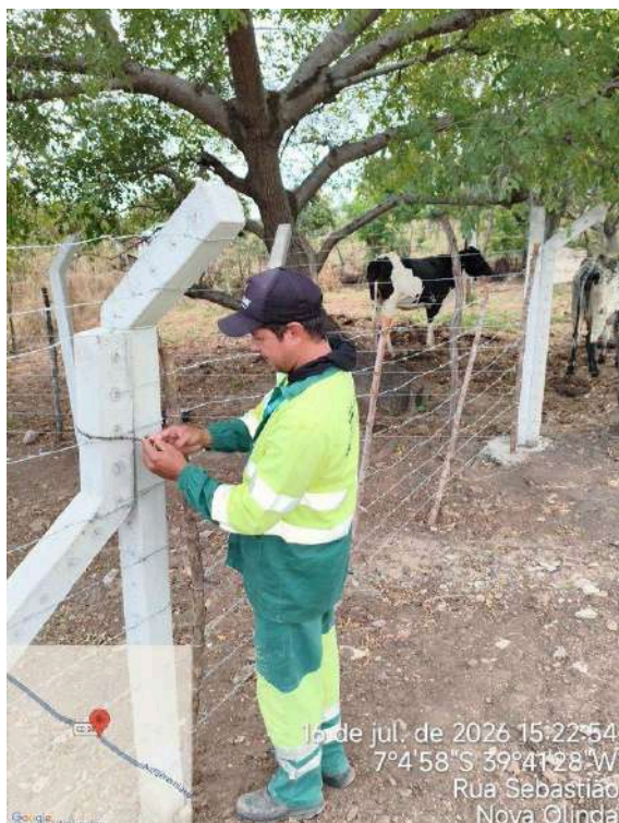
Foto 13 - PT-12 (Sede): portão de acesso precário, do tipo improvisado.
