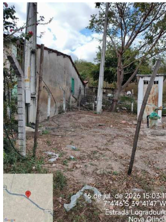
Foto 10 - PT-10 (Sede): ausência de identificação; portão de acesso precário.
