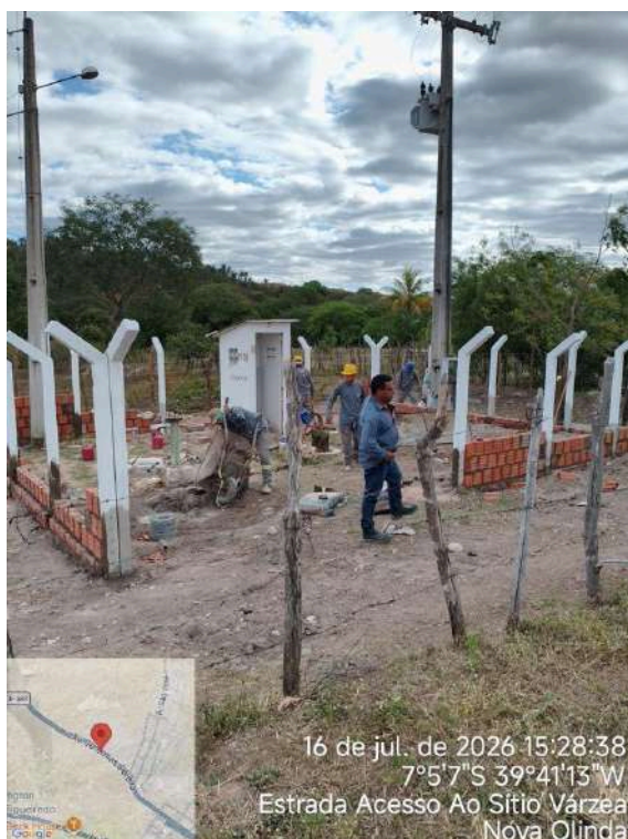
Foto 15 - PT-08 (Sede): unidade em obras.
