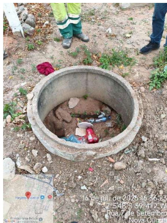
Foto 65 - PT-07 (Sede): caixa de descarga com registro soterrado.
