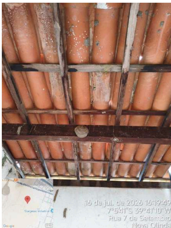
Foto 27 - PT-03 (Sede): ausência de iluminação interna.
