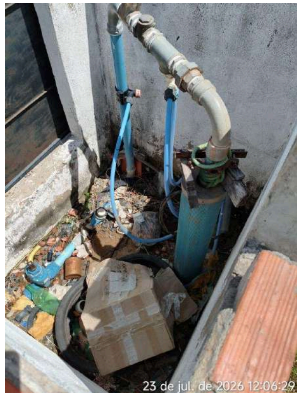
Foto 37 - PT-06: Caixa de proteção do poço danificada, com acúmulo de resíduos sólidos.
