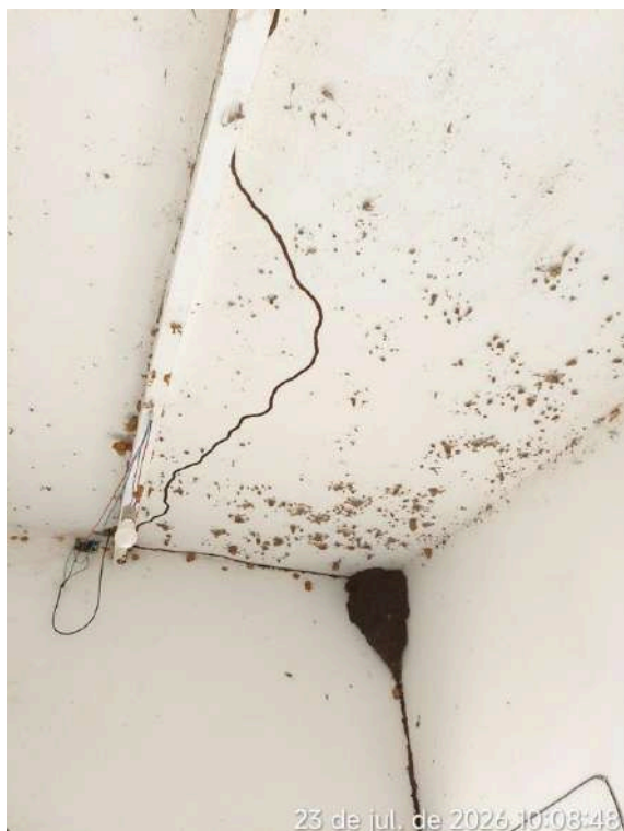
Foto 3 - Captação: instalações elétricas precárias, sem isolamento; proliferação de cupins.
