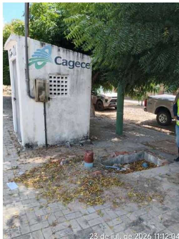
Foto 15 - PT-01: unidade desativada, sem desmobilização total.
