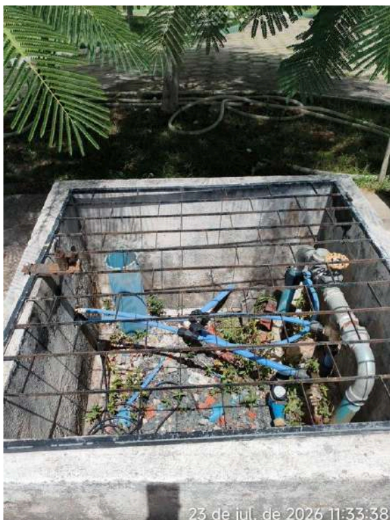
Foto 18 - PT-03: unidade desativada e tubo do poço sem tamponamento.
