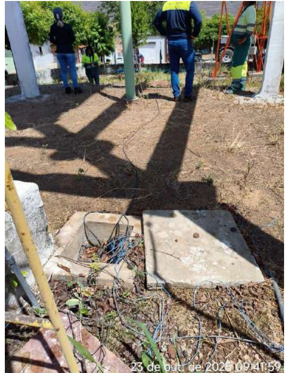
Foto 10 - REL-01: caixa de passagem elétrica com fios / cabos expostos.
