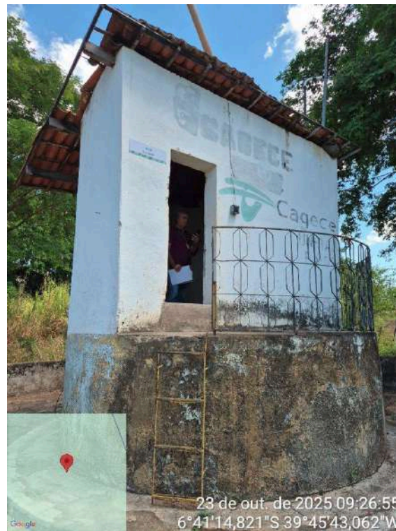
Foto 19 - Casa do Quadro de Comando: pintura, escada de acesso e grade de proteção danificadas; estrutura do telhado apresenta danos estruturais e presença de cupim.
