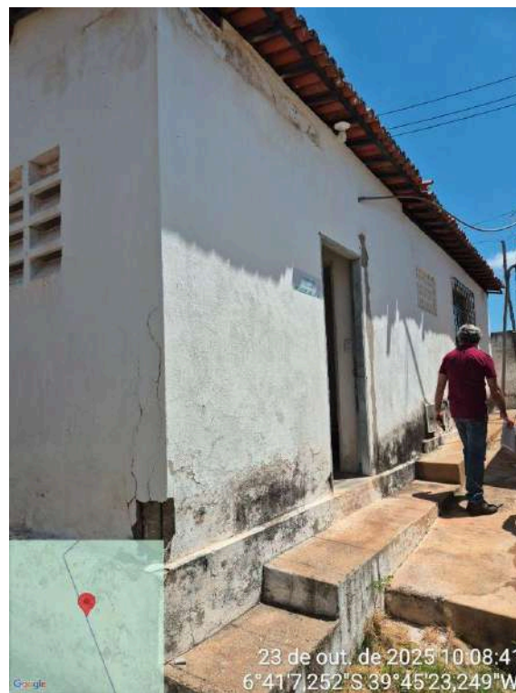
Foto 32 - ETA / Laboratório e Casa de Química: pintura desgastada e anomalia estrutural com ferragem exposta.
