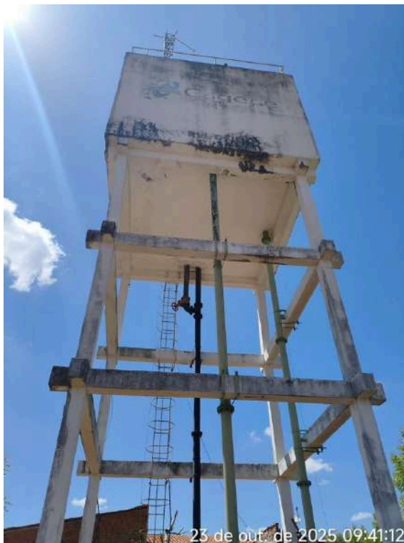
Foto 25 - REL-01: reservatório com pintura e identificação desgastadas e apresentando vazamentos.
