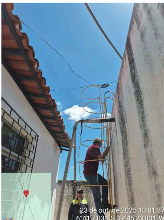
Foto 7 - RAP-01: pintura desgastada; sem guarda corpo na laje de cobertura e fiação instalada fixa à escada.
