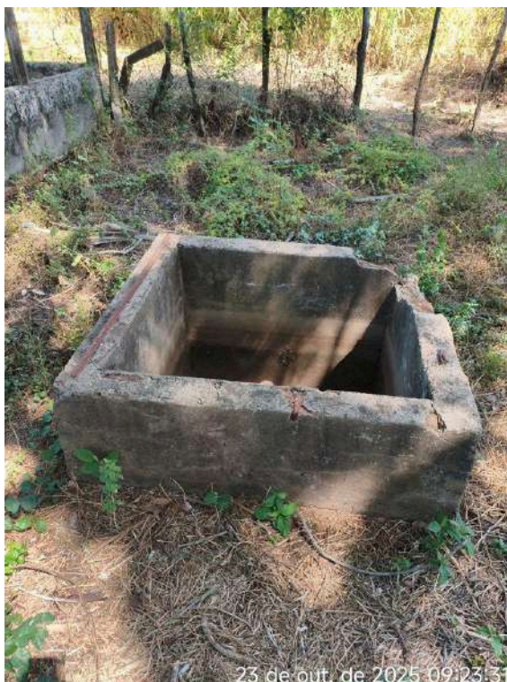
Foto 3 - Área da Captação: caixa deteriorada e sem tampa.
