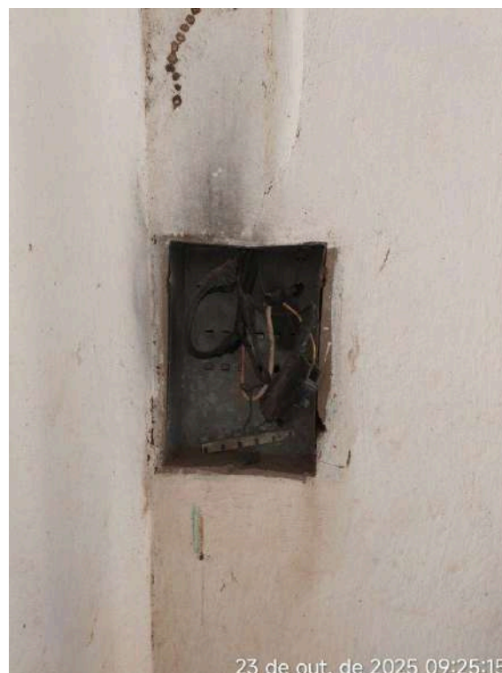
Foto 21 - Casa do Quadro de Comando: instalações elétricas precárias, caixa de disjuntor sem tampa e fiação exposta.
