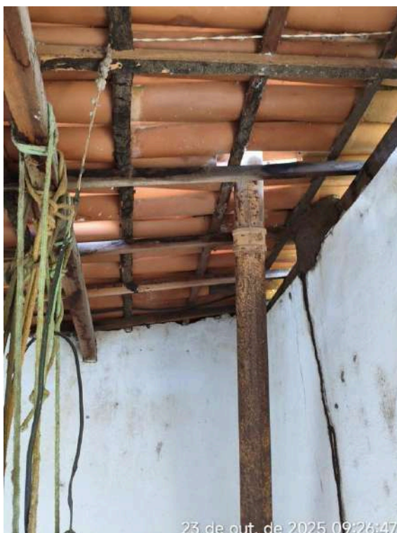
Foto 20 - Casa do Quadro de Comando: a estrutura do telhado apresenta danos estruturais e presença de cupim.
