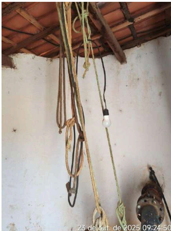
Foto 1 - Casa do Quadro de Comando: instalações elétricas e de iluminação precárias, com iluminação improvisada.
