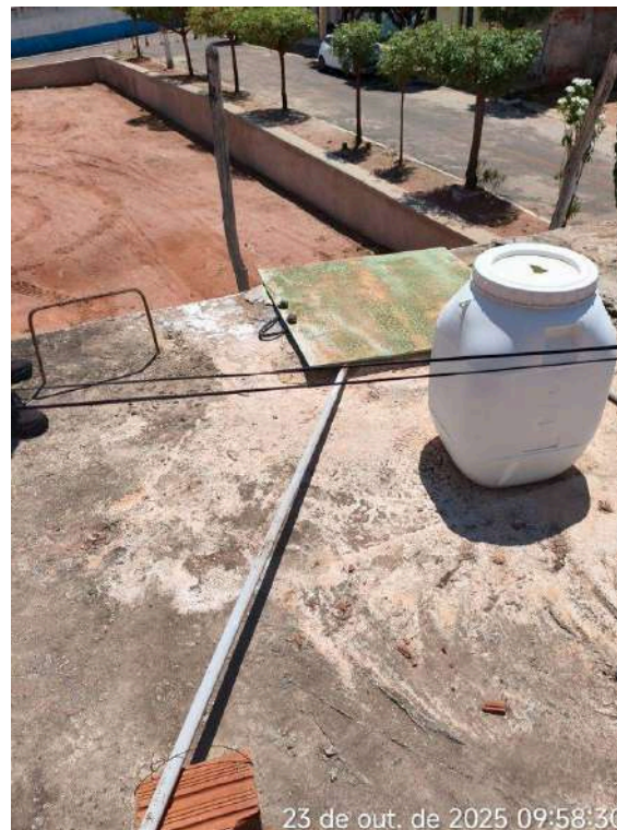
Foto 6 - RAP-01: tubulação instalada pela abertura de inspeção e fiação elétrica baixa sobre o reservatório.
