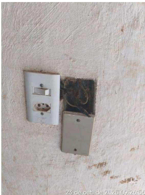
Foto 22 - Casa do Quadro de Comando: instalações elétricas precárias, caixa de passagem com fiação exposta.
