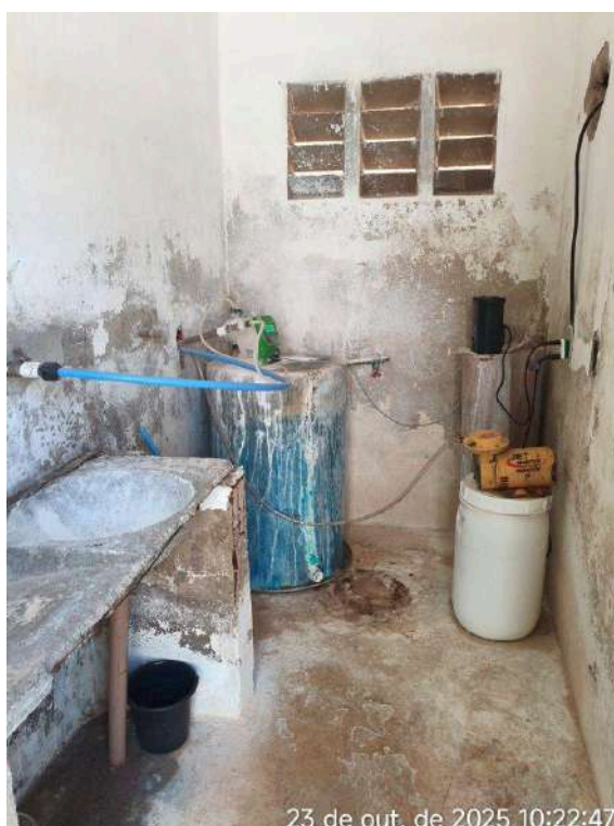
Foto 14 - ETE / Casa de cloro: apresenta instalações precárias na parte hidráulica.
