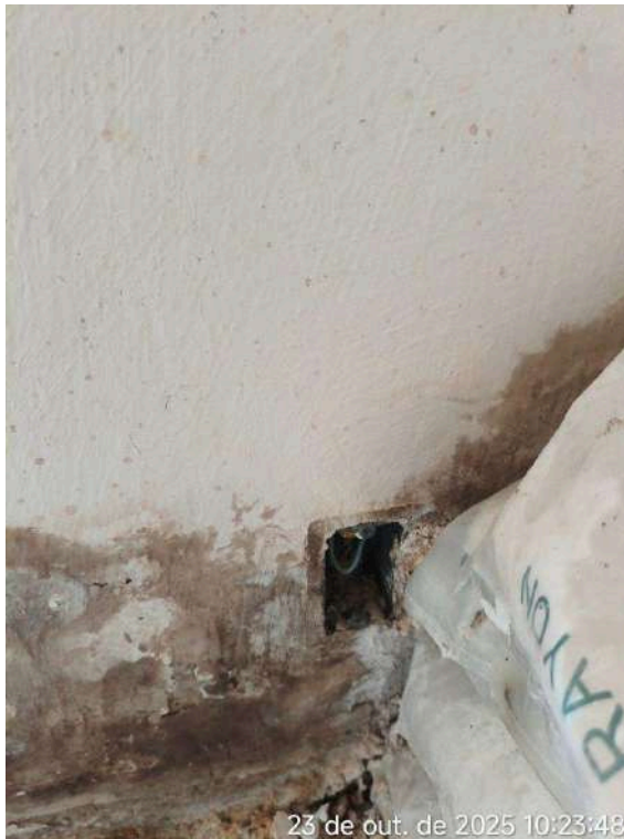
Foto 16 - Casa de cloro: apresenta instalações precárias na parte elétrica.
