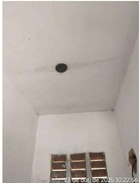
Foto 17 - Casa de cloro: ausência de lâmpada.
