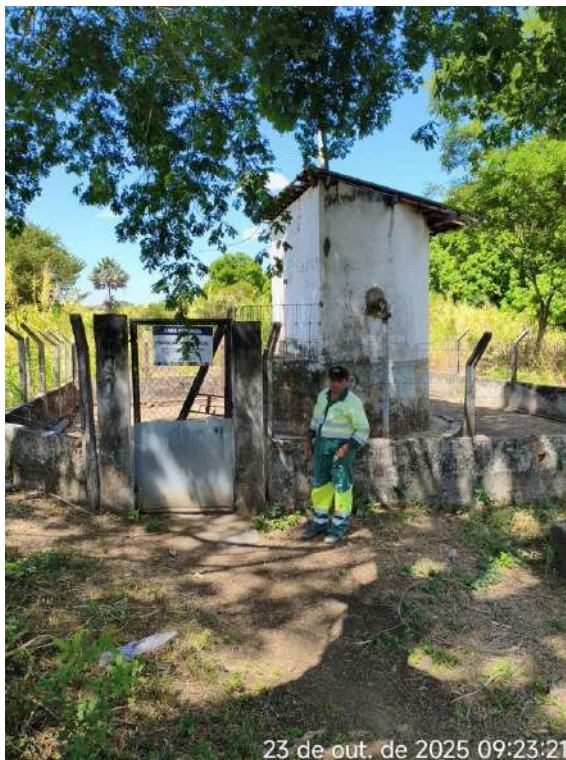
Foto 18 - Casa do Quadro de Comando: cerca e pintura deterioradas.
