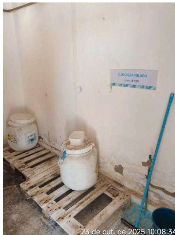
Foto 34 - ETA / Casa de Química: pintura desgastada e reboco deteriorado.
