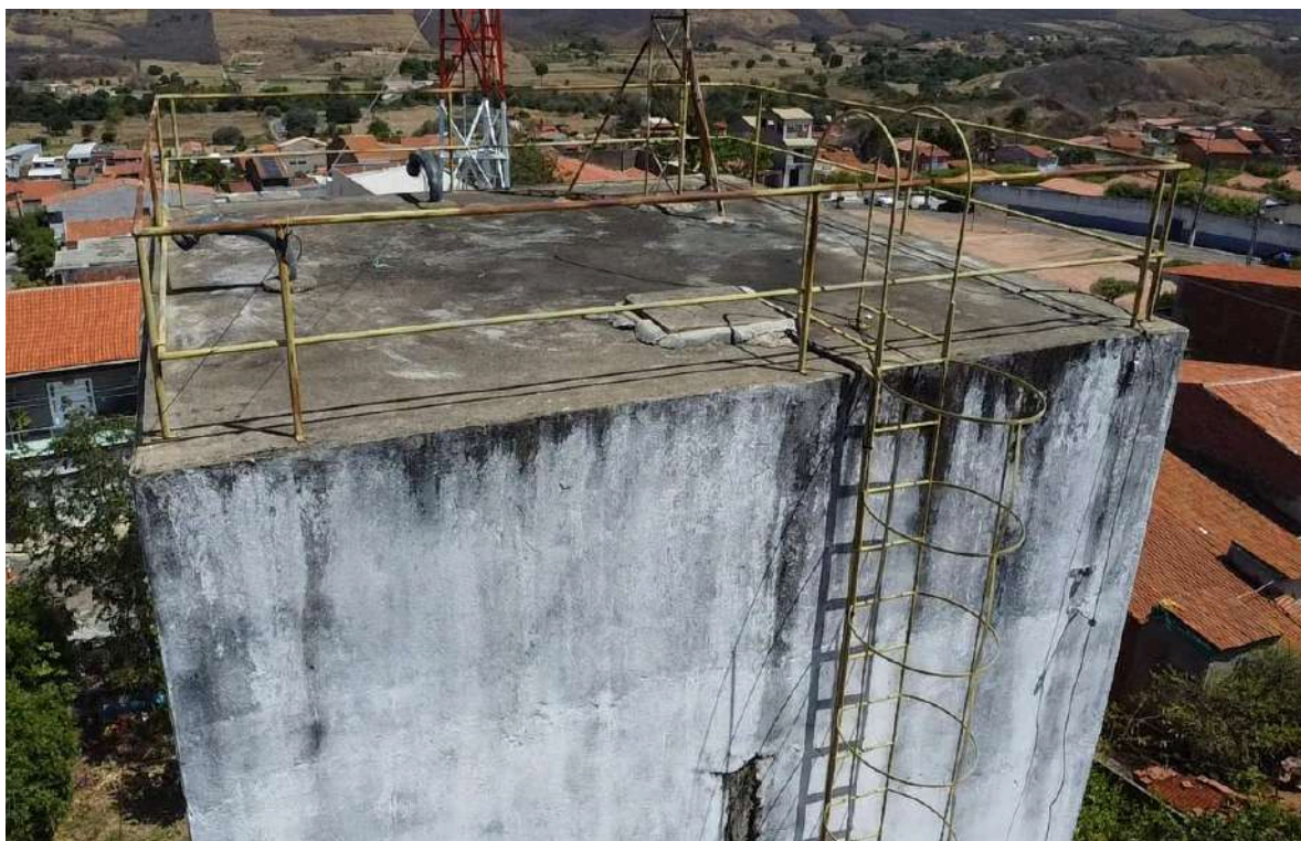
Foto 13 - REL-01: a escada de acesso tem gaiola de proteção incompleta (abaixo do corrimão de apoio) e o guarda-corpo obstrui a passagem de acesso a laje de cobertura.
