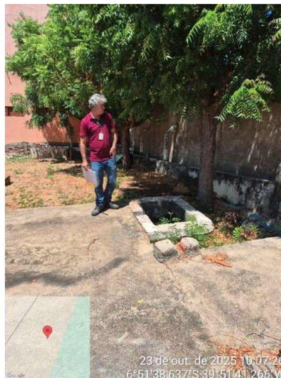
Foto 4 - ETA: caixa de proteção sem tampa no pátio na área de circulação.
