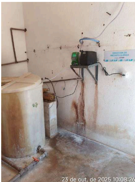
Foto 33 - ETA / Casa de Química: pintura desgastada e reboco deteriorado.
