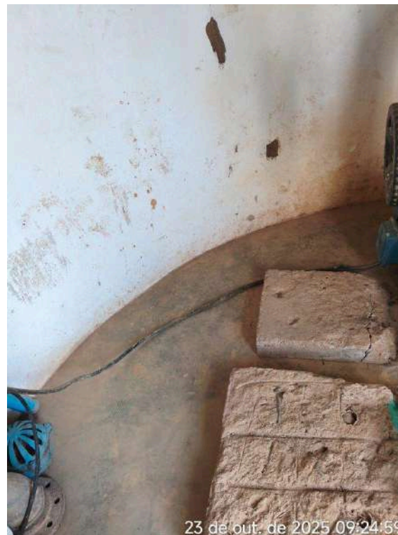
Foto 2 - Casa do Quadro de Comando: instalações elétricas precárias, com fiação sobre o solo, sem eletrodutos de isolamento e proteção.
