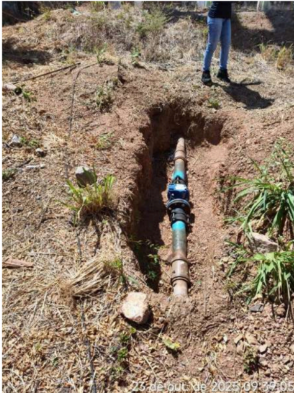
Foto 9 - REL-01: macromedidor sem caixa de proteção.
