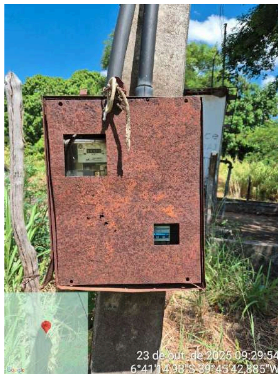
Foto 23 - Área da Captação: caixa do quadro de energia em processo de corrosão.
