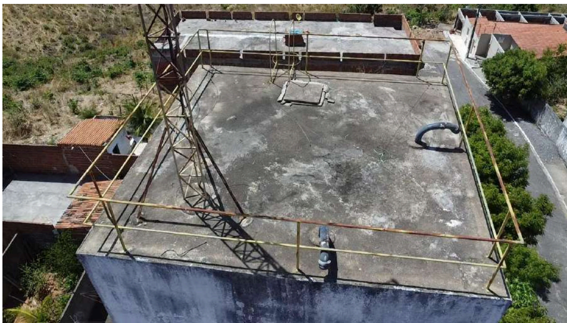
Foto 24 - REL-01: reservatório com pintura e identificação desgastada; guarda corpo da cobertura está em processo de corrosão.
