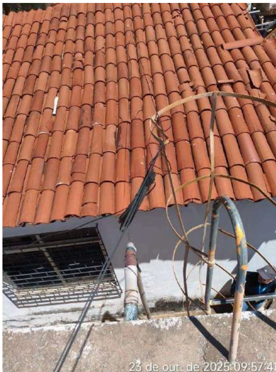
Foto 5 - RAP-01: sem guarda corpo na laje de cobertura; fiação elétrica baixa sobre o reservatório e fios/cabos presos a estrutura da escada.
