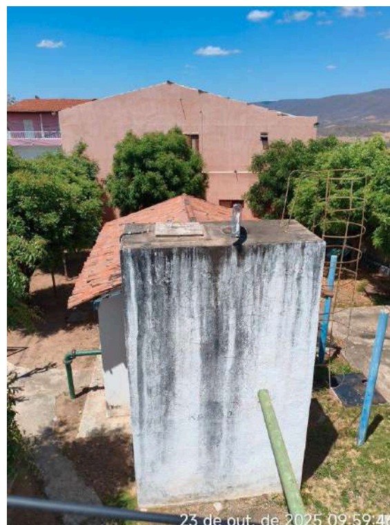
Foto 8 - RAP-02: sem guarda corpo acima do patamar superior ou laje de cobertura e pintura desgastada.
