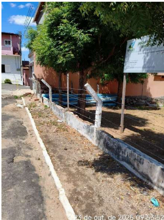
Foto 29 - ETA / Pátio: cerca e mureta danificadas.
