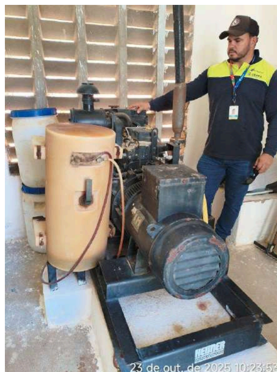
Foto 36 - Grupo gerador: está fora de funcionamento e o local é utilizado para armazenamento de materiais diversos.
