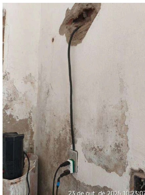
Foto 15 - ETE / Casa de cloro: apresenta instalações precárias na parte elétrica.
