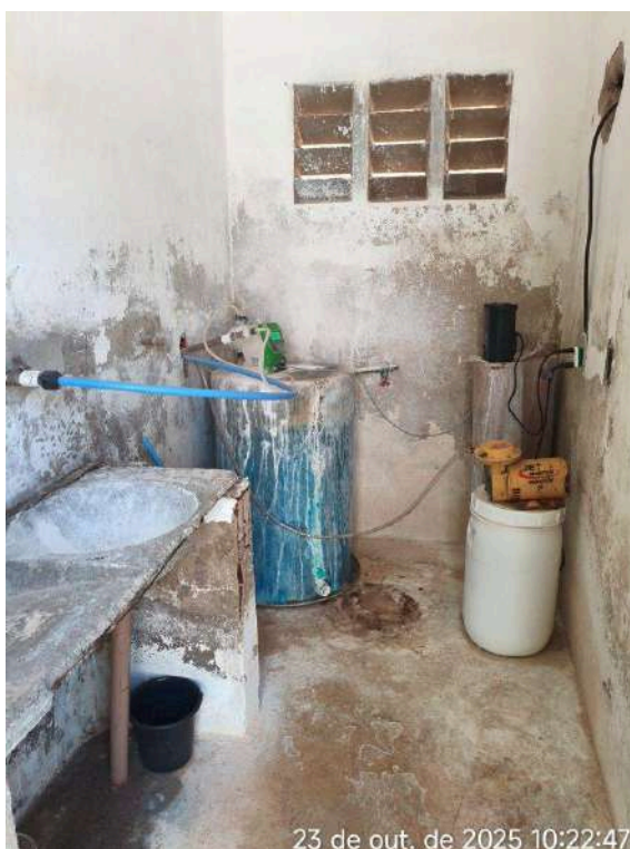
Foto 35 - ETE / Casa de cloro: apresenta reboco e pintura deteriorados.
