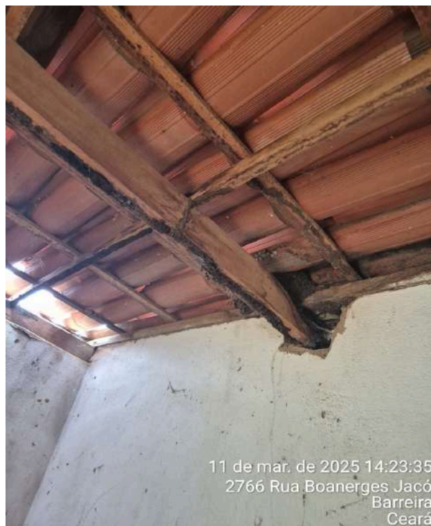
Foto 34 - RSE-02 / RSE-03 (Batalha / Cajueiro): casa da bomba em péssimo estado de conservação, com rachaduras na parede e madeira tomada por cupim.
