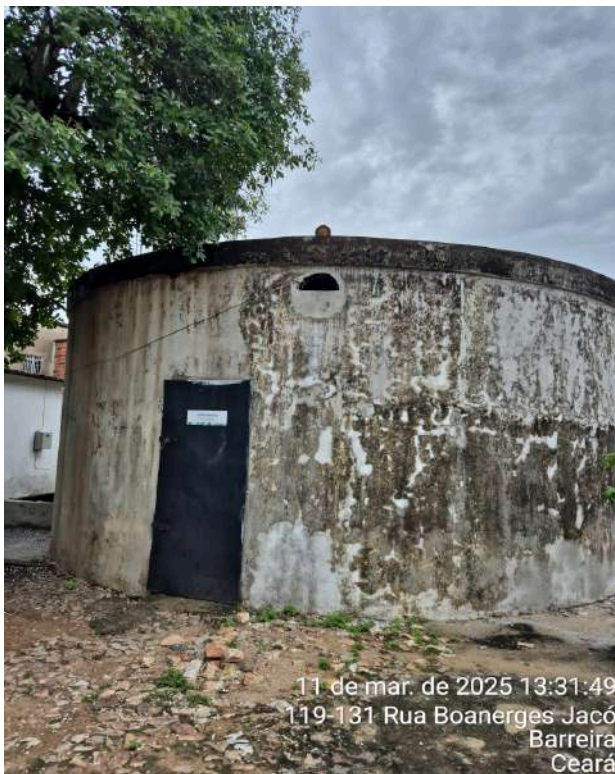
Foto 9 - RAP-14 (Sede): almojarifado funcionando dentro do RAP e apresentando falhas estruturais principalmente do lado externo.
