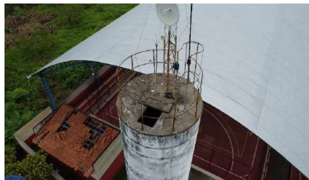
Foto 46 - REL-03 (Lagoa Grande): apresenta pintura deteriorada, sem vedação hermética (ausência ou deslocamento de tampas) e guarda-corpos corroídos.
