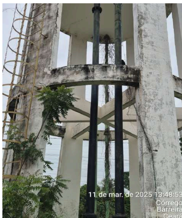
Foto 23 - REL-02 (Córrego): Reservatório com aspecto deteriorado, vegetação abundante, interferindo no acesso e nas estruturas, vegetação ao redor da tubulação, notadamente na tubulação de saída do tanque de reservação.
