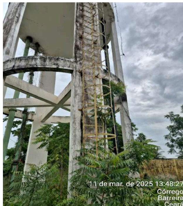
Foto 22 - REL-02 (Córrego): Reservatório com vegetação abundante, interferindo no acesso e nas estruturas, vegetação ao redor da tubulação, notadamente na tubulação de saída do tanque de reservação.
