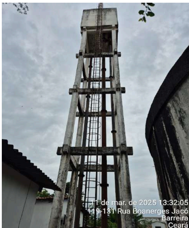
Foto 19 - REL-01 ( Sede ): falhas estruturais principalmente.
