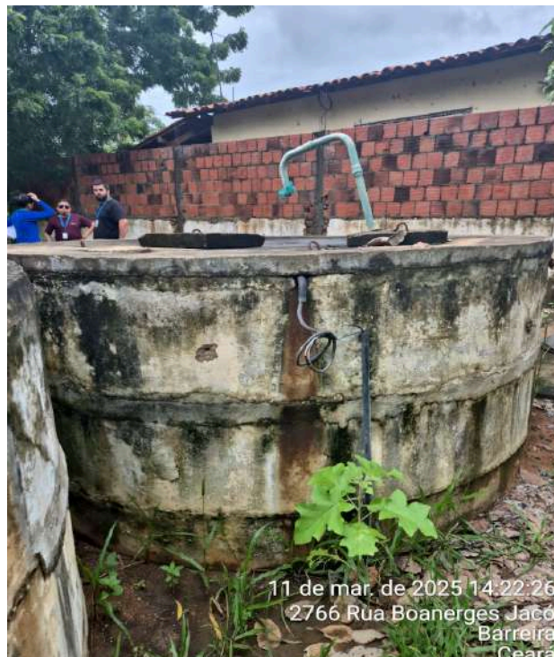
Foto 30 - RSE-02 / RSE-03 (Batalha / Cajueiro): estrutura em péssimo estado de conservação; restos de demolição ao redor, oferecendo risco físico aos trabalhadores e eventuais transeuntes; vegetação ao redor.
