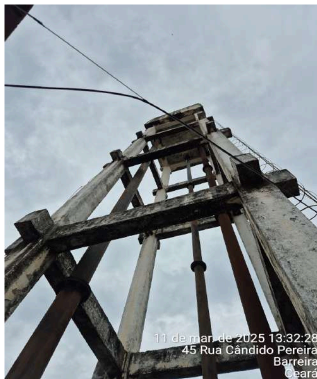
Foto 20 - REL-01 ( Sede ): falhas estruturais principalmente.
