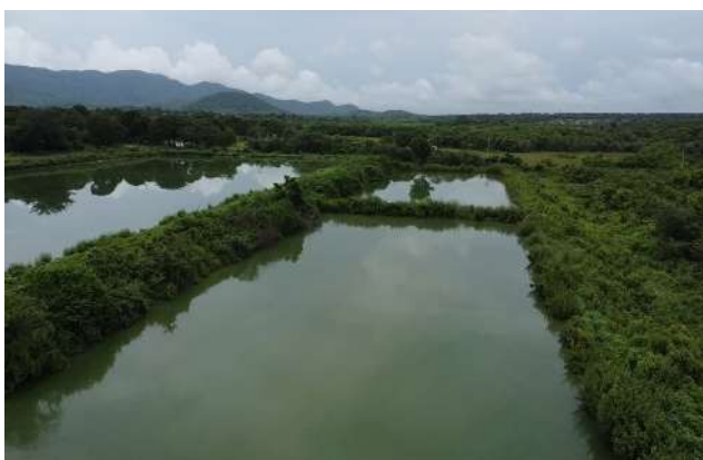
Foto 47 - ETE Barreira: estrada de serviço e taludes das lagoas tomados pela vegetação.
