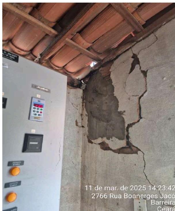
Foto 35 - RSE-02 / RSE-03 (Batalha / Cajueiro): casa da bomba em péssimo estado de conservação, com rachaduras na parede e madeira tomada por cupim.
