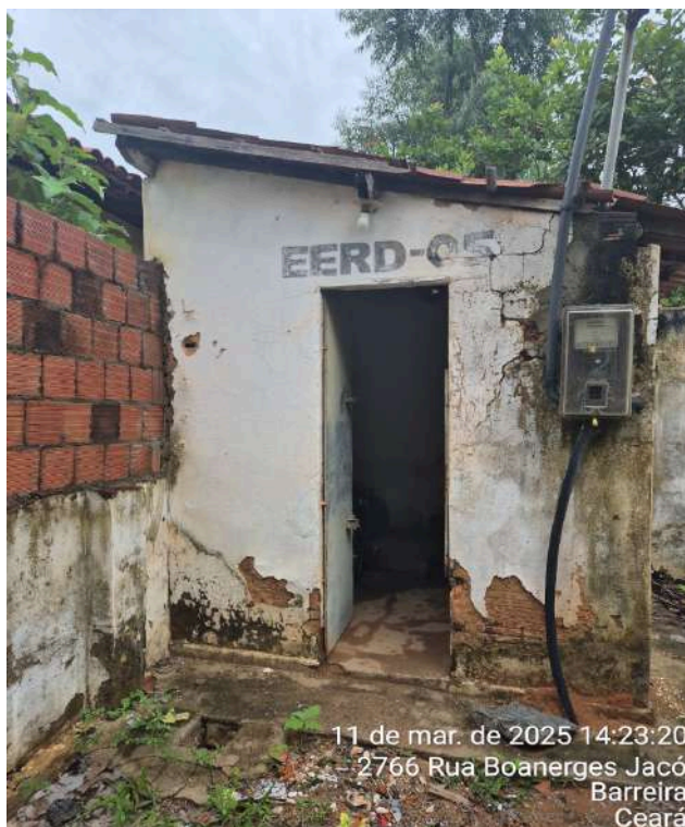
Foto 33 - RSE-02 / RSE-03 (Batalha / Cajueiro): casa da bomba em péssimo estado de conservação, com rachaduras na parede e madeira tomada por cupim.
