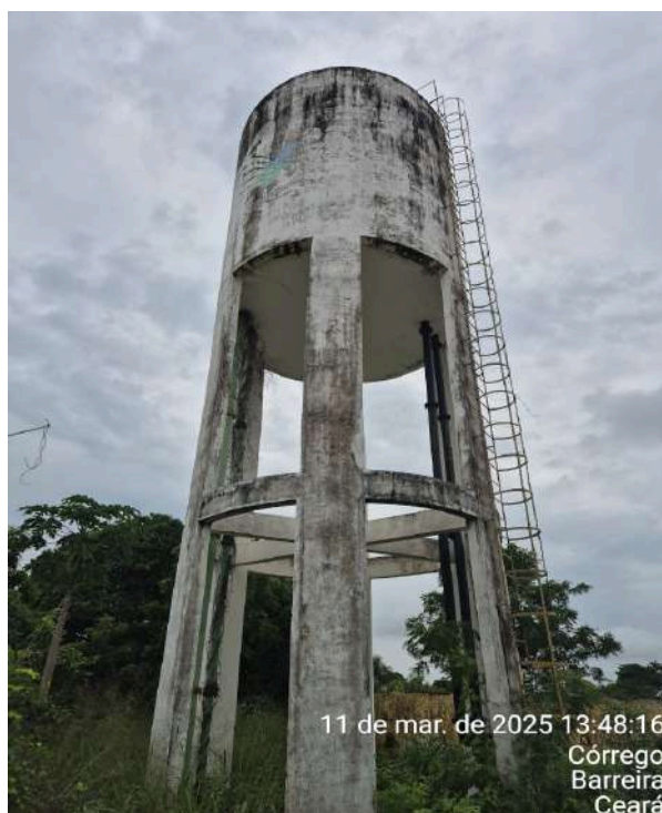
Foto 3 - REL-02: ausência de identificação e tampa.
