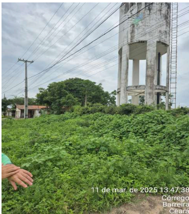
Foto 21 - REL-02 (Córrego): Reservatório com vegetação abundante, interferindo no acesso e nas estruturas, vegetação ao redor da tubulação, notadamente na tubulação de saída do tanque de reservação.
