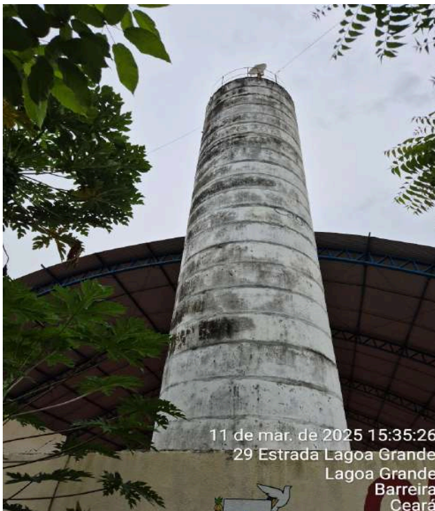
Foto 45 - REL-03 (Lagoa Grande): apresenta pintura deteriorada.
