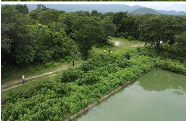
Foto 48 - ETE Barreira: estrada de serviço e taludes das lagoas tomados pela vegetação.
