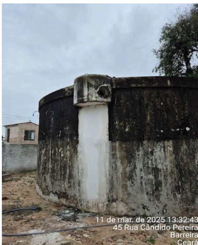
Foto 11 - RAP-14 (Sede): almojarifado funcionando dentro do RAP, apresentando falhas estruturais principalmente do lado externo.
