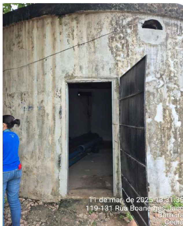
Foto 12 - RAP-14 / REL-01 (Sede): almojarifado funcionando dentro do RAP, sem muita ventilação e apresentando falhas estruturais principalmente do lado externo.
