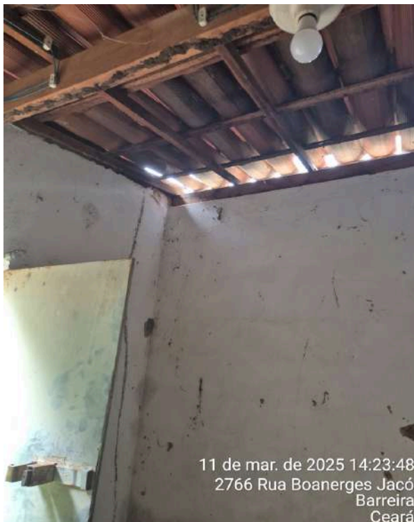
Foto 37 RSE-02 / RSE-03 ((Batalha / Cajueiro): casa da bomba em péssimo estado de conservação, com rachaduras na parede e madeira tomada por cupim.
