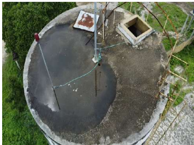
Foto 26 - REL-02 (Córrego): Reservatório sem tampa ou deslocada e aspecto deteriorado.
