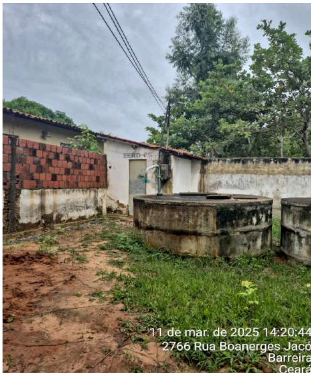
Foto 29 - RSE-02 / RSE-03 (Batalha / Cajueiro): estrutura em péssimo estado de conservação; restos de demolição ao redor, oferecendo risco físico aos trabalhadores e eventuais transeuntes; vegetação ao redor.
