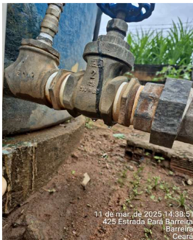
Foto 40 - RAP-15 (Croatá): presença de vazamento.
