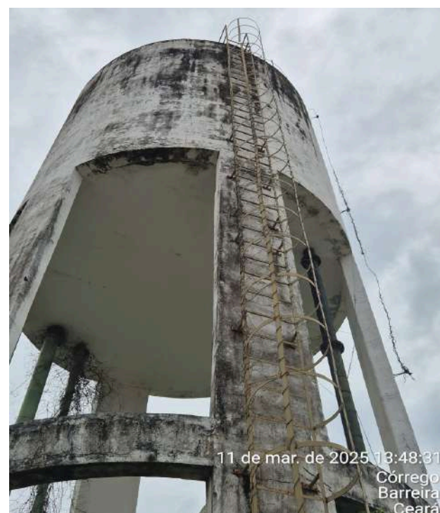
Foto 24 - REL-02 (Córrego): Reservatório com aspecto deteriorado, vegetação abundante, interferindo no acesso e nas estruturas, vegetação ao redor da tubulação, notadamente na tubulação de saída do tanque de reservação.
