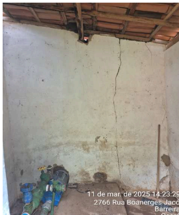
Foto 36 - RSE-02 / RSE-03 (Batalha / Cajueiro): casa da bomba em péssimo estado de conservação, com rachaduras na parede e madeira tomada por cupim.
