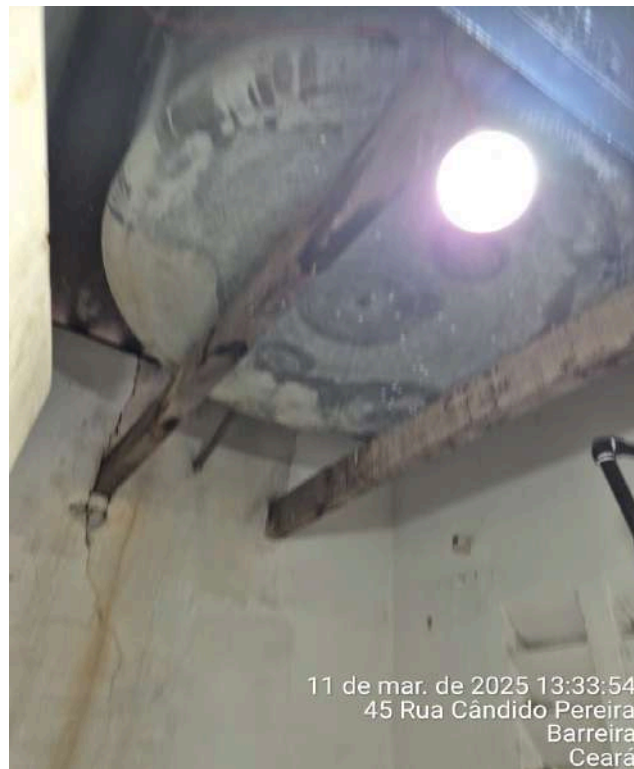
Foto 18 - RAP-14 / REL-01 ( Sede ): banheiro em péssimo estado de conservação, com risco de queda da caixa d'água, sendo possível observar rachaduras no apoio da viga.
