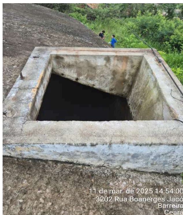
Foto 44 - RAP-13 (Cocos): reservatório sem vedação (tampas ausentes ou deslocadas).
