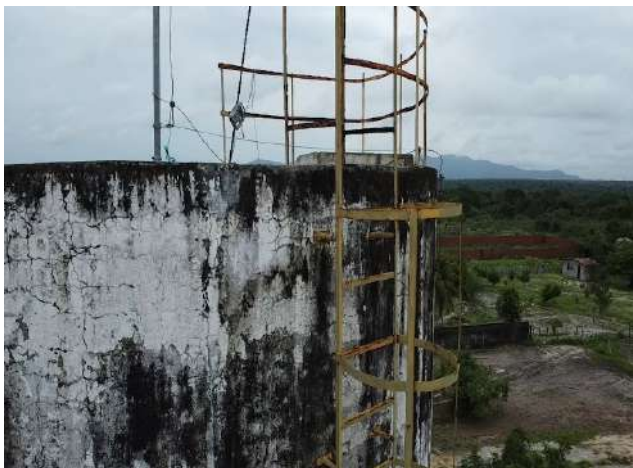
Foto 25 - REL-02 (Córrego): Reservatório com aspecto deteriorado e escada apresentando sinais de ferrugem nos parafusos de apoio.
