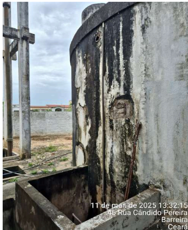
Foto 10 - RAP-14 (Sede): almojarifado funcionando dentro do RAP, apresentando falhas estruturais principalmente do lado externo.
