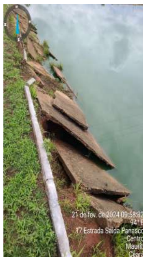
Foto 38 - ETE: taludes das lagoas estão em processo de erosão.
