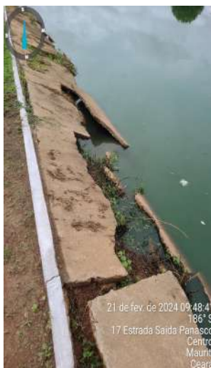
Foto 37 - ETE: taludes das lagoas estão em processo de erosão.
