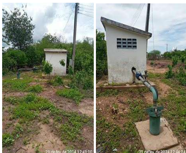
Foto 11 - PT-01 (Palestina): infraestrutura em área aberta e sem isolamento.
