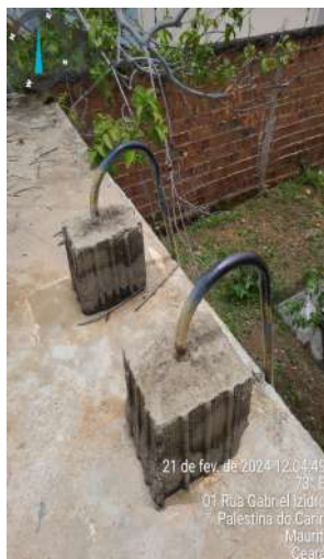
Foto 25 - RAP-01 (Palestina): escada tipo marinho inadequada e sem estabilidade.
