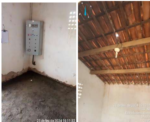
Foto 19 - PT-05 (Sede): Infraestrutura em recuperação e reformas, apresentando contra piso e telhado em processo de recuperação.
