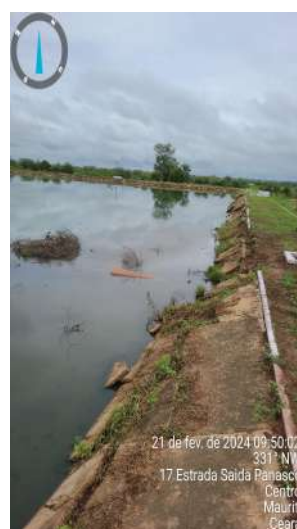
Foto 38 - ETE: taludes das lagoas estão em processo de erosão.
