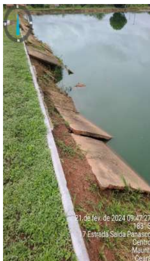
Foto 37 - ETE: taludes das lagoas estão em processo de erosão.
