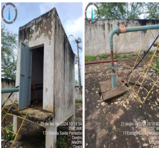
Foto 43 - PT-04 (Sede): instalações desativadas em definitivo.
