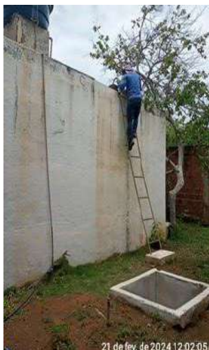
Foto 25 - RAP-01 (Palestina): escada tipo marinho inadequada e sem estabilidade.
