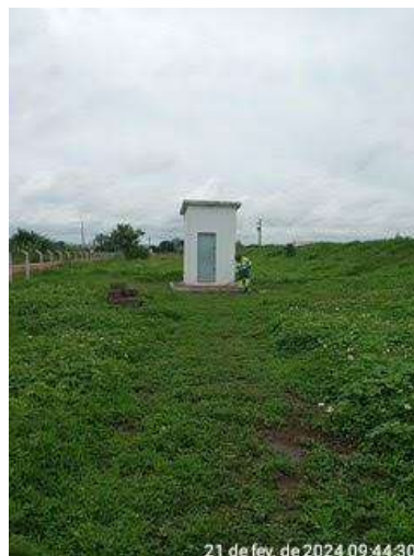
Foto 42 - Na ETE a área do pátio que dá acesso a casa de apoio dos operários não é pavimentada.
