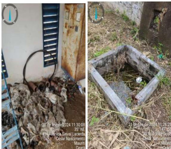
Foto 45 - PT-02 (Sede): instalações desativadas em definitivo.
