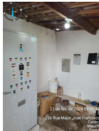
Foto 36 - EEE-01: materiais armazenados na sala do quadro de bombas, de forma improvisada em caixas e tábua apoiada em tijolos, sem organização e controle.
