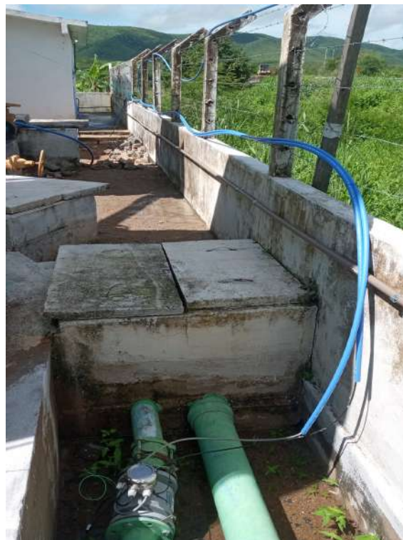
Foto 16 - ETA (macromedicação): eletrodutos instalados ao longo da cerca de arame.
