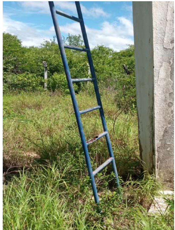
Foto 26 - REL-01 (desativado): infraestrutura fora de operação, cerca de proteção danificada e vegetação crescida, denotando abandono total.
