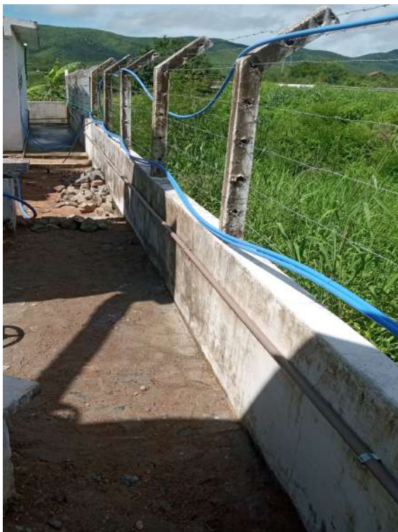
Foto 17 - ETA (macromedicação): eletrodutos instalados ao longo da cerca de arame.
