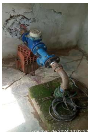
Foto 33 - PT-01: infraestrutura e instalações precárias; piso, parede, laje da casa do poço danificados; sem iluminação interna no poço e macromedidor.
