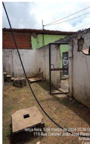
Foto 58 - RAP-01: a área não é pavimentada.
