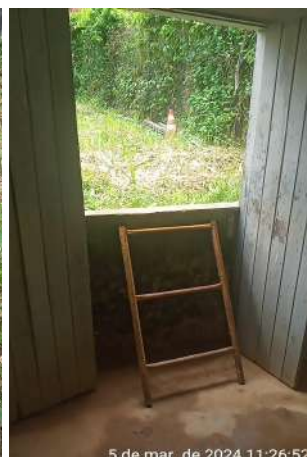
Foto 44 - EERD-02: quadro de energia elétrica enferrujado; escada de acesso tipo marinheiro a casa do quadro de comando e de bombas inadequada e sem fixação.
