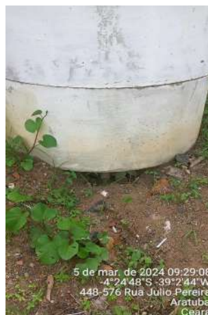
Foto 4 - PT-08 e PT-09: ausência de identificação; sem iluminação interna e externa; poço sem laje de proteção.
