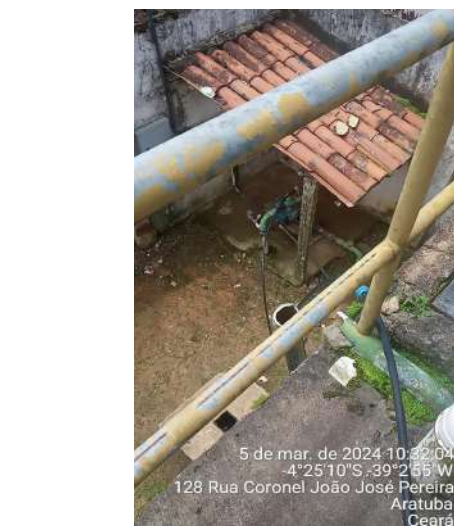
Foto 59 - RAP-01: a área não é pavimentada.
