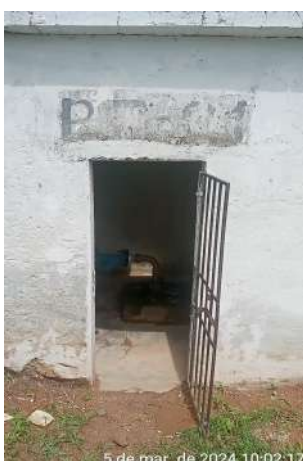
Foto 31 - PT-01: infraestrutura e instalações precárias; com identificação ilegível; piso, parede, laje da casa do poço danificados; sem iluminação interna no poço e macromedidor.
