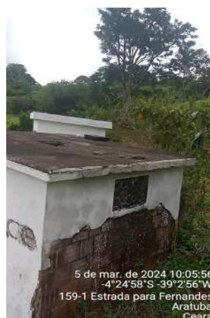
Foto 32 - PT-01: infraestrutura e instalações precárias; piso, parede, laje da casa do poço danificados; sem iluminação interna no poço e macromedidor.
