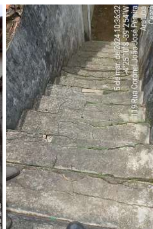
Foto 40 - RAP-01 / EEAT-01: laboratório com pintura degradada e pia enferrujada; depósito sem iluminação e telhado danificado (telhas desabando); escada de acesso com degraus rachados e corroídos.
