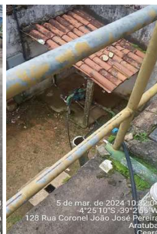
Foto 38 - RAP-01 / EEAT-01: tubulação do clorador improvisada por sobre a laje do reservatório e guarda-corpo do reservatório com pintura corroída.
