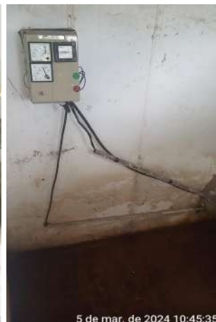
Foto 42 - EERD-01 / RAP-02: conjunto motor-bomba em base improvisada de tijolos; instalações elétricas do quadro de comando danificadas; escada tipo marinheiro do reservatório sem fixação adequada.
