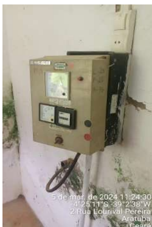
Foto 45 - EERD-02: quadro de comando danificado.
