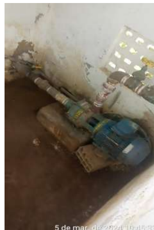
Foto 42 - EERD-01 / RAP-02: conjunto motor-bomba em base improvisada de tijolos; instalações elétricas do quadro de comando danificadas; escada tipo marinheiro do reservatório sem fixação adequada.
