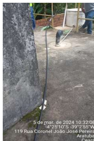
Foto 38 - RAP-01 / EEAT-01: tubulação do clorador improvisada por sobre a laje do reservatório e guarda-corpo do reservatório com pintura corroída.
