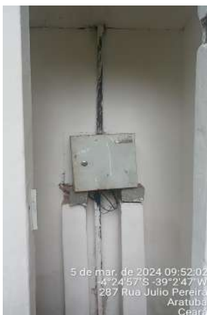
Foto 29 - PT-03: casa do quadro de comando sem lâmpada e quadro de comando sobre apoios improvisados de paralelepípedos.
