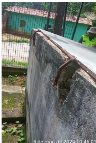
Foto 41 - EERD-01 / RAP-02: infraestrutura e instalações precárias com tampa da casa de bombas com fixação danificada; pintura e identificação deteriorados e escada tipo marinheiro do reservatório sem fixação adequada.
