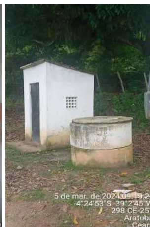
Foto 2 - PT-08 e PT-09: ausência de identificação; sem iluminação interna e externa; poço sem laje de proteção.
