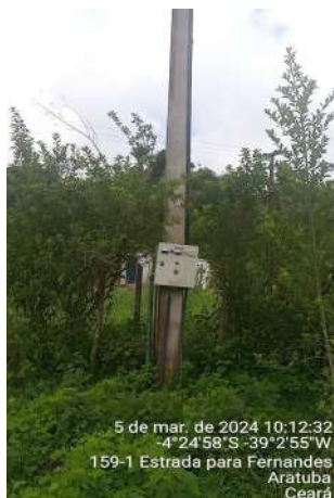
Foto 35 - PT-07: casa do quadro de comando desativada, mas com pontas de fiação elétrica e caixa com água empoçada.
