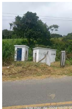
Foto 30 - PT-01: infraestrutura e instalações precárias; com identificação ilegível e cerca de isolamento e proteção danificada.
