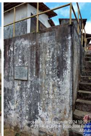
Foto 36 - RAP-01 / EEAT-01: infraestruturas precárias com identificação do rap apagada, reboco e pintura deteriorados.
