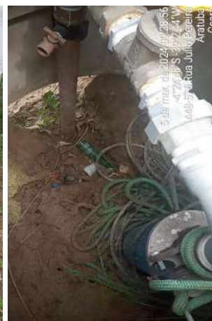
Foto 4 - PT-08 e PT-09: ausência de identificação; sem iluminação interna e externa; poço sem laje de proteção.
