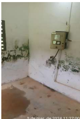
Foto 43 - EERD-02: casa do quadro de comando e de bombas com infraestrutura deteriorada (parede, teto, identificação e pintura).
