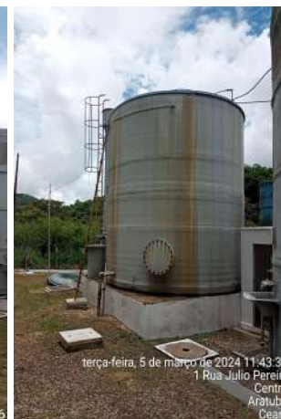
Foto 12 - Reatores: sem identificação e escada sem gaiola de proteção.
