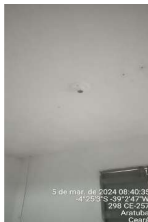
Foto 20 - Escritório / Almojarifado: paredes com pintura deteriorada e infiltração; teto do banheiro com revestimento danificado e lâmpadas em falta no almojarifado.
