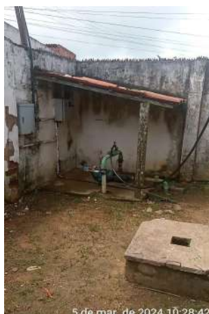
Foto 37 - RAP-01 / EEAT-01: elevatória com bomba em base improvisada e instalações elétricas com eletroduto sobre o piso.
