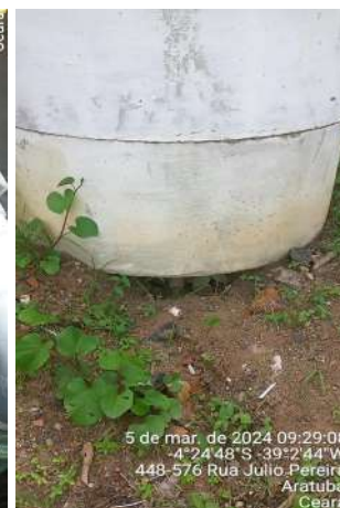
Foto 22 - PT-09: erosão na base.
