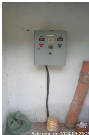
Foto 2 - PT-08 e PT-09: ausência de identificação; sem iluminação interna e externa; poço sem laje de proteção.
