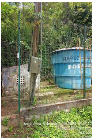
Foto 41 - EERD-01 / RAP-02: infraestrutura e instalações precárias com tampa da casa de bombas com fixação danificada; pintura e identificação deteriorados e escada tipo marinheiro do reservatório sem fixação adequada.
