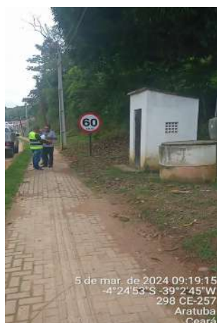
Foto 1 - PT-08 e PT-09: ausência de identificação; sem iluminação interna e externa; poço sem laje de proteção.
