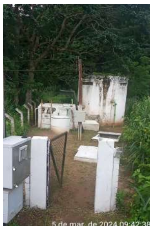
Foto 25 - RAP-04 / EEAB-02 / PT-02: pinturas da casa de bombas e RAP estão deterioradas; mato crescido em cima da laje da casa de bombas.
