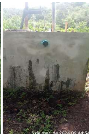
Foto 25 - RAP-04 / EEAB-02 / PT-02: pinturas da casa de bombas e RAP estão deterioradas; mato crescido em cima da laje da casa de bombas.
