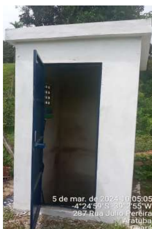
Foto 31 - PT-01: infraestrutura e instalações precárias; com identificação ilegível; piso, parede, laje da casa do poço danificados; sem iluminação interna no poço e macromedidor.
