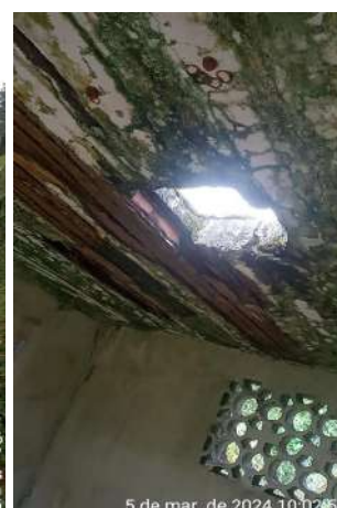
Foto 32 - PT-01: infraestrutura e instalações precárias; piso, parede, laje da casa do poço danificados; sem iluminação interna no poço e macromedidor.
