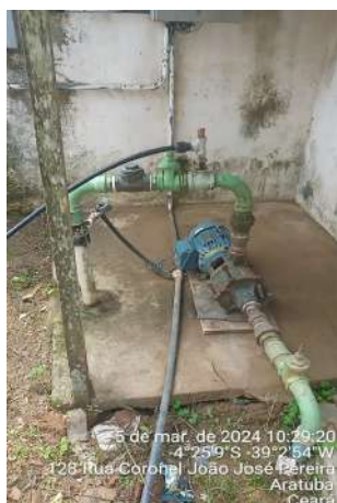
Foto 37 - RAP-01 / EEAT-01: elevatória com bomba em base improvisada e instalações elétricas com eletroduto sobre o piso.
