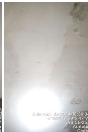
Foto 20 - Escritório / Almojarifado: paredes com pintura deteriorada e infiltração; teto do banheiro com revestimento danificado e lâmpadas em falta no almojarifado.
