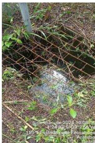
Foto 35 - PT-07: casa do quadro de comando desativada, mas com pontas de fiação elétrica e caixa com água empoçada.
