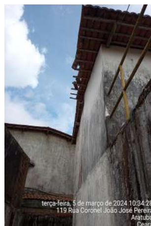
Foto 40 - RAP-01 / EEAT-01: laboratório com pintura degradada e pia enferrujada; depósito sem iluminação e telhado danificado (telhas desabando); escada de acesso com degraus rachados e corroídos.
