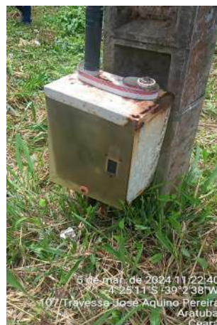
Foto 44 - EERD-02: quadro de energia elétrica enferrujado; escada de acesso tipo marinheiro a casa do quadro de comando e de bombas inadequada e sem fixação.
