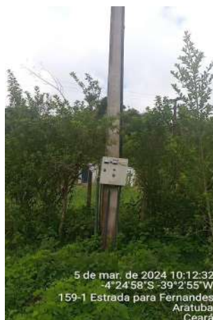
Foto 9 - PT-07: ausência de identificação; poço sem laje de proteção; não há iluminação na área do poço e quadro de comando instalado em poste afastado da área do poço e sem iluminação para trabalhos noturnos.
