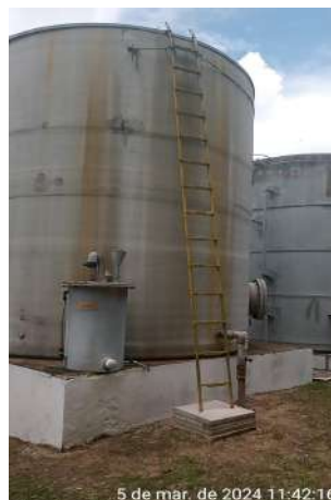
Foto 12 - Reatores: sem identificação e escada sem gaiola de proteção.
