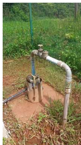
Foto 54 - PT-05 e PT-06: área do poço lamacenta e sem pavimentação.
