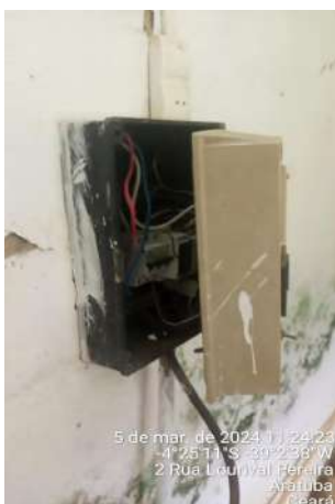
Foto 45 - EERD-02: quadro de comando danificado.
