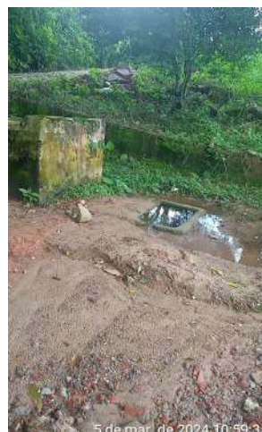
Foto 52 - FT-01: infraestrutura desativada, cujas instalações foram totalmente desmontadas.
