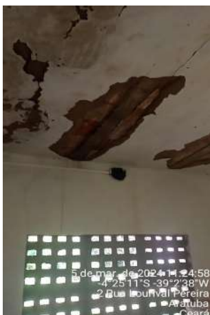
Foto 43 - EERD-02: casa do quadro de comando e de bombas com infraestrutura deteriorada (parede, teto, identificação e pintura).
