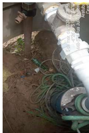
Foto 22 - PT-09: erosão na base.
