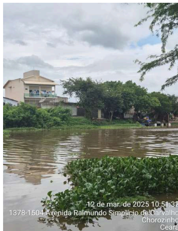
Foto 4 - Captação (Triângulo): ausência de identificação.
