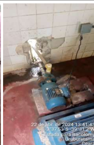
Foto 20 - ETA-EELF / BOOSTER: parede e pintura sujas e deterioradas; fiação elétrica precária com pontas de fios expostas no piso.
