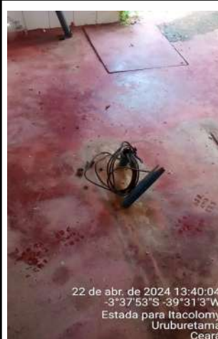
Foto 20 - ETA-EELF / BOOSTER: parede e pintura sujas e deterioradas; fiação elétrica precária com pontas de fios expostas no piso.
