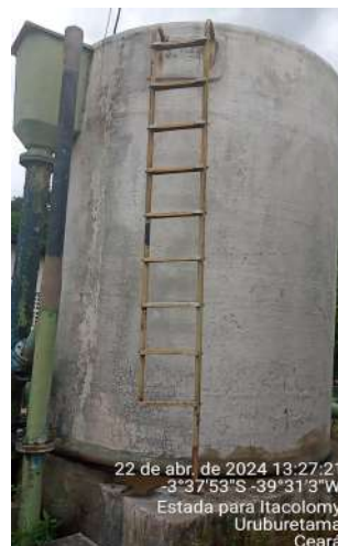
Foto 12 - ETA/Filtros: infraestruturas sem identificação visível; escada do F1 danificada na base
