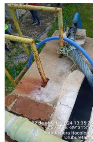
Foto 14 - ETA/RAP-01: pintura deteriorada e mato crescido ao redor do reservatório.
