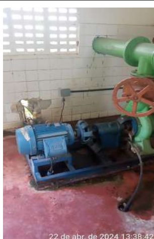
Foto 19 - ETA-EELF / BOOSTER: parede e pintura sujas e deterioradas; fiação elétrica precária com fios sem eletroduto de isolamento e proteção.
