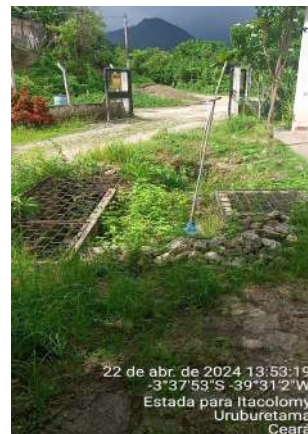
Foto 28 - ETA / Adutoras (Uruburetama e Tururu): infraestrutura e instalações precárias, com caixas de proteção danificadas e com água acumulada e vegetação crescida.
