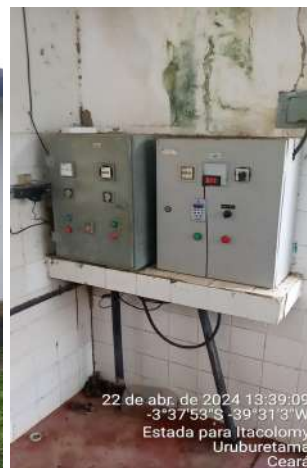
Foto 18 - ETA-EELF/BOOSTER: parede e pintura deterioradas; infraestrutura sem porta; fiação elétrica precária sem eletroduto de isolamento e proteção.
