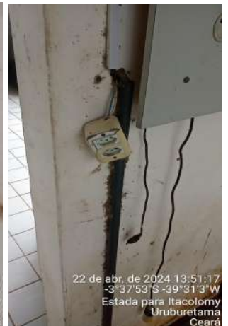
Foto 26 - ETA / Laboratório/ Casa de Química / Almojarifado: casa de química com fiação sem eletroduto de isolamento e proteção ou eletrodutos danificados, caixas e quadros elétricos danificados
