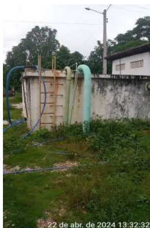
Foto 13 - ETA/RAP-01: pintura deteriorada e mato crescido ao redor do reservatório.
