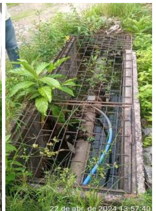
Foto 28 - ETA / Adutoras (Uruburetama e Tururu): infraestrutura e instalações precárias, com caixas de proteção danificadas e com água acumulada e vegetação crescida.
