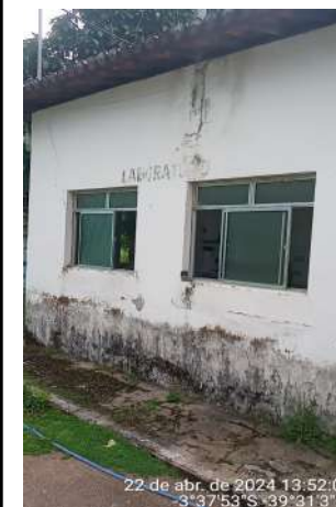
Foto 22 - ETA / Laboratório/ Casa de Química / Almojarifado: infraestruturas com paredes e pinturas sujas, sem identificação visível e deterioradas; tubulação de cloração inadequada, instalada sobre o solo da área de circulação do pátio.
