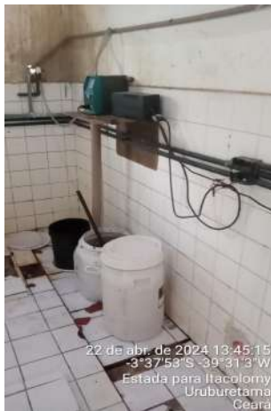
Foto 25 - ETA / Laboratório/ Casa de Química / Almojarifado: casa de química com fiação sem eletroduto de isolamento e proteção ou eletrodutos danificados, caixas e quadros elétricos danificados.
