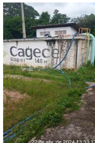
Foto 14 - ETA/RAP-01: pintura deteriorada e mato crescido ao redor do reservatório.
