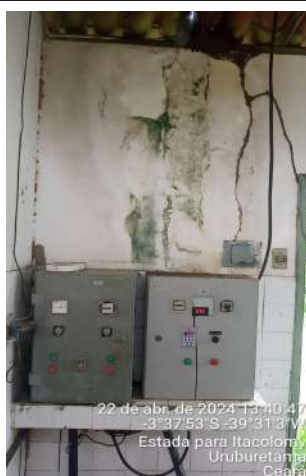
Foto 19 - ETA-EELF / BOOSTER: parede e pintura sujas e deterioradas; fiação elétrica precária com fios sem eletroduto de isolamento e proteção.
