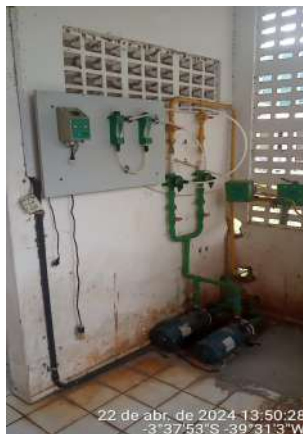
Foto 27 - ETA / Laboratório / Casa de Química / Almojarifado: casa de química com fiação sem eletroduto de isolamento e proteção ou eletrodutos danificados, caixas e quadros elétricos danificados.
