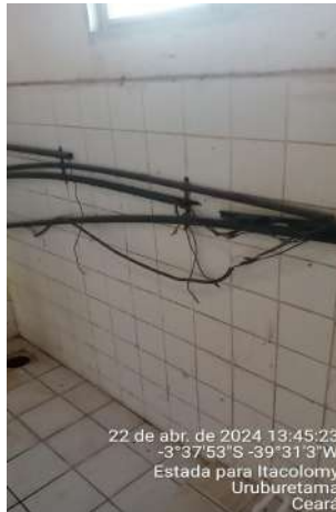
Foto 25 - ETA / Laboratório/ Casa de Química / Almojarifado: casa de química com fiação sem eletroduto de isolamento e proteção ou eletrodutos danificados, caixas e quadros elétricos danificados.
