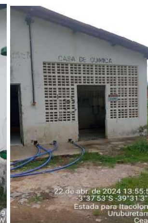
Foto 22 - ETA / Laboratório/ Casa de Química / Almojarifado: infraestruturas com paredes e pinturas sujas, sem identificação visível e deterioradas; tubulação de cloração inadequada, instalada sobre o solo da área de circulação do pátio.
