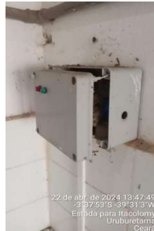
Foto 26 - ETA / Laboratório/ Casa de Química / Almojarifado: casa de química com fiação sem eletroduto de isolamento e proteção ou eletrodutos danificados, caixas e quadros elétricos danificados
