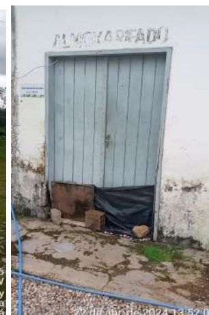
Foto 21 - ETA / Laboratório/ Casa de Química / Almojarifado: infraestruturas com paredes e pinturas sujas, sem identificação visível e deterioradas; tubulação de cloração inadequada, instalada sobre o solo da área de circulação do pátio.
