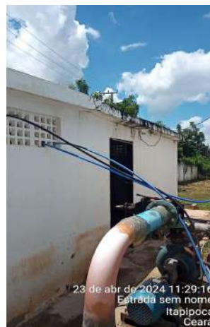
Foto 136 ETA/Casa de Química (Lagoa da Cruz): tubulações de produtos químicos instalados de forma precária pelos cobogós da janela e ausência de lâmpada.
