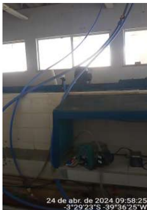
Foto 79 - Mini Laboratório (ETA-02) (Sede): tubulação hidráulica de produtos químicos instalados de forma precária e improvisada por sobre os tanques de dosagem e viga do telhado.
