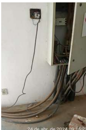
Foto 69 - EEAT-03 (ETA-02) (Sede): instalações elétricas inadequadas; disjuntor instalado em caixa sem tampa e banco capacitor instalado de forma improvisada em cima do quadro de comando.
