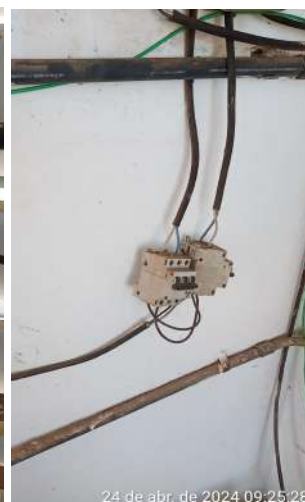
Foto 20 - ETA-02 / Cloração (Sede): disjuntores sem caixas de proteção e caixas elétricas sem tampas.
