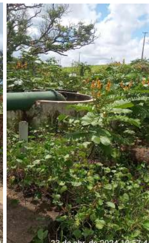
Foto 46 - Manancial/Captação Poço Verde (Sede): acesso difícil (lamacento) e área do pátio externo lamacento e com mato crescido.
