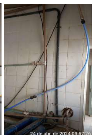
Foto 78 - Mini Laboratório (ETA-02) (Sede): sala do quadro de comando e dos tanques de dosagem com instalações elétricas precárias.
