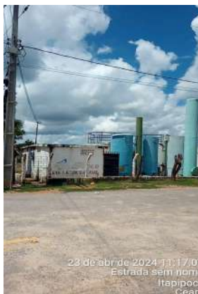
Foto 144 ETA (Lagoa da Cruz): identificação e pintura desgastados.
