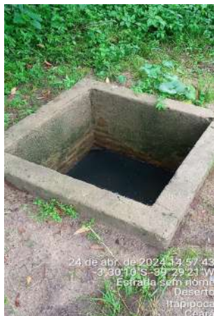
Foto 151 - ETE (Deserto): infraestrutura do tratamento primário precária, sem pavimentação das áreas laterais e grade de isolamento e proteção, sem divisórias de isolamento das caixas de areias
