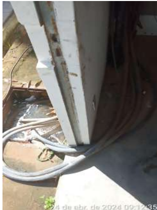
Foto 67 - EEAT-03 (ETA-02) (Sede): instalações elétricas inadequadas sobre o piso, através do vão da porta de entrada, com cabos/fiação elétricos sem eletrodutos ou calhas de isolamento e proteção; caixa de passagem elétrica no piso inundada e sem tampa.
