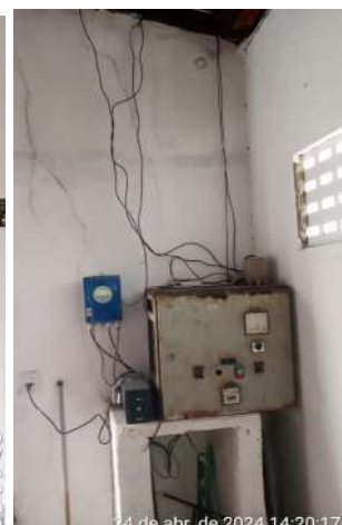
Foto 131 - Casa de Química (Deserto): quadro de comando e instalações elétricas em estado precário, quadro em estado avançado de corrosão, sem fixação e mal apoiado e instalações elétricas sem eletrodutos de isolamento e proteção.
