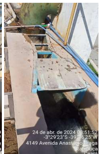
Foto 10- ETA-02 (Sede): tubulações conduzidas por sobre o piso da passarela ou cruzando a mesma e obstruindo a passagem.
