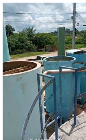
Foto 38 - ETA / Filtros (Lagoa da Cruz): sem identificação e sem tampas; F-01 e F-02 sem escadas tipo marinheiro e F-03 com escada tipo marinheiro sem gaiola de proteção.
