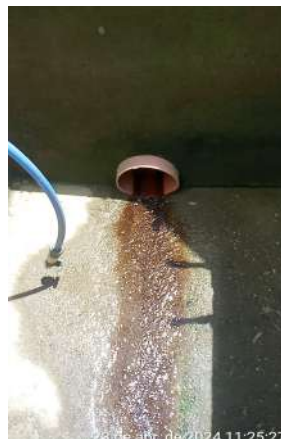
Foto 140 - F-03 (Lagoa da Cruz): a escada do filtro está danificada.
