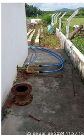
Foto 141 - ETA/Cloração (Lagoa da Cruz): tubulações de cloração/produtos químicos inadequadas, instaladas sobre o solo da área de circulação e suspensa sem fixação adequada; ponto de pré-cloração sem caixa de inspeção e proteção.
