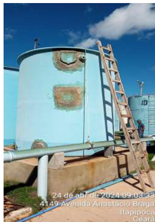
Foto 15 - ETA-02 / Filtros F-09 a F-11 (Sede): sem escadas ou escadas tipo marinheiro inadequadas, sem guarda-corpo acima do patamar superior da estrutura e sem gaiola de proteção.
