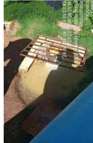
Foto 52 - ETA-02 (Sede): caixas de proteção e inspeção deterioradas (soterradas, inundadas, tomadas por vegetação, quebradas e com tampas danificadas).
