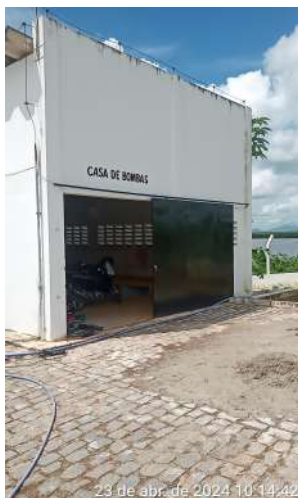
Foto 43 - Manancial/Captação Gameleira (Sede): tubulação de cloração instalada sobre o solo da área de circulação.
