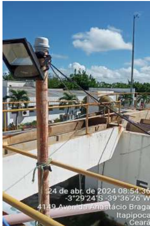
Foto 13- ETA-02 (Sede): lâmpadas instaladas nas grades de proteção (corrimão) ou em postes improvisados.
