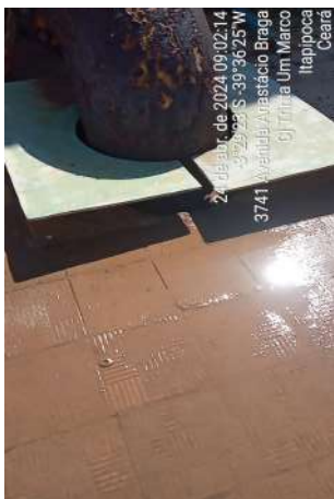
Foto 17 - ETA-02/REN-01 (Sede): reservatório não tem controle de nível e água transborda, inundando e lavando a laje de cobertura, cuja água retorna para dentro do mesmo, por meio da chaminé da abertura de inspeção que está quebrada; tubulação por sobre a laje de cobertura.
