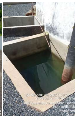
Foto 22 - ETA-02 / RSE-01 (Sede): sem ventilação e caixas sem tampas.
