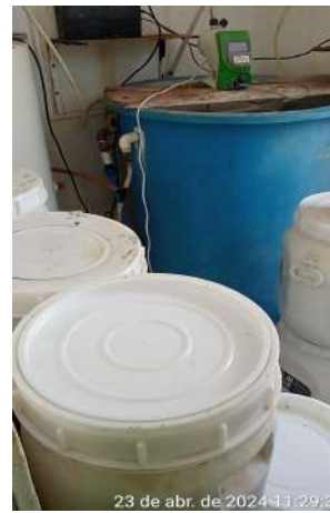
Foto 138 - ETA/Casa de Química (Lagoa da Cruz): o sistema de dosagem de produtos químicos está instalado de maneira inadequada.
