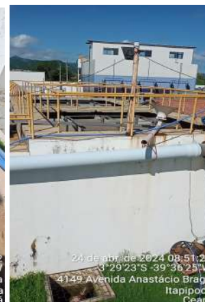
Foto 58 - ETA-02 (Sede): floculadores, decantadores e filtros com pintura desgastada; vegetação crescida próxima aos filtros e decantadores.
