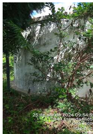
Foto 110 - RAP-04 / EEAT-04 (Sede): vegetação crescida; instalações elétricas precárias; sem lâmpada externa; estruturas com e identificação pintura desgastadas.
