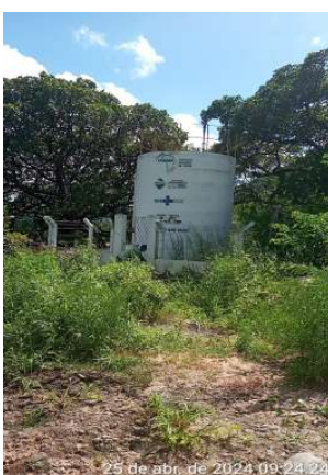
Foto 101 - RAP's (Estrada da Serrinha) (Sede): vegetação crescida; iluminação externa sem lâmpada; ausência controle de nível contra extravasamento.
