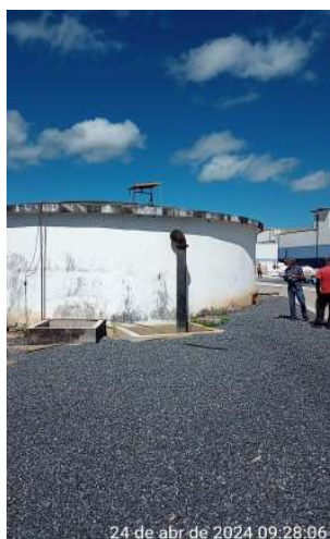
Foto 21 - ETA-02 / RSE-01 (Sede): sem identificação, sem escada tipo marinheiro, instalações elétricas sem eletrodutos de isolamento e proteção, sem ventilação e caixas sem tampas.
