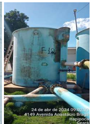
Foto 16 - ETA-02 / Filtros F-09 a F-11 (Sede): sem escadas ou escadas tipo marinheiro inadequadas, sem guarda-corpo acima do patamar superior da estrutura e sem gaiola de proteção.
