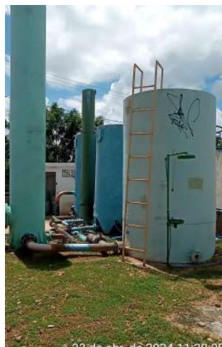
Foto 38 - ETA / Filtros (Lagoa da Cruz): sem identificação e sem tampas; F-01 e F-02 sem escadas tipo marinheiro e F-03 com escada tipo marinheiro sem gaiola de proteção.
