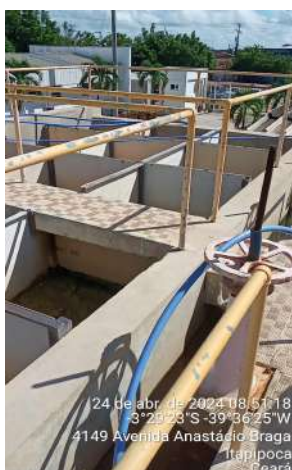
Foto 59 - ETA-02 (Sede): floculadores, decantadores e filtros com pintura desgastada e decantadores.
