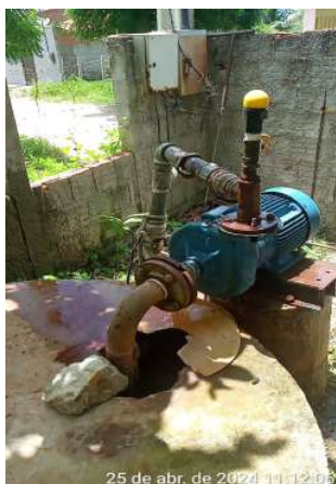
Foto 115 - EERD-03 (Sede): infraestrutura de isolamento e proteção deteriorada; abertura na laje sem fechamento hermético.
