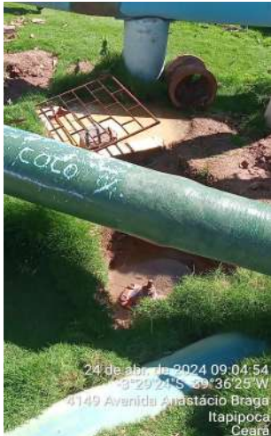
Foto 7 - ETA-02 / Dispositivos diversos (Sede): dispositivos sem caixas de proteção.
