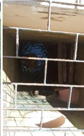
Foto 51 - ETA-02 (Sede): caixas de proteção e inspeção deterioradas (soterradas, inundadas, tomadas por vegetação, quebradas e com tampas danificadas).
