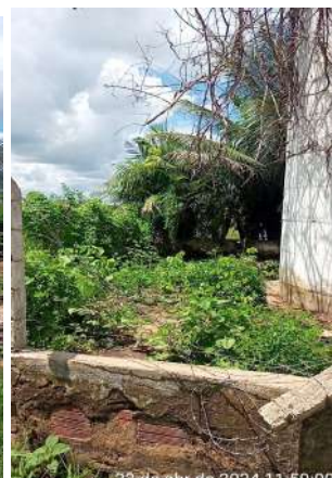
Foto 148 - REL-01 (Lagoa da Cruz): mureta deteriorada, cerca danificada e área com vegetação crescida; não há iluminação para trabalhos noturnos; área sendo utilizada para criação de porcos.
