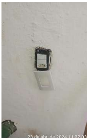
Foto 135 ETA/Casa de Bomba (Lagoa da Cruz): pintura desgastada, interruptores danificados ou sem tampas; abertura de passagem da tubulação na parede sem acabamento.
