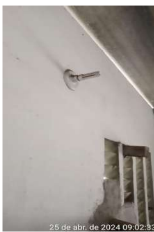
Foto 100 - EERD-02 (Sede): infraestrutura necessitando de manutenção e limpeza, parede rachada, pintura deteriorada e área com sujeira; instalações elétricas precárias, com eletrodutos danificados, fiação solta e exposta.
