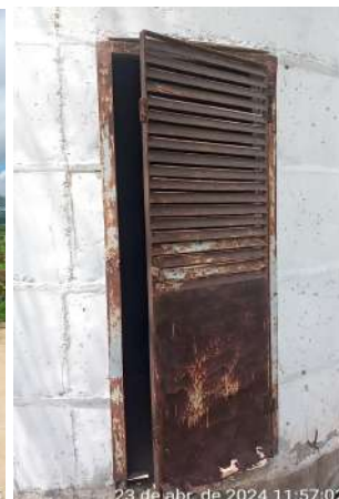
Foto 146 - REL-01 (Lagoa da Cruz): pintura e identificação desgastados, porta, escada e grade de proteção em processo de corrosão.
