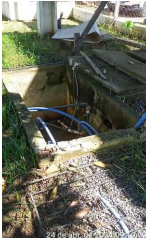
Foto 7 - ETA-02 / Dispositivos diversos (Sede): dispositivos sem caixas de proteção.
