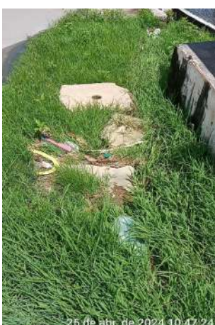
Foto 113 EERD-01 (Sede): reboco e pintura deteriorados; caixas de inspeção danificadas e cobertas por vegetação.
