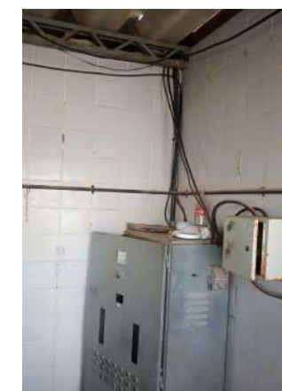
Foto 78 - Mini Laboratório (ETA-02) (Sede): sala do quadro de comando e dos tanques de dosagem com instalações elétricas precárias.
