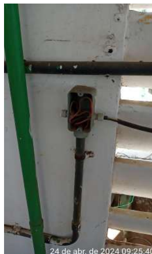
Foto 20 - ETA-02 / Cloração (Sede): disjuntores sem caixas de proteção e caixas elétricas sem tampas.
