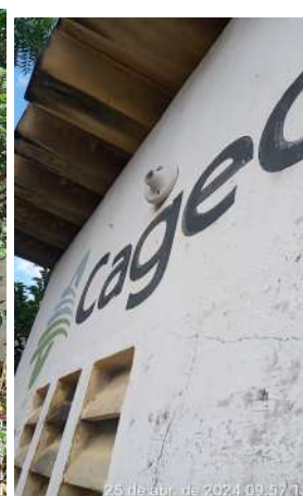
Foto 110 - RAP-04 / EEAT-04 (Sede): vegetação crescida; instalações elétricas precárias; sem lâmpada externa; estruturas com e identificação pintura desgastadas.
