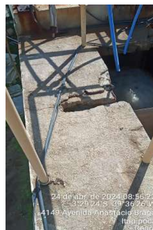
Foto 12 - ETA-02 (Sede): instalações elétricas inadequadas com cabos/fiação sem eletrodutos de isolamento e proteção, conduzidos pelas grades de proteção e por sobre o piso das passarelas.
