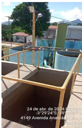
Foto 57 - ETA-02 (Sede): floculadores, decantadores e filtros com pintura desgastada e decantadores.
