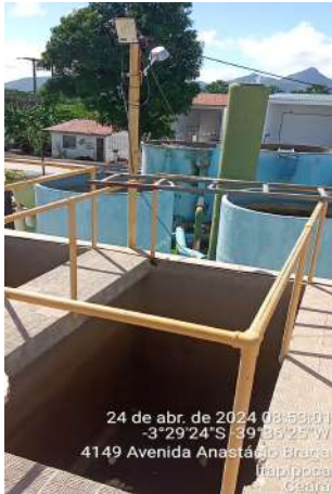
Foto 13- ETA-02 (Sede): lâmpadas instaladas nas grades de proteção (corrimão) ou em postes improvisados.
