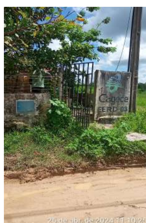
Foto 114 EERD-03 (Sede): infraestrutura de isolamento e proteção deteriorada; pintura e identificação desgastados.
