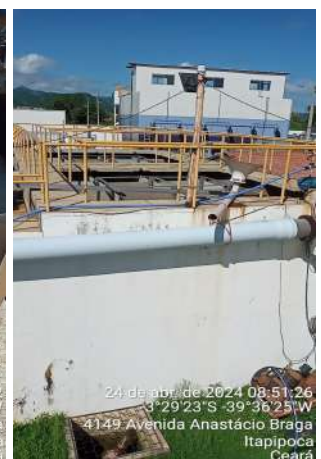
Foto 12 - ETA-02 (Sede): instalações elétricas inadequadas com cabos/fiação sem eletrodutos de isolamento e proteção, conduzidos pelas grades de proteção e por sobre o piso das passarelas.
