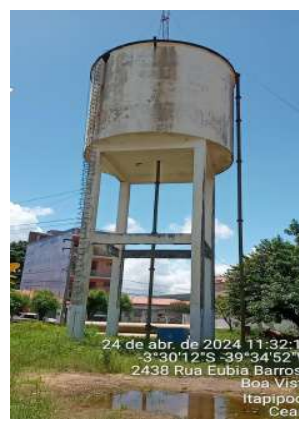
Foto 94 - REN-03/EEAT-05/REL (Sede): infraestrutura com bastante área livre, carente de manutenção, com pintura deteriorada e identificação desgastada, mato crescido.
