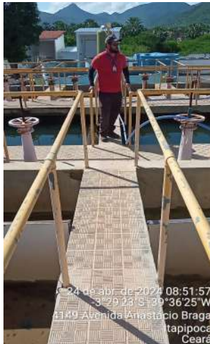
Foto 9 - ETA-02 (Sede): tubulações conduzidas por sobre o piso da passarela ou cruzando a mesma e obstruindo a passagem.
