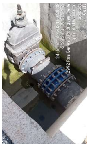
Foto 23 - ETA-02 / RSE-01 (Sede): sem ventilação e caixas sem tampas.
