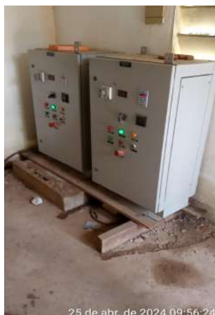
Foto 109 - RAP-04 / EEAT-04 (Sede): ambiente sujo da casa de bombas; quadro de comando com apoio improvisado; instalações elétricas precárias com fiação/cabos soltos sobre o piso.
