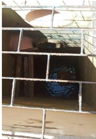
Foto 55 - ETA-02 (Sede): caixas de proteção e inspeção deterioradas (soterradas, inundadas, tomadas por vegetação, quebradas e com tampas danificadas).
