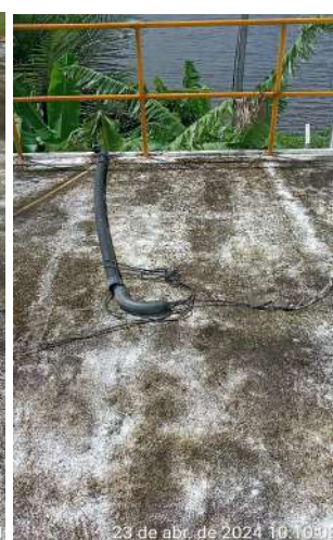
Foto 44 - RAP-06 (Sede): com aberturas na laje de proteção; fiação inadequada com fios soltos e/ou enrolados na grade de proteção e lâmpada danificada.
