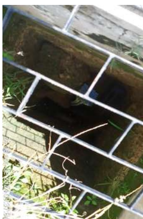
Foto 55 - ETA-02 (Sede): caixas de proteção e inspeção deterioradas (soterradas, inundadas, tomadas por vegetação, quebradas e com tampas danificadas).
