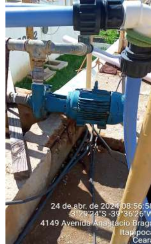
Foto 8 - ETA-02 (Sede): instalação de bombeamento instalados de forma precária e improvisada, motor-bomba sem base de sustentação.
