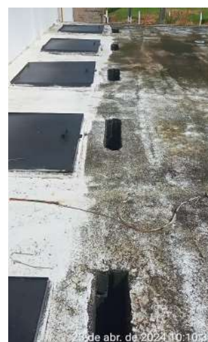
Foto 44 - RAP-06 (Sede): com aberturas na laje de proteção; fiação inadequada com fios soltos e/ou enrolados na grade de proteção e lâmpada danificada.
