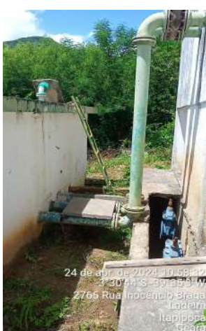
Foto 91 - ETA-01 (Sede): calha de descarga dos filtros sem tampa de proteção, área externa com registros sem caixa de proteção e buracos abertos; casa dos registros/filtros/laboratório apresenta pintura desgastada.
