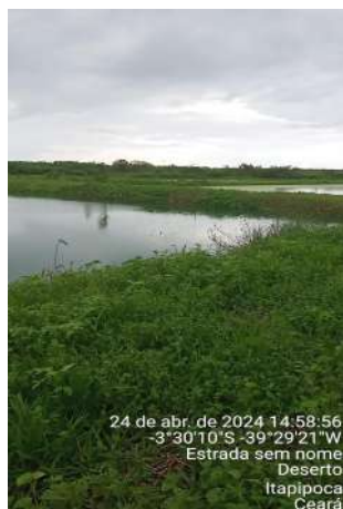
Foto 153 - ETE (Deserto): infraestrutura do tratamento primário precária; taludes tomados pela vegetação; caixa de distribuição dos esgotos nas lagoas sem tampa.
