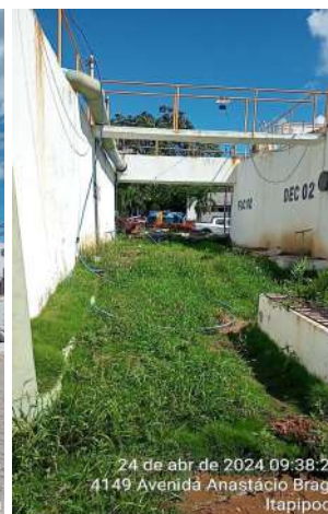
Foto 60 - ETA-02 (Sede): floculadores, decantadores e filtros com pintura desgastada; vegetação crescida próxima aos filtros e decantadores.
