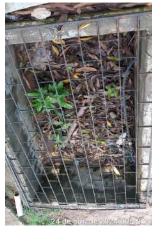
Foto 54 - ETA-02 (Sede): caixas de proteção e inspeção deterioradas (soterradas, inundadas, tomadas por vegetação, quebradas e com tampas danificadas).
