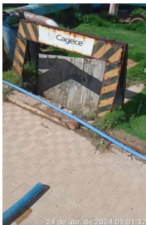
Foto 51 - ETA-02 (Sede): caixas de proteção e inspeção deterioradas (soterradas, inundadas, tomadas por vegetação, quebradas e com tampas danificadas).
