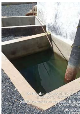
Foto 73 - RSE-01 (ETA-02) (Sede): caixas com inundadas; escada inadequada e tampa de inspeção deteriorada.
