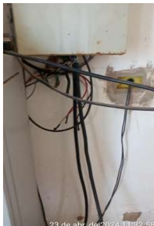
Foto 133 ETA/Casa de Bomba (Lagoa da Cruz): pintura desgastada, instalações elétricas precárias com fios/cabos com pontas soltas, caixas elétricas e/ou interruptores danificados ou sem tampas.
