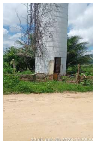
Foto 146 - REL-01 (Lagoa da Cruz): pintura e identificação desgastados, porta, escada e grade de proteção em processo de corrosão.
