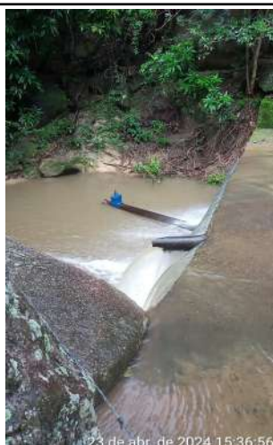
Foto 5 - Manancial / Captação Garapa (Sede): sem placa indicativa de ser área de preservação e destinada ao abastecimento de água.
