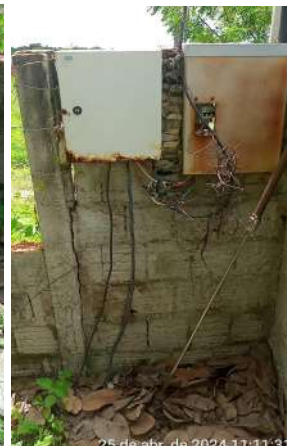
Foto 116 - EERD-03 (Sede): vegetação crescida; quadro de comando deteriorado pela corrosão e fiação/cabos elétricos inadequados, sobre o piso e sem eletroduto de isolamento e proteção.
