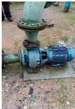
Foto 127 ETA/Filtros (Deserto): conjunto motor-bomba de lavagem dos filtros com vazamento.
