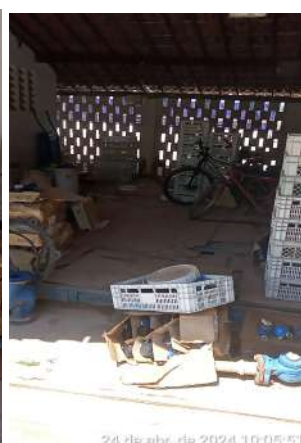
Foto 83 - Almoxarifado (ETA-02) (Sede): sem iluminação; materiais armazenados de forma precária, sem organização e controle; área destinada à armazenagem de produtos químicos, utilizadas para guardar outros materiais.
