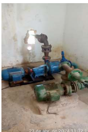
Foto 135 ETA/Casa de Bomba (Lagoa da Cruz): pintura desgastada, interruptores danificados ou sem tampas; abertura de passagem da tubulação na parede sem acabamento.
