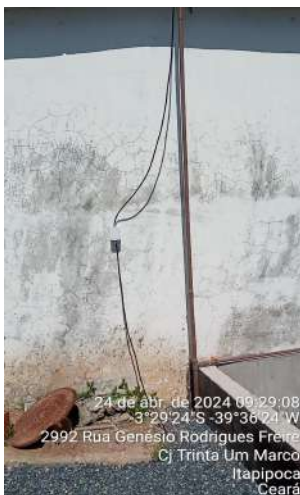
Foto 21 - ETA-02 / RSE-01 (Sede): sem identificação, sem escada tipo marinheiro, instalações elétricas sem eletrodutos de isolamento e proteção, sem ventilação e caixas sem tampas.
