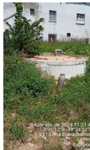
Foto 96 - REN-03 (Sede): sem fechamento hermético; identificação desgastada e registros sem caixa de proteção.
