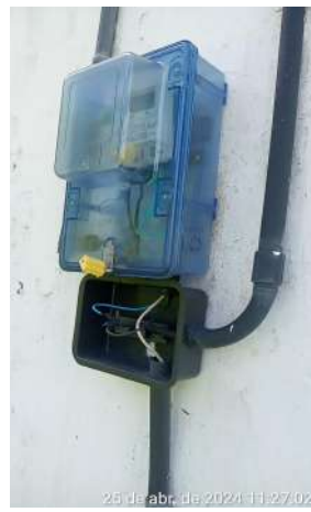
Foto 118 RAP-03 (Sede): caixa de passagem elétrica sem tampa; vegetação crescida e pintura desgastada.
