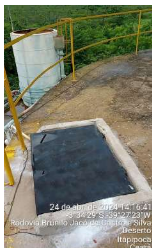
Foto 35 - ETA / RAP-01 (Deserto): sem ventilação; cabos elétricos inadequados soltos sobre a laje e enrolados na grade de proteção, sem eletroduto de isolamento e proteção.
