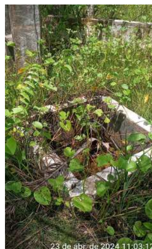
Foto 4 - Manancial / Captação Poço Verde (Sede): caixas sem tampa de proteção.
