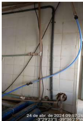
Foto 79 - Mini Laboratório (ETA-02) (Sede): tubulação hidráulica de produtos químicos instalados de forma precária e improvisada por sobre os tanques de dosagem e viga do telhado.
