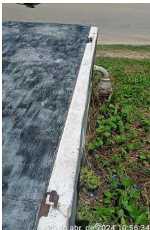
Foto 117 EERD-SN (Sede): pintura desgastada e sem identificação; área com sujeira e sobras de material deixados no local; dobradiças da tampa quebradas.
