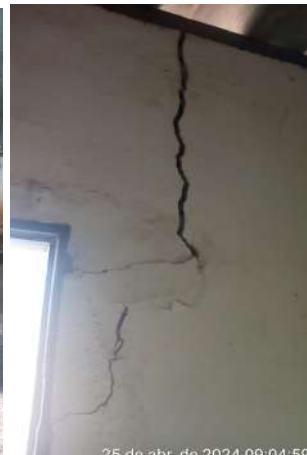
Foto 98 - EERD-02 (Sede): infraestrutura necessitando de manutenção e limpeza, parede rachada, pintura deteriorada e área com sujeira.
