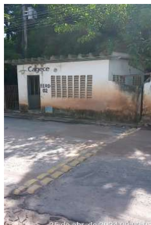
Foto 98 - EERD-02 (Sede): infraestrutura necessitando de manutenção e limpeza, parede rachada, pintura deteriorada e área com sujeira.
