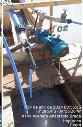
Foto 8 - ETA-02 (Sede): instalação de bombeamento instalados de forma precária e improvisada, motor-bomba sem base de sustentação.
