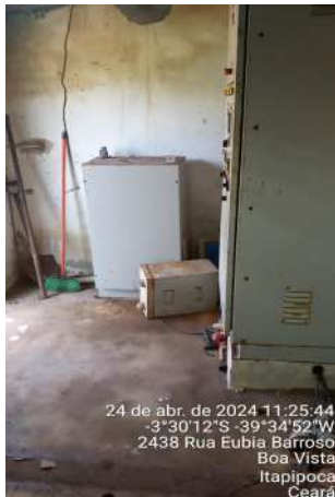
Foto 97 - Casa de Bombas (Sede): com sujeira acumulada; instalações elétricas precárias, sem eletroduto de isolamento e proteção; parede com buraco sem acabamento e dispositivos danificados.
