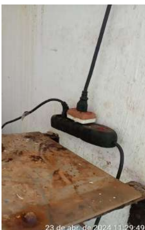
Foto 137 ETA/Casa de Química (Lagoa da Cruz): instalações elétricas precárias com caixas elétricas e/ou interruptores danificados ou sem tampas.
