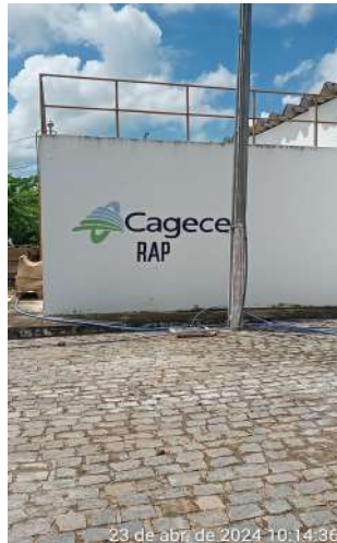
Foto 43 - Manancial/Captação Gameleira (Sede): tubulação de cloração instalada sobre o solo da área de circulação.
