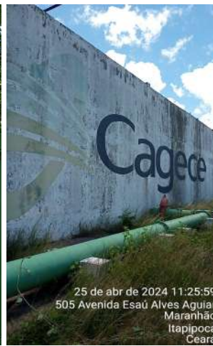
Foto 120 RAP-03 (Sede): vegetação crescida, escada tipo marinheiro solta, pintura e identificação desgastados
