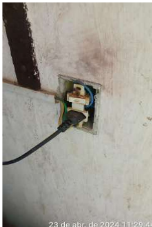
Foto 137 ETA/Casa de Química (Lagoa da Cruz): instalações elétricas precárias com caixas elétricas e/ou interruptores danificados ou sem tampas.
