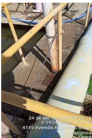
Foto 11- ETA-02 (Sede): instalações elétricas inadequadas com cabos/fiação sem eletrodutos de isolamento e proteção, conduzidos pelas grades de proteção e por sobre o piso das passarelas.
