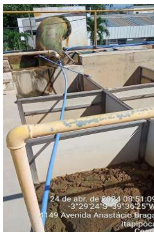
Foto 59 - ETA-02 (Sede): floculadores, decantadores e filtros com pintura desgastada e decantadores.
