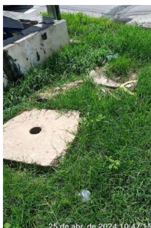
Foto 113 EERD-01 (Sede): reboco e pintura deteriorados; caixas de inspeção danificadas e cobertas por vegetação.
