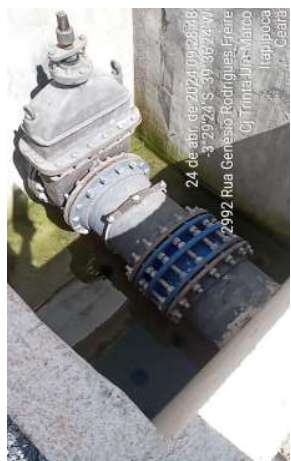
Foto 73 - RSE-01 (ETA-02) (Sede): caixas com inundadas; escada inadequada e tampa de inspeção deteriorada.
