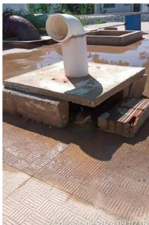
Foto 17 - ETA-02/REN-01 (Sede): reservatório não tem controle de nível e água transborda, inundando e lavando a laje de cobertura, cuja água retorna para dentro do mesmo, por meio da chaminé da abertura de inspeção que está quebrada; tubulação por sobre a laje de cobertura.
