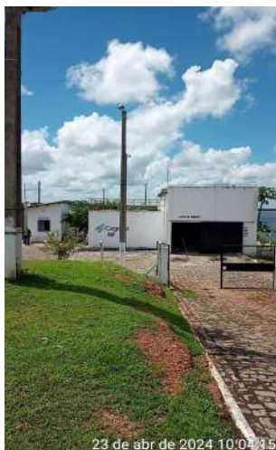
Foto 1 - Manancial / Captação Gameleira (Sede): sem placa indicativa de ser área de preservação e destinada ao abastecimento de água.
