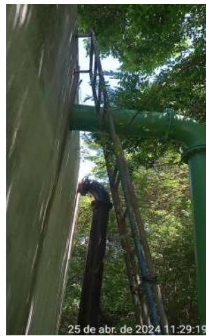
Foto 120 RAP-03 (Sede): vegetação crescida, escada tipo marinheiro solta, pintura e identificação desgastados
