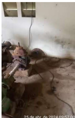
Foto 109 - RAP-04 / EEAT-04 (Sede): ambiente sujo da casa de bombas; quadro de comando com apoio improvisado; instalações elétricas precárias com fiação/cabos soltos sobre o piso.
