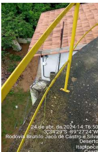
Foto 35 - ETA / RAP-01 (Deserto): sem ventilação; cabos elétricos inadequados soltos sobre a laje e enrolados na grade de proteção, sem eletroduto de isolamento e proteção.
