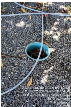
Foto 53 - ETA-02 (Sede): caixas de proteção e inspeção deterioradas (soterradas, inundadas, tomadas por vegetação, quebradas e com tampas danificadas).
