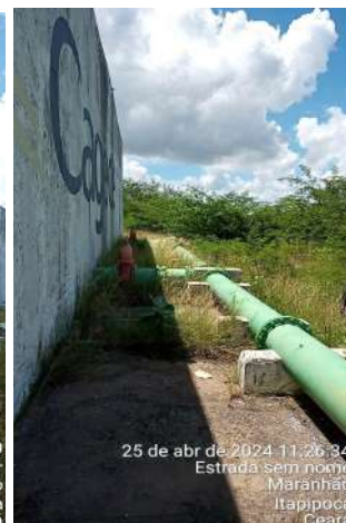
Foto 32 - RAP-03 (Sede): sem infraestrutura de isolamento e proteção.
