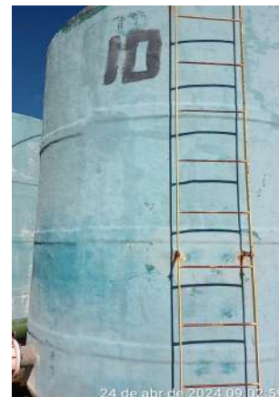
Foto 16 - ETA-02 / Filtros F-09 a F-11 (Sede): sem escadas ou escadas tipo marinheiro inadequadas, sem guarda-corpo acima do patamar superior da estrutura e sem gaiola de proteção.
