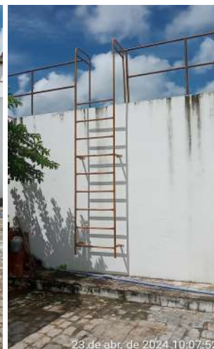
Foto 2 - Manancial / Captação Gameleira (Sede): RAP-06 sem identificação e escada tipo marinheiro sem gaiola de proteção.
