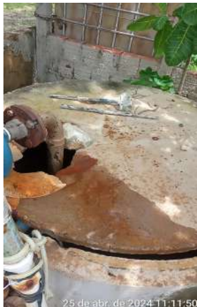
Foto 115 - EERD-03 (Sede): infraestrutura de isolamento e proteção deteriorada; abertura na laje sem fechamento hermético.
