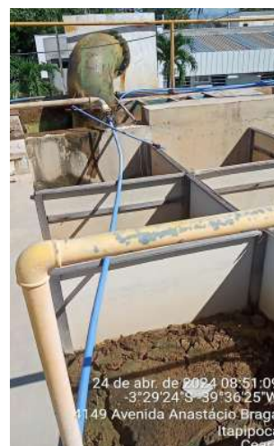
Foto 10- ETA-02 (Sede): tubulações conduzidas por sobre o piso da passarela ou cruzando a mesma e obstruindo a passagem.
