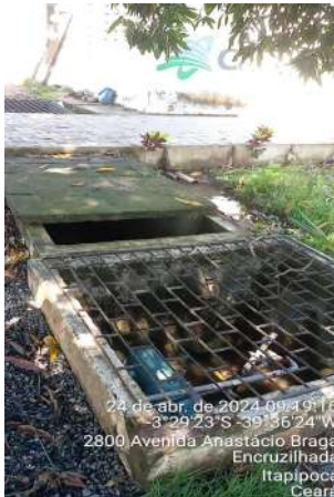
Foto 53 - ETA-02 (Sede): caixas de proteção e inspeção deterioradas (soterradas, inundadas, tomadas por vegetação, quebradas e com tampas danificadas).
