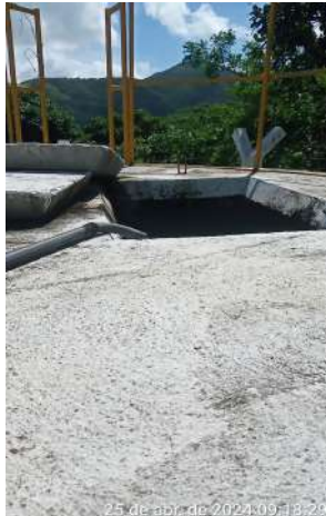
Foto 103 - RAP's (Estrada da Serrinha) (Sede): vegetação crescida; tampa da abertura fora do lugar e/ou sem fechamento hermético.
