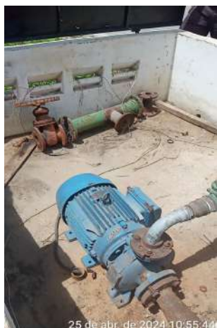
Foto 117 EERD-SN (Sede): pintura desgastada e sem identificação; área com sujeira e sobras de material deixados no local; dobradiças da tampa quebradas.
