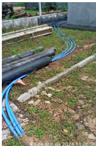
Foto 141 - ETA/Cloração (Lagoa da Cruz): tubulações de cloração/produtos químicos inadequadas, instaladas sobre o solo da área de circulação e suspensa sem fixação adequada; ponto de pré-cloração sem caixa de inspeção e proteção.
