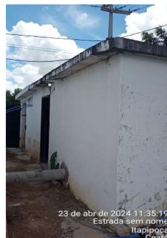
Foto 36 - ETA/Casa de Bombas (Lagoa da Cruz): sem identificação.
