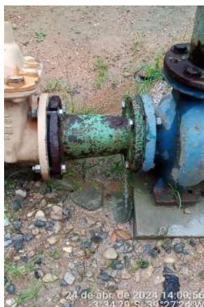
Foto 127 ETA/Filtros (Deserto): conjunto motor-bomba de lavagem dos filtros com vazamento.
