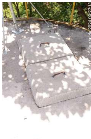
Foto 104 - RAP's (Estrada da Serrinha) (Sede): tampas da abertura fora do lugar e/ou sem fechamento hermético.
