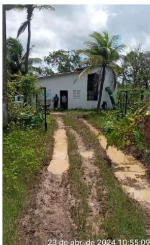
Foto 3 - Manancial / Captação Poço Verde (Sede): falta de identificação da área.
