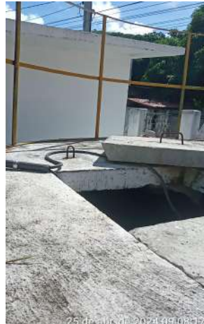
Foto 104 - RAP's (Estrada da Serrinha) (Sede): tampas da abertura fora do lugar e/ou sem fechamento hermético.
