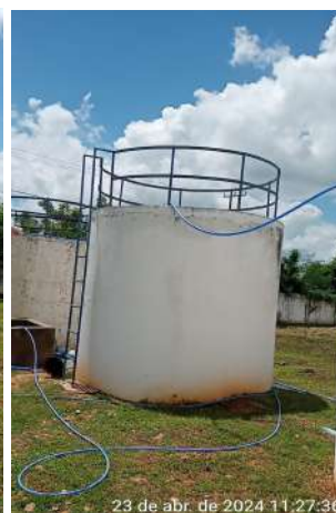
Foto 142 - ETA/Cloração (Lagoa da Cruz): tubulações de cloração/produtos químicos inadequadas, instaladas sobre o solo da área de circulação e suspensa sem fixação adequada; ponto de pré-cloração sem caixa de inspeção e proteção.
