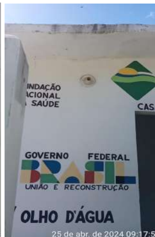
Foto 106 - RAP's (Estrada da Serrinha) (Sede): casa do quadro do comando e iluminação externa sem lâmpada.
