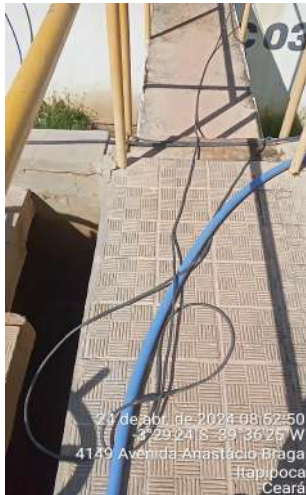
Foto 9 - ETA-02 (Sede): tubulações conduzidas por sobre o piso da passarela ou cruzando a mesma e obstruindo a passagem.
