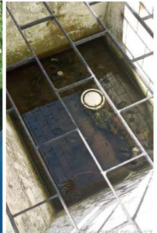
Foto 52 - ETA-02 (Sede): caixas de proteção e inspeção deterioradas (soterradas, inundadas, tomadas por vegetação, quebradas e com tampas danificadas).
