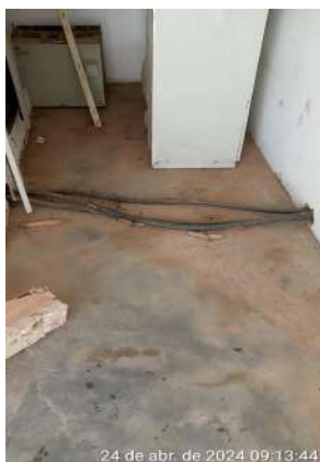
Foto 67 - EEAT-03 (ETA-02) (Sede): instalações elétricas inadequadas sobre o piso, através do vão da porta de entrada, com cabos/fiação elétricos sem eletrodutos ou calhas de isolamento e proteção; caixa de passagem elétrica no piso inundada e sem tampa.
