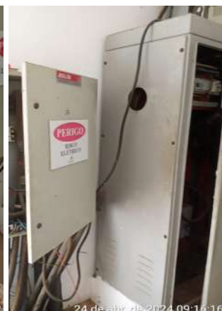
Foto 69 - EEAT-03 (ETA-02) (Sede): instalações elétricas inadequadas; disjuntor instalado em caixa sem tampa e banco capacitor instalado de forma improvisada em cima do quadro de comando.
