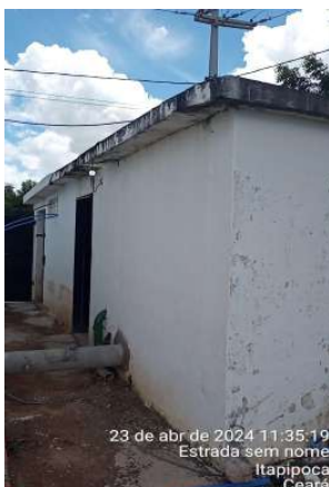
Foto 133 ETA/Casa de Bomba (Lagoa da Cruz): pintura desgastada, instalações elétricas precárias com fios/cabos com pontas soltas, caixas elétricas e/ou interruptores danificados ou sem tampas.
