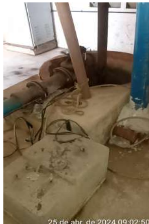
Foto 99 - EERD-02 (Sede): infraestrutura necessitando de manutenção e limpeza, parede rachada, pintura deteriorada e área com sujeira; instalações elétricas precárias, com eletrodutos danificados, fiação solta e exposta.
