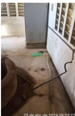
Foto 99 - EERD-02 (Sede): infraestrutura necessitando de manutenção e limpeza, parede rachada, pintura deteriorada e área com sujeira; instalações elétricas precárias, com eletrodutos danificados, fiação solta e exposta.
