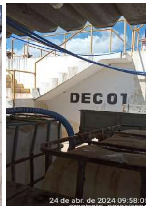
Foto 80 - Mini Laboratório (ETA-02) (Sede): tubulação hidráulica de produtos químicos instalados de forma precária e improvisada por sobre os tanques de dosagem e viga do telhado.
