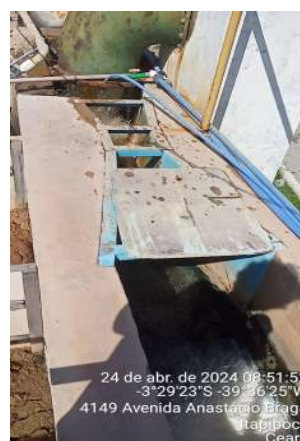
Foto 58 - ETA-02 (Sede): floculadores, decantadores e filtros com pintura desgastada; vegetação crescida próxima aos filtros e decantadores.
