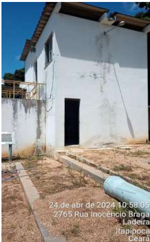
Foto 27 - ETA-01 (Sede): casa dos registros/filtros/laboratório sem identificação.
