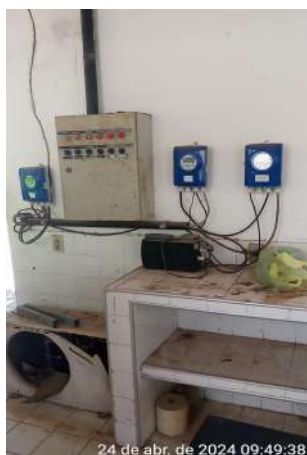
Foto 75 - Sala Macromedição (ETA-02) (Sede): os totalizadores/registradores da macromedição estão instalados no prédio da ETA-Piloto (desativada), cujo ambiente encontrava-se sujo e com materiais armazenados e/ou abandonados
