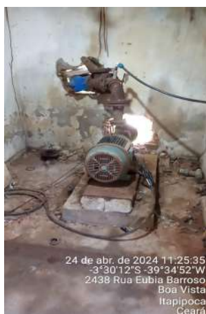
Foto 97 - Casa de Bombas (Sede): com sujeira acumulada; instalações elétricas precárias, sem eletroduto de isolamento e proteção; parede com buraco sem acabamento e dispositivos danificados.
