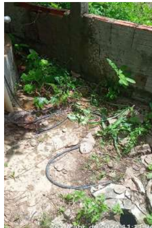
Foto 116 - EERD-03 (Sede): vegetação crescida; quadro de comando deteriorado pela corrosão e fiação/cabos elétricos inadequados, sobre o piso e sem eletroduto de isolamento e proteção.
