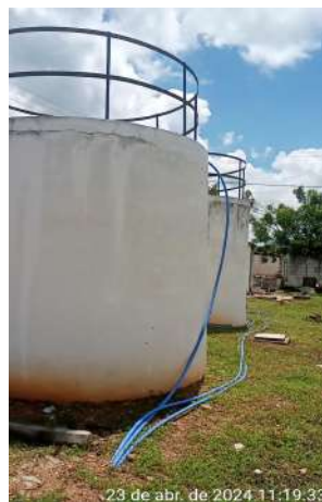
Foto 142 - ETA/Cloração (Lagoa da Cruz): tubulações de cloração/produtos químicos inadequadas, instaladas sobre o solo da área de circulação e suspensa sem fixação adequada; ponto de pré-cloração sem caixa de inspeção e proteção.
