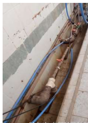
Foto 80 - Mini Laboratório (ETA-02) (Sede): tubulação hidráulica de produtos químicos instalados de forma precária e improvisada por sobre os tanques de dosagem e viga do telhado.
