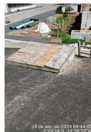
Foto 74 - RSE-01 (ETA-02) (Sede): caixas com acúmulo de entulho e escada inadequada e tampa de inspeção deteriorada.
