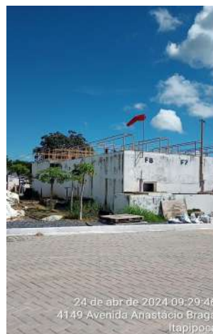
Foto 60 - ETA-02 (Sede): floculadores, decantadores e filtros com pintura desgastada; vegetação crescida próxima aos filtros e decantadores.
