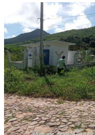
Foto 102 - RAP's (Estrada da Serrinha) (Sede): vegetação crescida; casa do quadro do comando e iluminação externa sem lâmpada.
