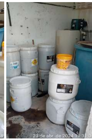
Foto 138 - ETA/Casa de Química (Lagoa da Cruz): o sistema de dosagem de produtos químicos está instalado de maneira inadequada.
