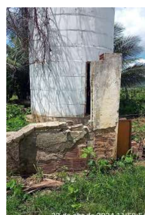
Foto 148 - REL-01 (Lagoa da Cruz): mureta deteriorada, cerca danificada e área com vegetação crescida; não há iluminação para trabalhos noturnos; área sendo utilizada para criação de porcos.
