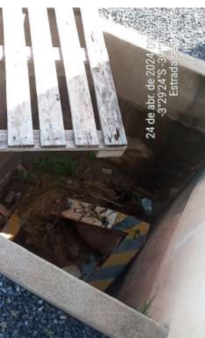
Foto 23 - ETA-02 / RSE-01 (Sede): sem ventilação e caixas sem tampas.
