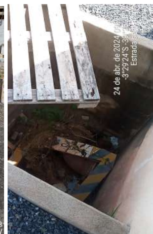
Foto 74 - RSE-01 (ETA-02) (Sede): caixas com acúmulo de entulho e escada inadequada e tampa de inspeção deteriorada.
