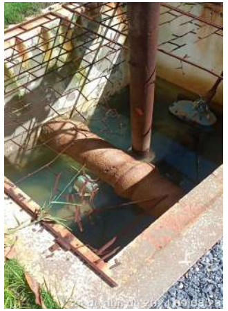
Foto 54 - ETA-02 (Sede): caixas de proteção e inspeção deterioradas (soterradas, inundadas, tomadas por vegetação, quebradas e com tampas danificadas).
