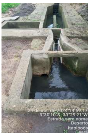
Foto 151 - ETE (Deserto): infraestrutura do tratamento primário precária, sem pavimentação das áreas laterais e grade de isolamento e proteção, sem divisórias de isolamento das caixas de areias
