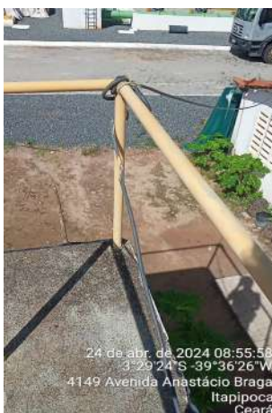
Foto 11- ETA-02 (Sede): instalações elétricas inadequadas com cabos/fiação sem eletrodutos de isolamento e proteção, conduzidos pelas grades de proteção e por sobre o piso das passarelas.
