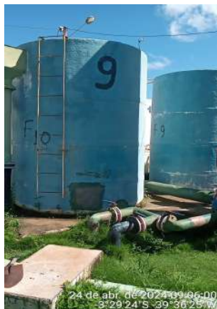
Foto 15 - ETA-02 / Filtros F-09 a F-11 (Sede): sem escadas ou escadas tipo marinheiro inadequadas, sem guarda-corpo acima do patamar superior da estrutura e sem gaiola de proteção.
