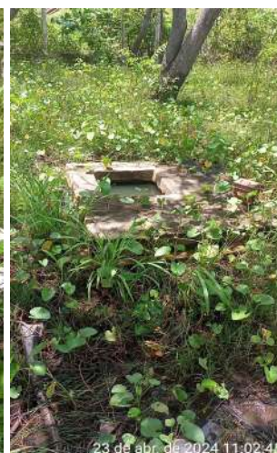
Foto 4 - Manancial / Captação Poço Verde (Sede): caixas sem tampa de proteção.
