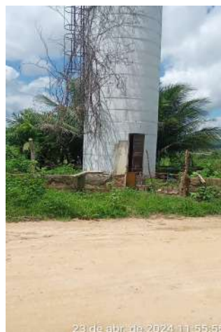
Foto 42 - REL-01 (Lagoa da Cruz): não há iluminação para trabalhos noturnos.
