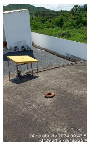
Foto 22 - ETA-02 / RSE-01 (Sede): sem ventilação e caixas sem tampas.
