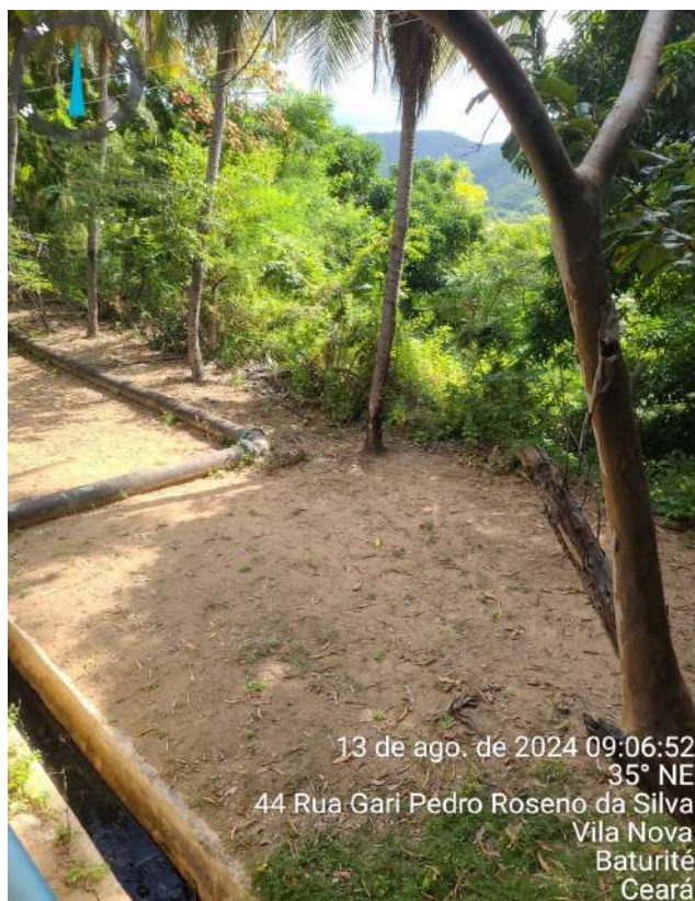
Foto 33 - ETA: ausência de delimitação em alguns pontos da área da estação e presença de vegetação nas estruturas internas.
