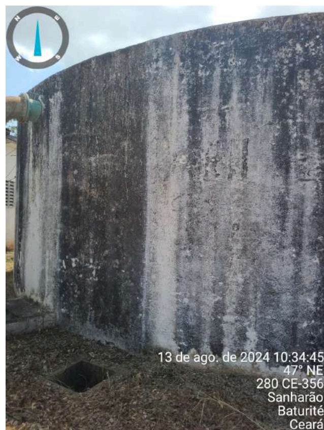
Foto 10 - RAP-04 e EEAT-05: caixas de inspeção sem tampas.
