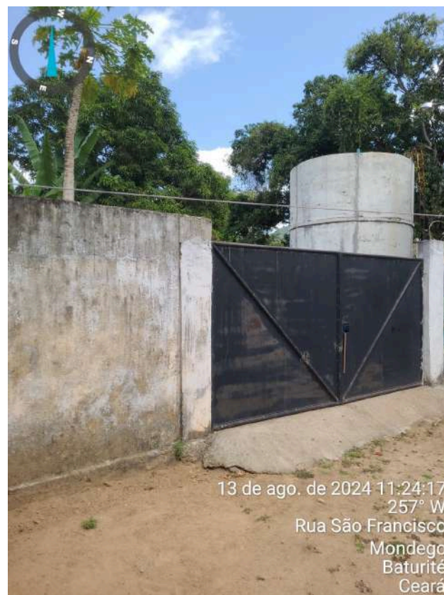
Foto 12 - ETE São Francisco: não possui identificação.
