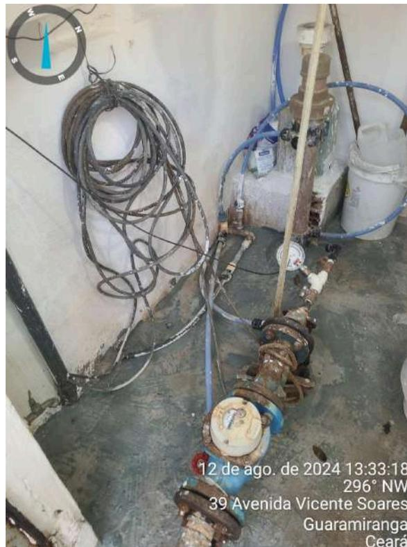
Foto 2 - PT-01: instalações elétricas inadequadas.
