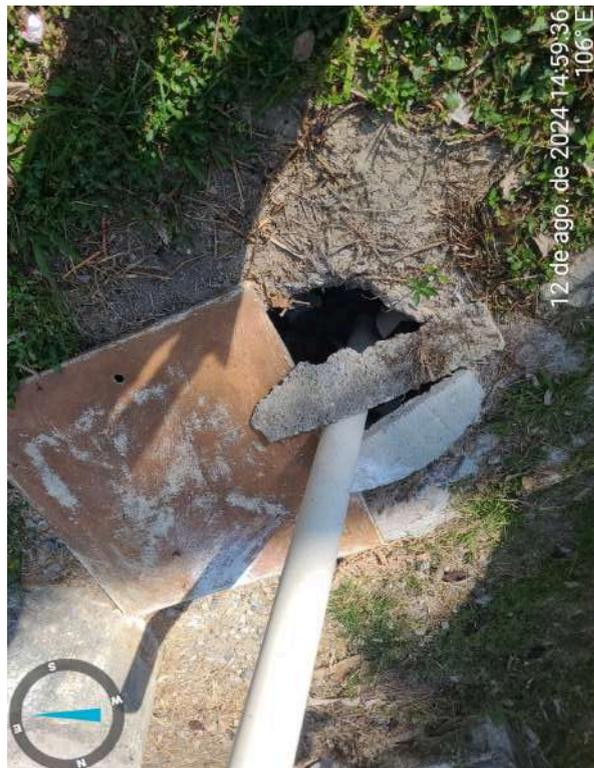
Foto 6 - ETE - Forquilha: caixa de visita com tampa inadequada.
