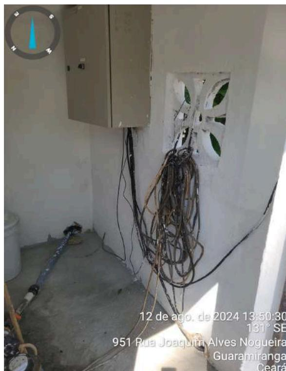
Foto 4 - PT-02: instalações elétricas são inadequadas.
