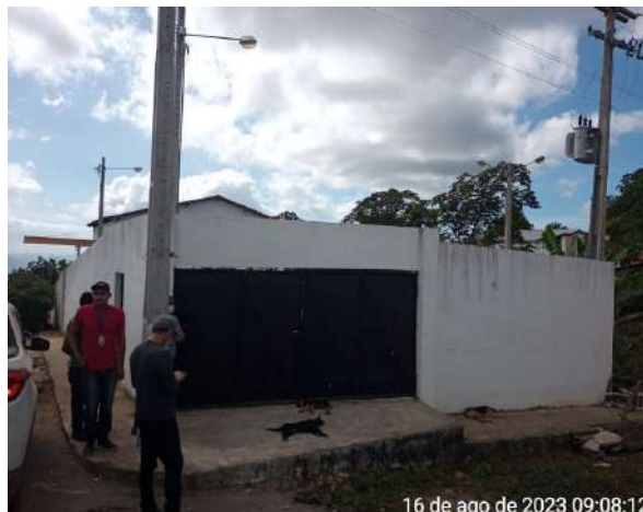
Foto 6 - EEE-04: ausência de identificação.
