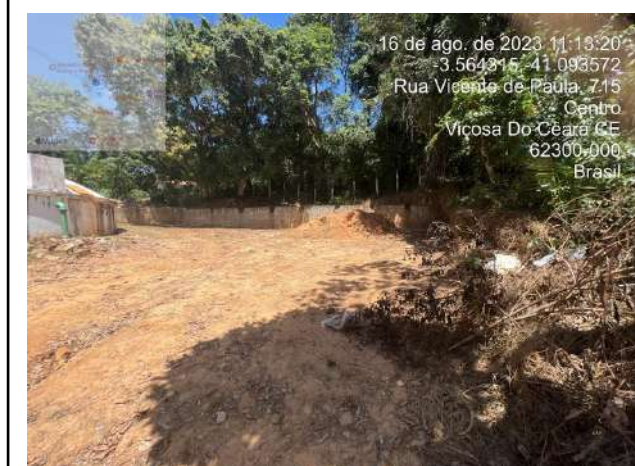
Foto 9 - RAP-06: ausência de parte da cerca de proteção.
