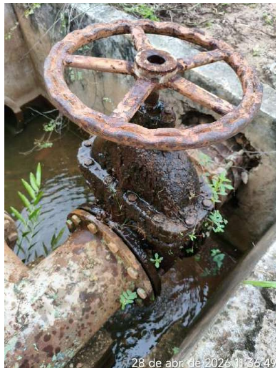
Foto 63 - ETA / Filtros (Trairi): vazamento em registro.
