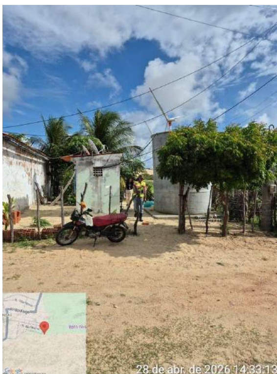
Foto 44 - ETA / Pátio ( Mundaú ): ausência de identificação visual na unidade; isolamento perimetral precário e sem instalações mínimas de apoio ao operador.
