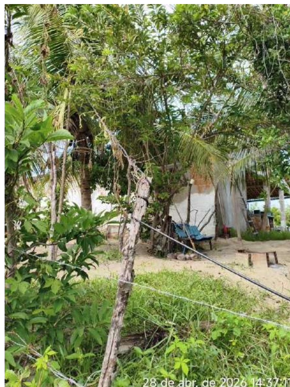
Foto 43 - Captação ( Mundaú ): Cabeamento elétrico dos poços inadequado.
