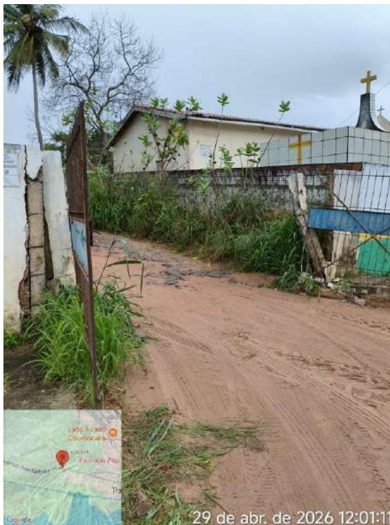
Foto 54 - ETE (Trairi): sem identificação; não existe casa de apoio ao operador; não há iluminação.
