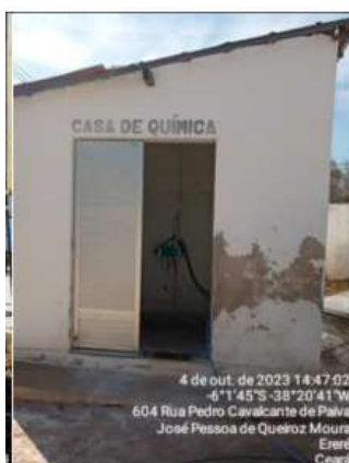
Foto 5 - Laboratório: infraestrutura em reforma, funcionando temporariamente em outro ambiente.
