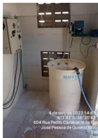
Foto 6 - Laboratório: infraestrutura em reforma, funcionando temporariamente em outro ambiente.
