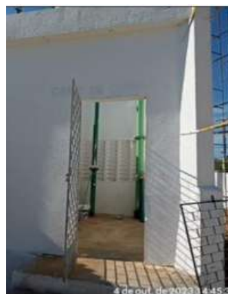
Foto 4 - Laboratório: infraestrutura em reforma, funcionando temporariamente em outro ambiente
