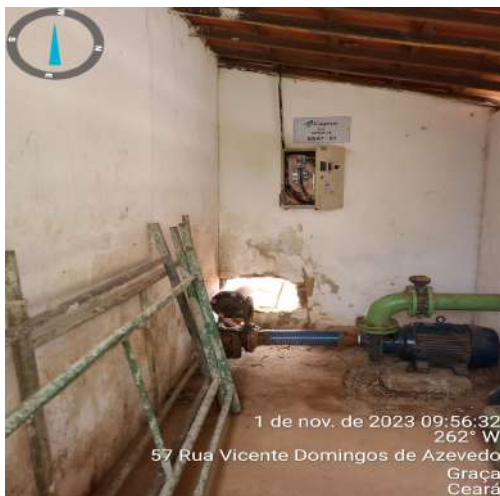
Foto 1 - EEAT-1 (Sede): alvenaria incompleta e pintura desgastada.
