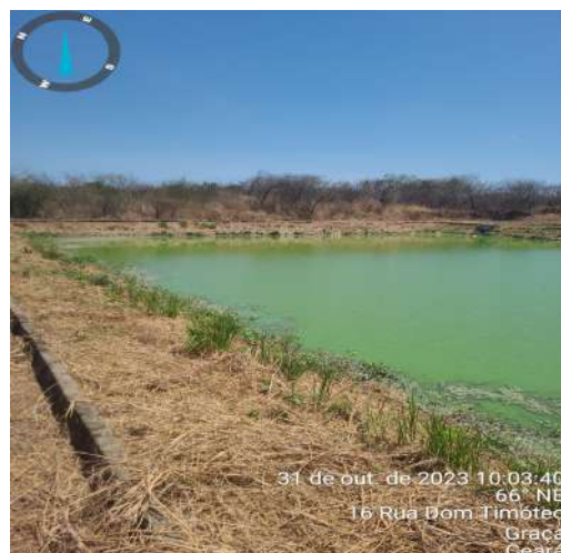
Foto 14 - ETE (Sede): lagoa com vegetação nos taludes.
