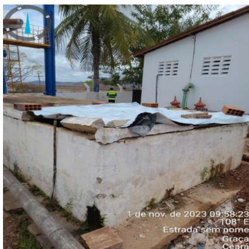
Foto 3 - RAP-3 (Sede): ausência de identificação, tampa sem vedação e pintura desgastada.
