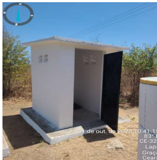
Foto 8 - PT-8 (Lapa): ausência de cerca de delimitação.
