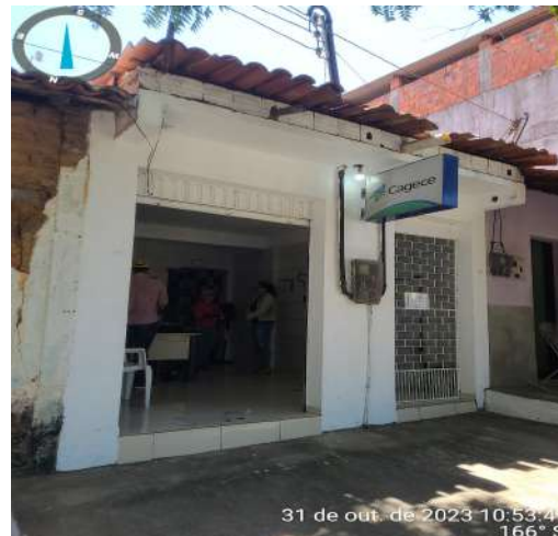
Foto 22 - Escritório (Lapa): ausência de acessibilidade.
