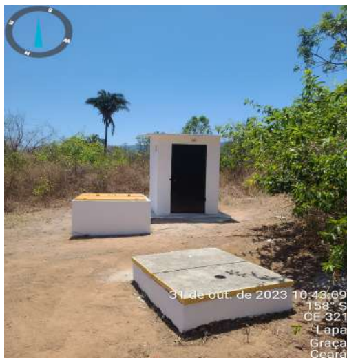
Foto 7 - PT-7 (Lapa): ausência de cerca de delimitação.
