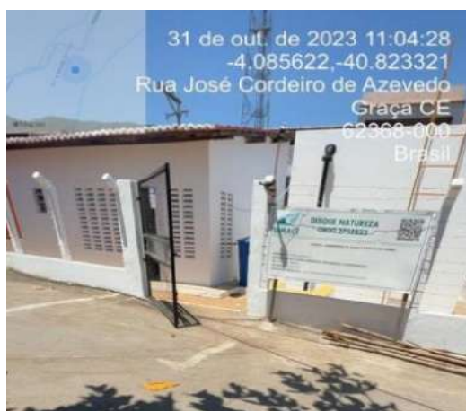
Foto 9 - RAP-1 e EEAT-1 (Lapa): ausência de identificação.
