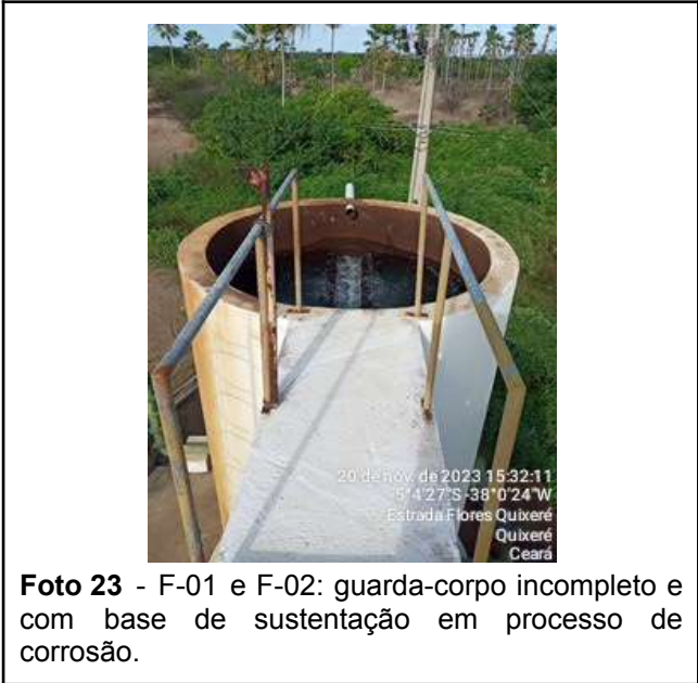
Foto 24 - F-01 e F-02: guarda-corpo incompleto e com base de sustentação em processo de corrosão.
