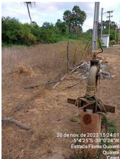
Foto 3 - PT-10: sem tamponamento.
