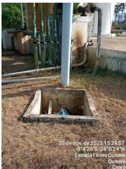
Foto 5 - ETA: caixa sem tampa.
