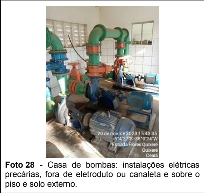
Foto 26 - Casa de bombas: instalações elétricas precárias, fora de eletroduto ou canaleta e sobre o piso e solo externo.
