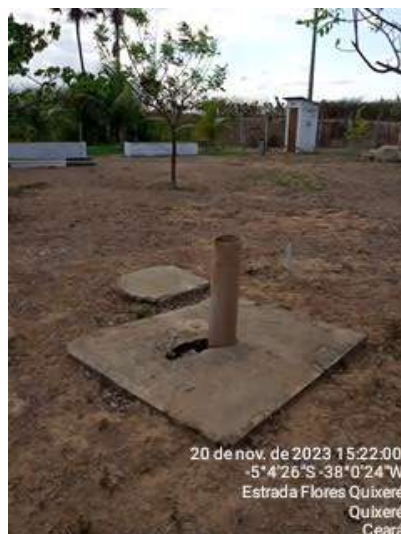
Foto 2 - PT-09: sem tamponamento.
