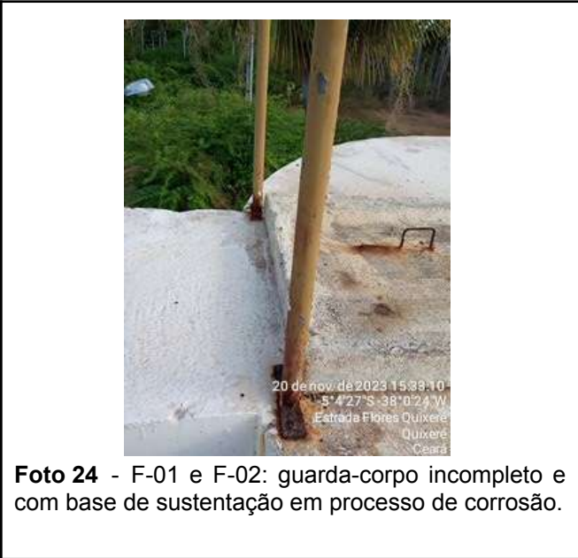
Foto 23 - F-01 e F-02: guarda-corpo incompleto e com base de sustentação em processo de corrosão.
