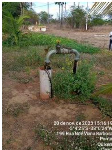
Foto 4 - PT-12: sem tamponamento.
