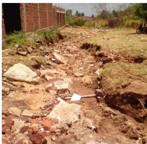
Figura 4.10 - Erosão de via pública não pavimentada e Ocupação próxima ao rio
