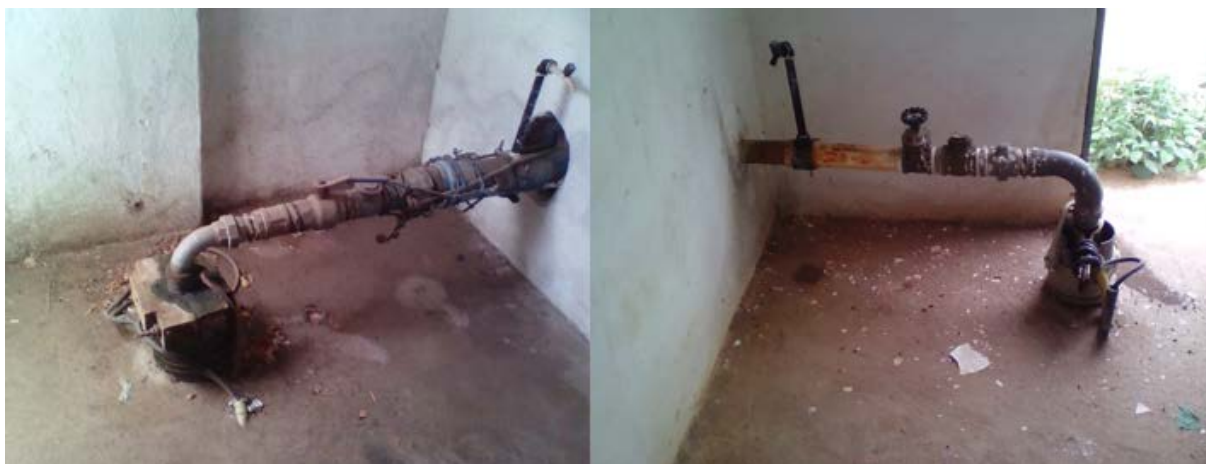
Figura 4.2 - Poço PT-01 e Poço PT-04
