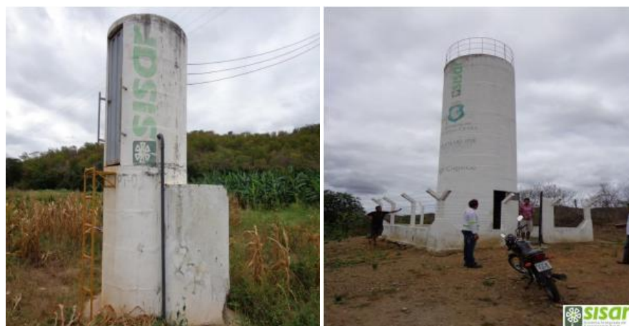
Figura 4.11 – Captação no PA e Reservatório Elevado do SAA do Riachão II.
