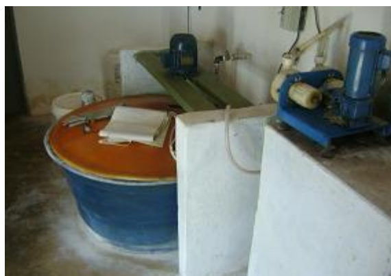
Figura 4.4 – Tanque com bomba dosadora para aplicação de hipoclorito de cálcio no RAP-01
