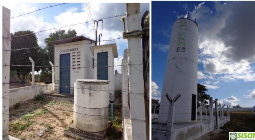
Figura 4.13 – Captação PT e Reservatório Elevado. Santo Antônio – Barro/CE
