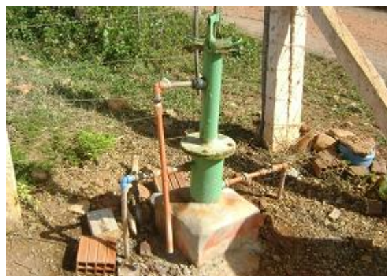
Figura 4.5 – Kit de cloração utilizando tabletes de hipoclorito de cálcio, localizado na tubulação de recalque do PT-05.
