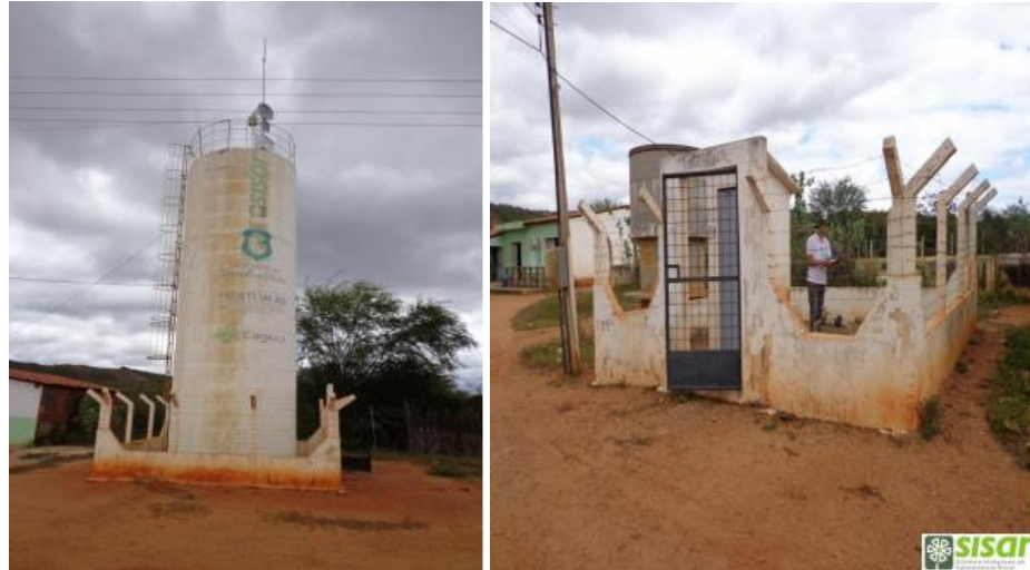
Figura 4.9 – Reservatório Elevado e Captação no PT do SAA Riachão I.
