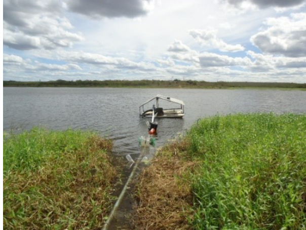
Figura 4.12 - Captação no Açude São Domingos
