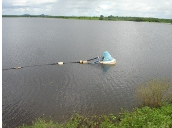
Figura 4.8 – Captação do sistema de abastecimento do distrito Campos Belos
