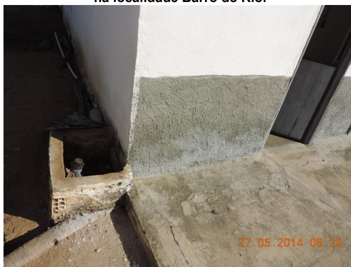
Figura 5.14: Hidrômetro indicando existência de rede na localidade Barra do Rio.
