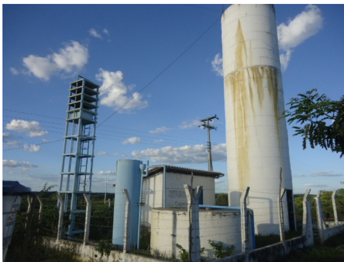
Figura 5.16: reservatório em Pocinhos.
