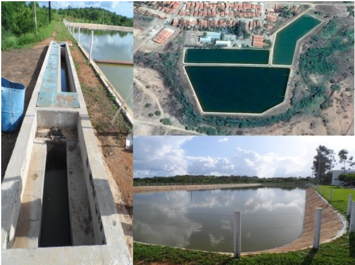
Figura 5.26: Imagens de satélite e in situ do sistema de lagoas de estabilização da ETE – Maratoan .
