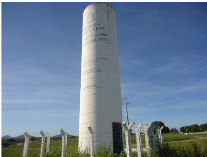
Figura 5.17: Reservatório em Boa Vista.
