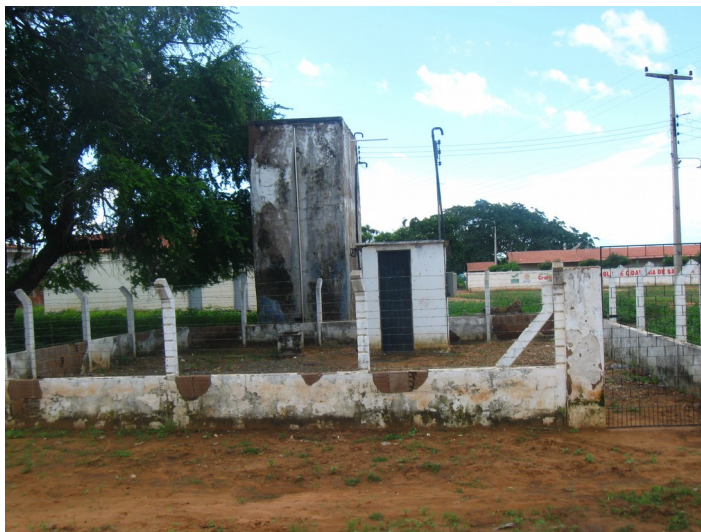
Figura 5.20: Reservatório em Santana.
