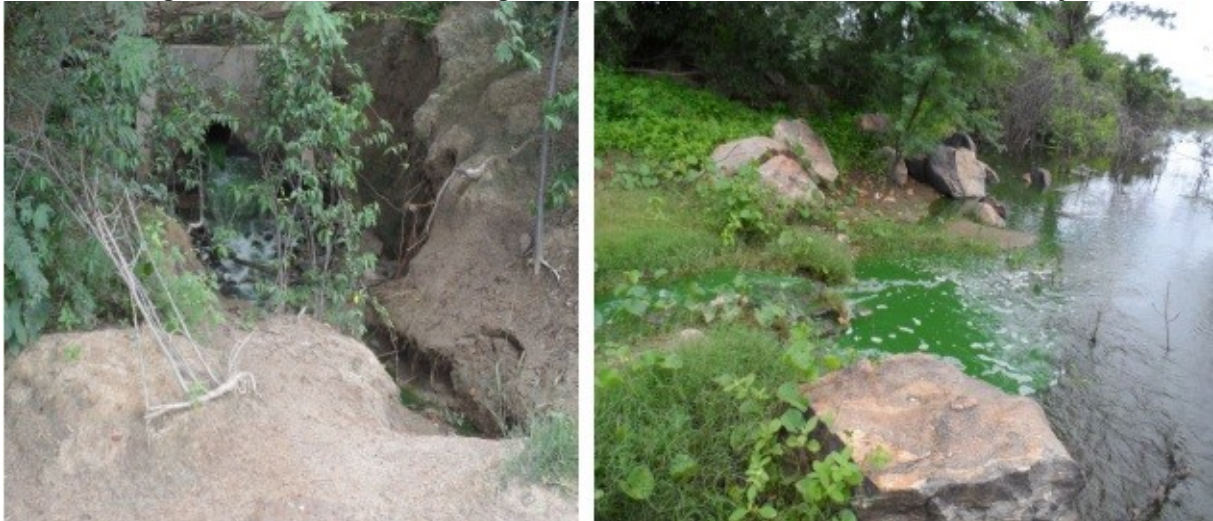
Figura 5.29: Local de descarga do efluente da ETE-Revoltosos no rio Poty.
