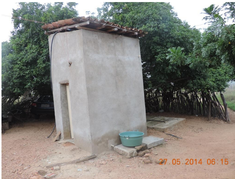
Figura 5.35: Banheiro residencial na localidade Buqueirão dos Galdinos.
