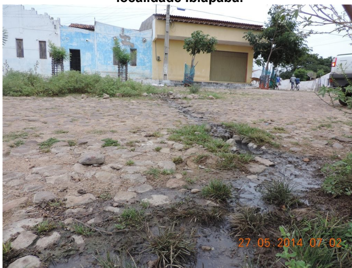
Figura 5.34: Destinação inadequada das águas servidas na localidade Ibiapaba.
