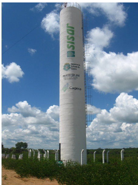
Figura 5.18: Reservatório em Xavier.
