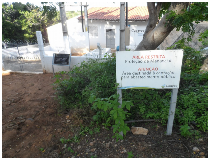
Figura 5.5: Perímetro de proteção sanitária próximo à captação.
