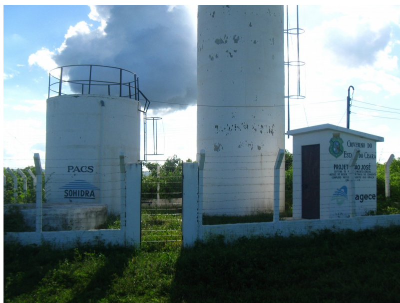
Figura 5.19: Reservatório em Convento.
