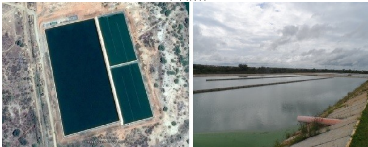
Figura 5.28: Imagens de satélite e in situ do sistema de lagoas de estabilização da ETE – Revoltosos.
