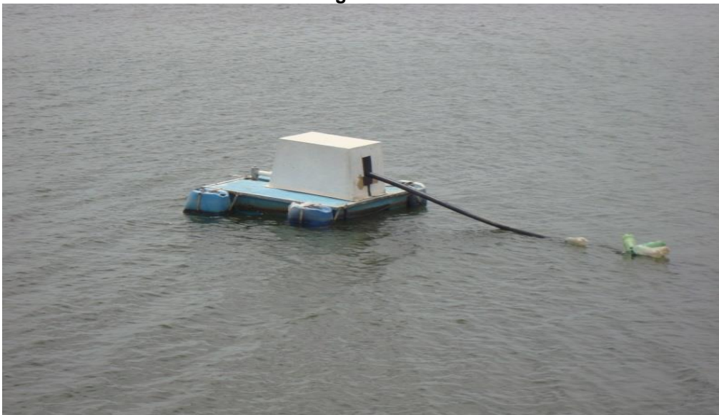
Figura 5.48: Bomba de recalque flutuante utilizado para abastecer o Distrito de São Miguel
