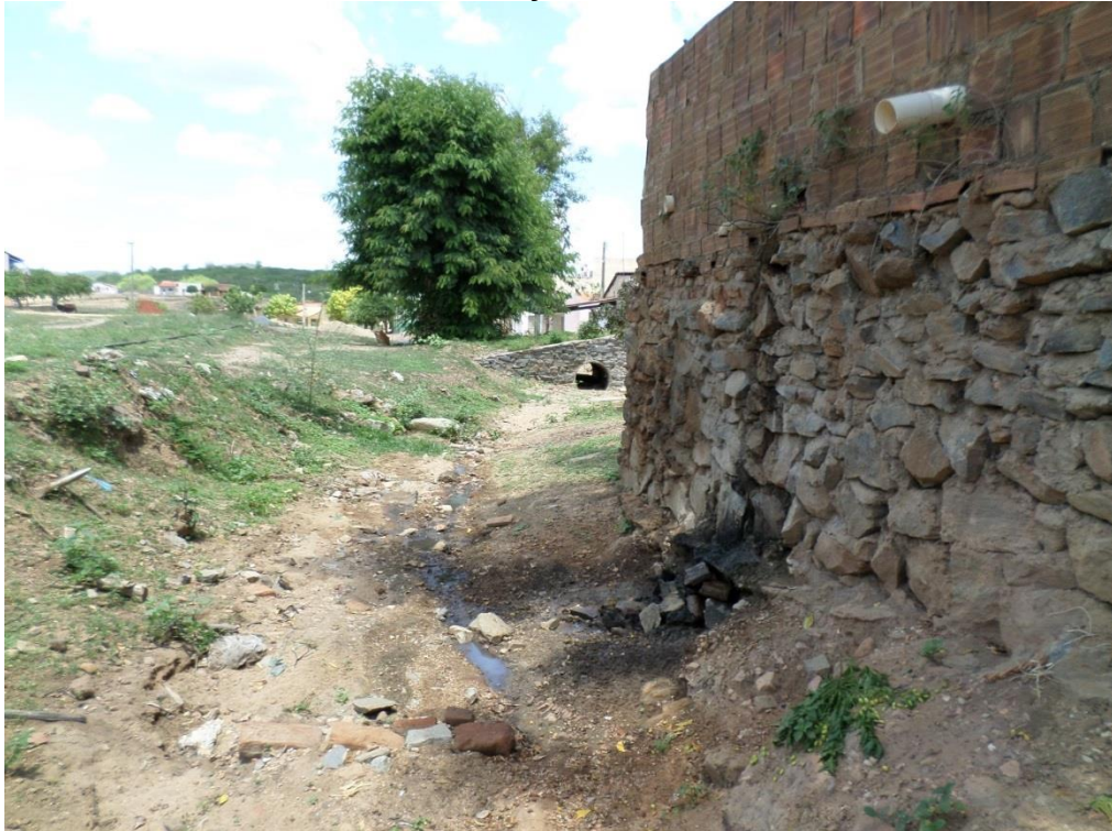
Figura 6.18: Águas negras lançadas na via pública no Distrito de Várzea da Conceição
