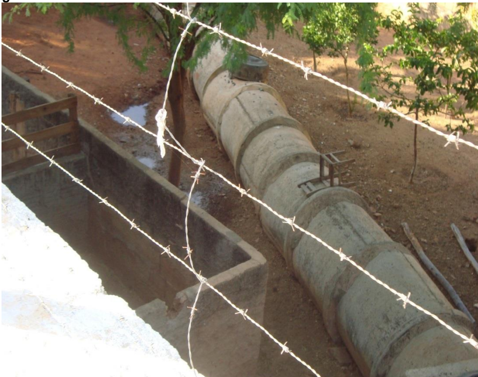
Figura 6.3: ETE 01 – Emissário dos efluentes da ETE 01 á ETE 03
