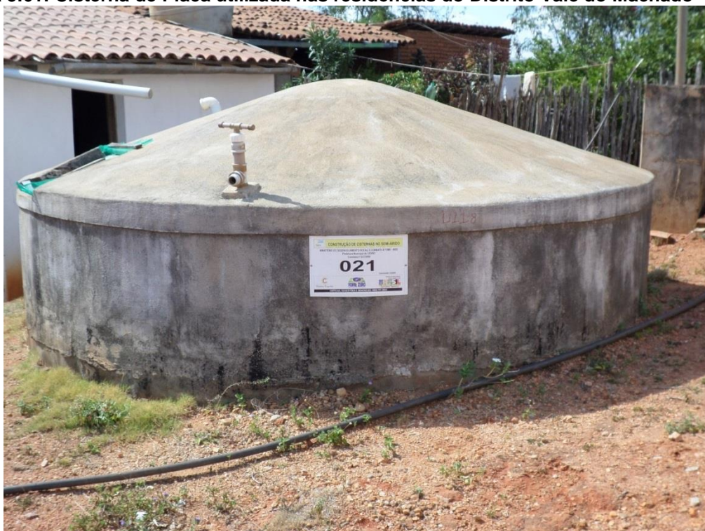
Figura 5.61: Cisterna de Placa utilizada nas residências do Distrito Vale do Machado
