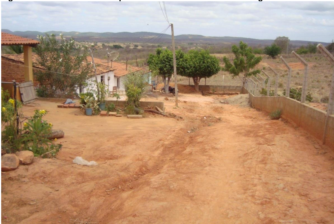
Figura 8.20: Indícios de erosão pluvial nas vias do Distrito de São Miguel
