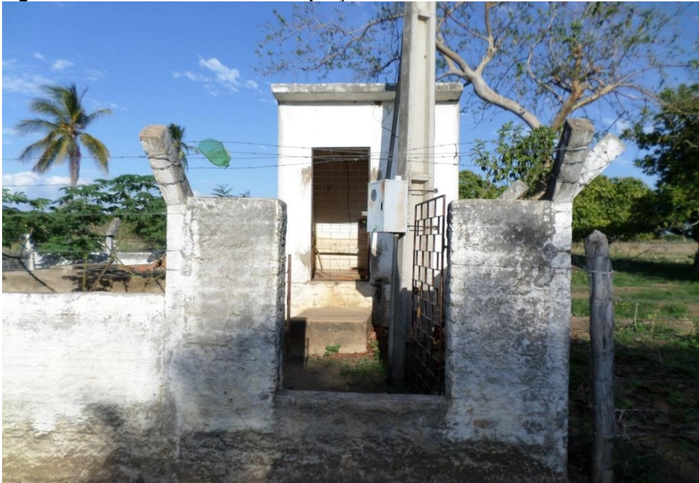
Figura 5.34: Entrada da Casa de Captação do Distrito de Santo Antônio
