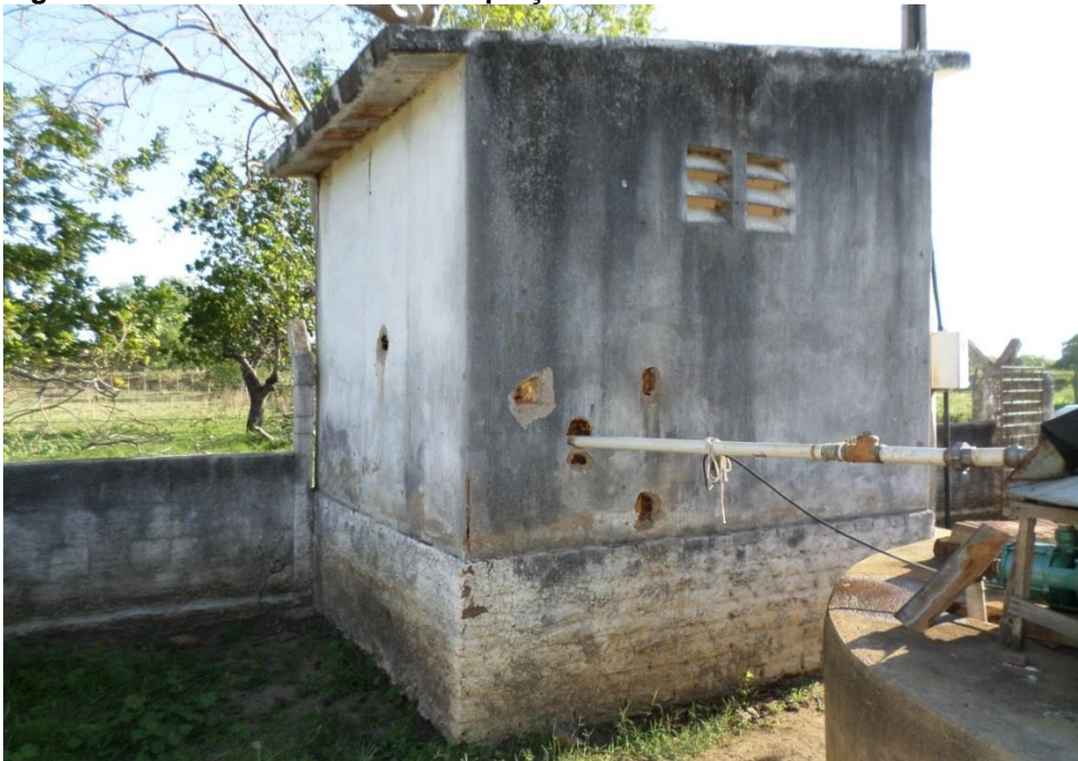
Figura 5.35: Fundos da Casa de Captação do Distrito de Santo Antônio
