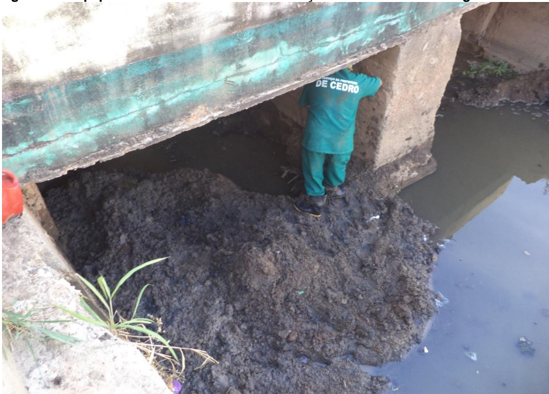
Figura 8.1: Equipe da Prefeitura realizando correção no sistema de drenagem de Cedro.
