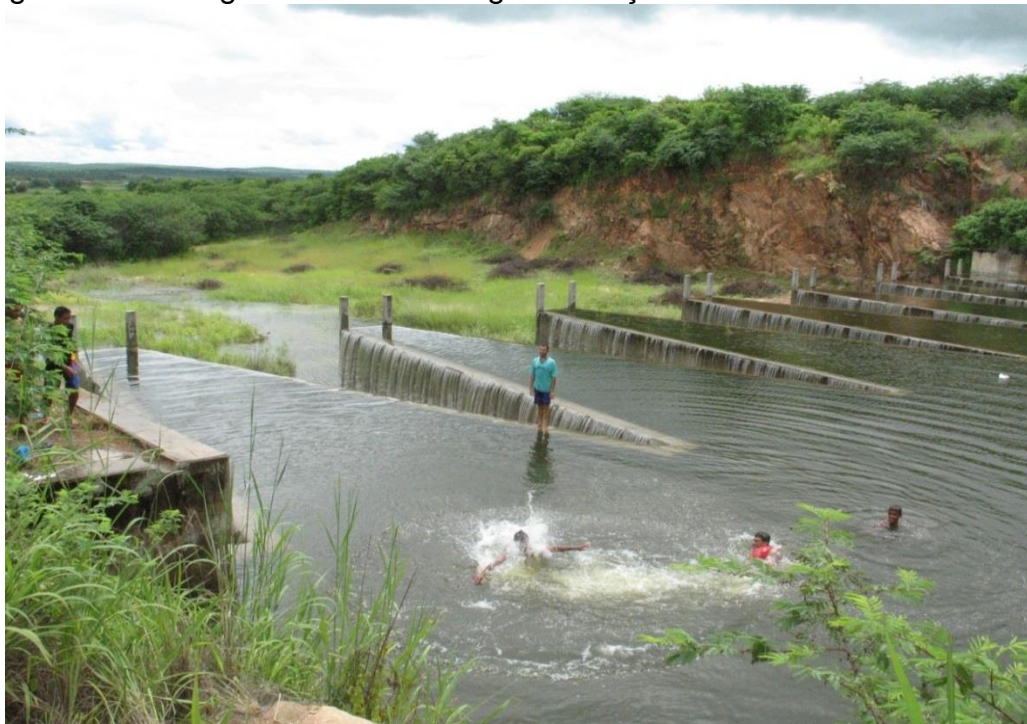
Figura 5.11: Sangradouro da Barragem do Açude Ubaldinho
