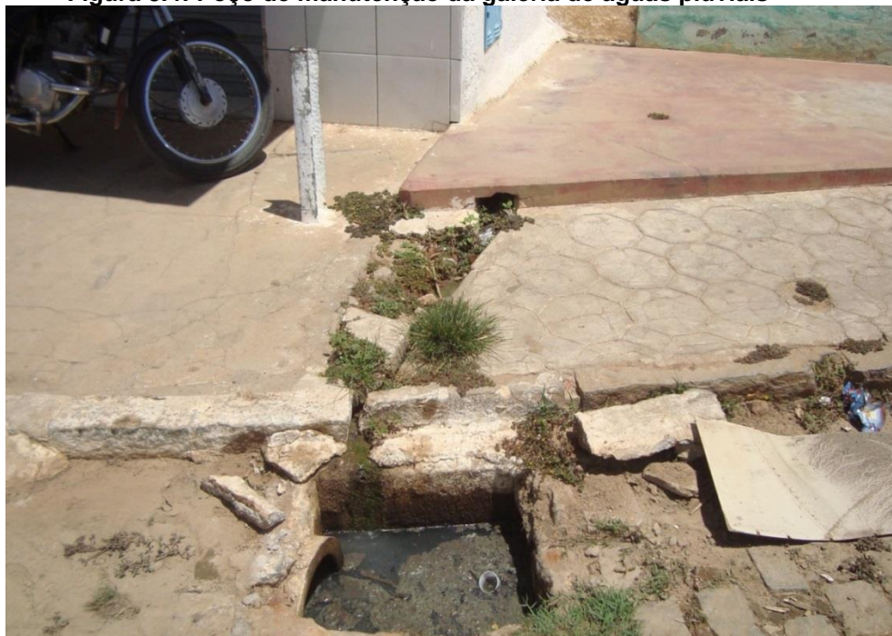
Figura 8.4: Poço de manutenção da galeria de águas pluviais
