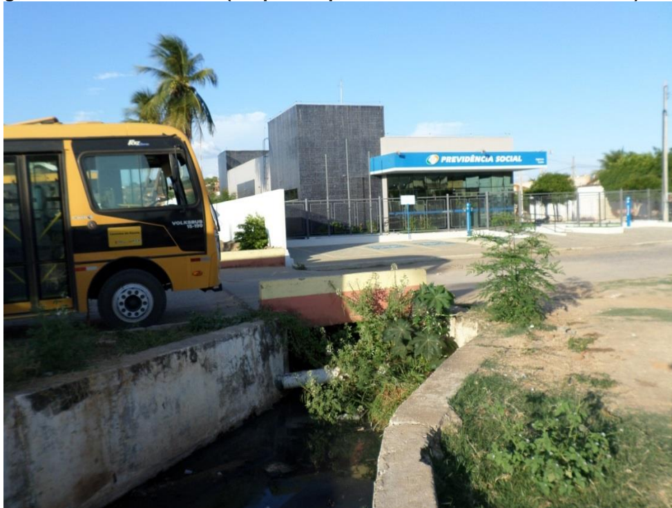
Figura 6.11: Canal da sede (Corpo receptor do efluente oriundo da ETE 04)
