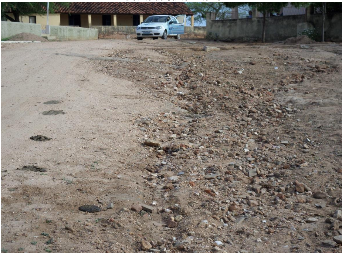
Figura 8.14: Ruas Não Pavimentadas com Solos argilosos e afloramento de seixos no distrito de Santo Antônio
