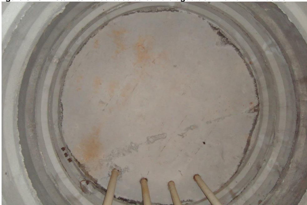
Figura 5.45: Vista interna da base da caixa d'água do EE 02 em Candeias
