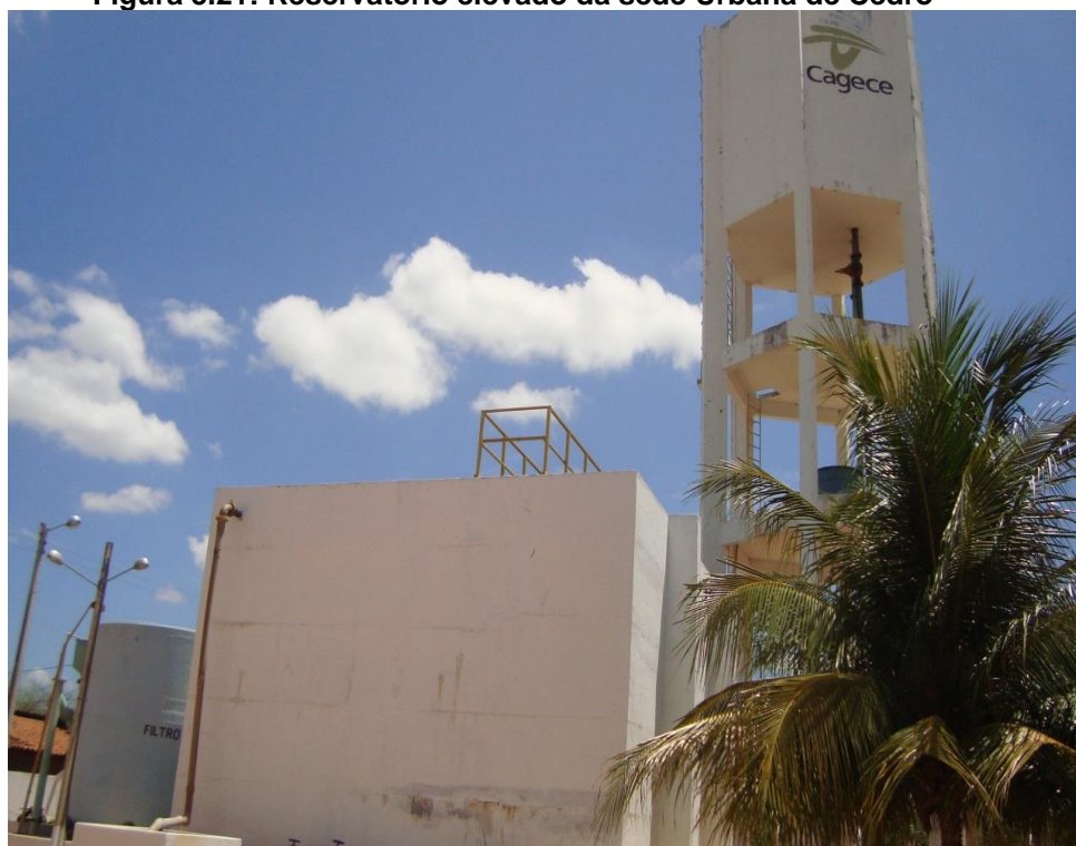
Figura 5.21: Reservatório elevado da sede Urbana de Cedro
