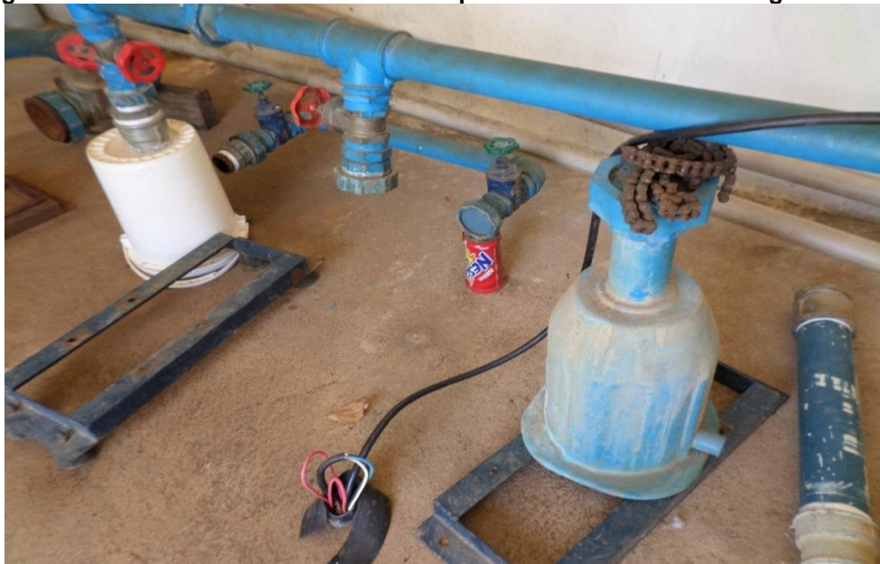
Figura 5.30: Sucateamento da Sala de Máquinas da ETA-EEAT em Angico II
