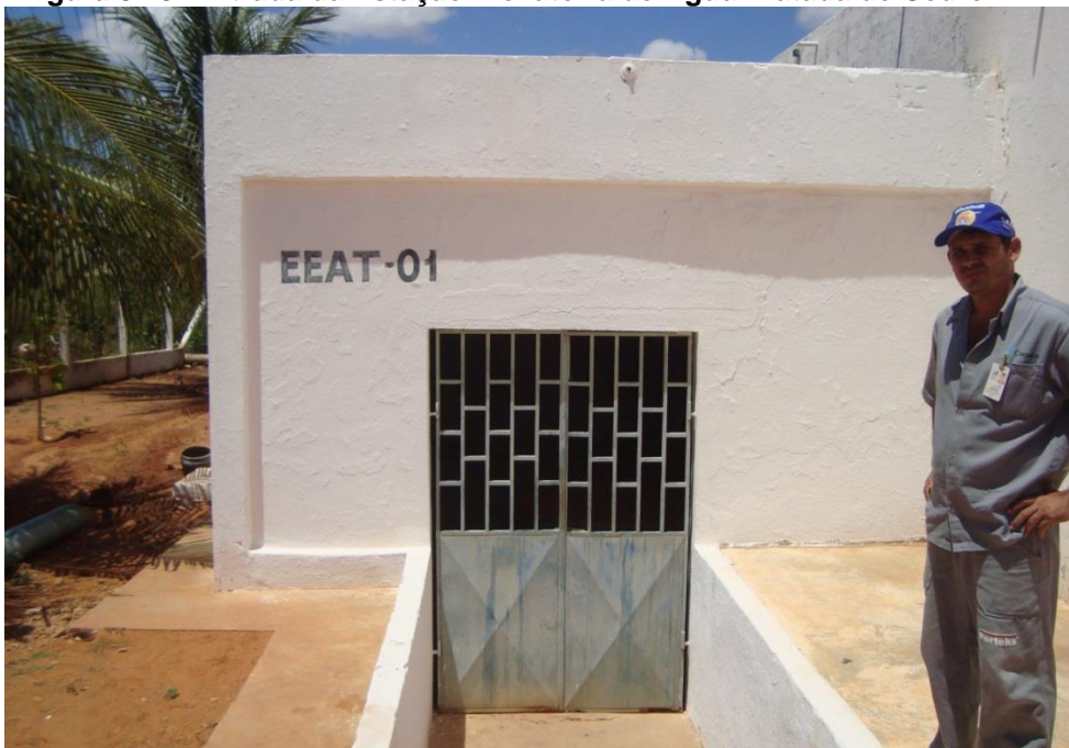
Figura 5.23: Entrada da Estação Elevatória de Água Tratada de Cedro
