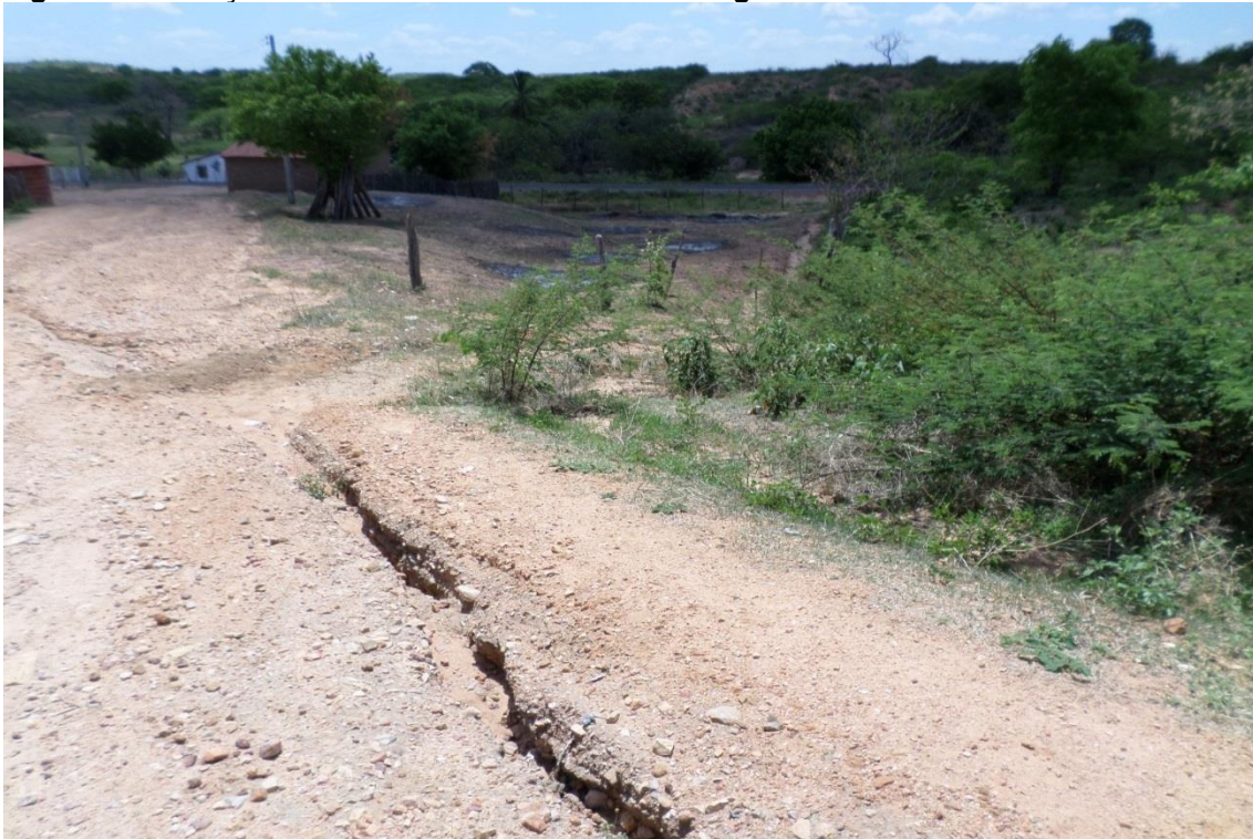
Figura 8.17: Traços erosivos na via do distrito de Lagedo.
