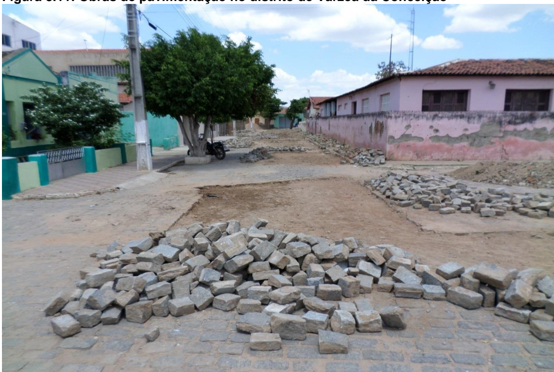
Figura 8.11: Obras de pavimentação no distrito de Várzea da Conceição
