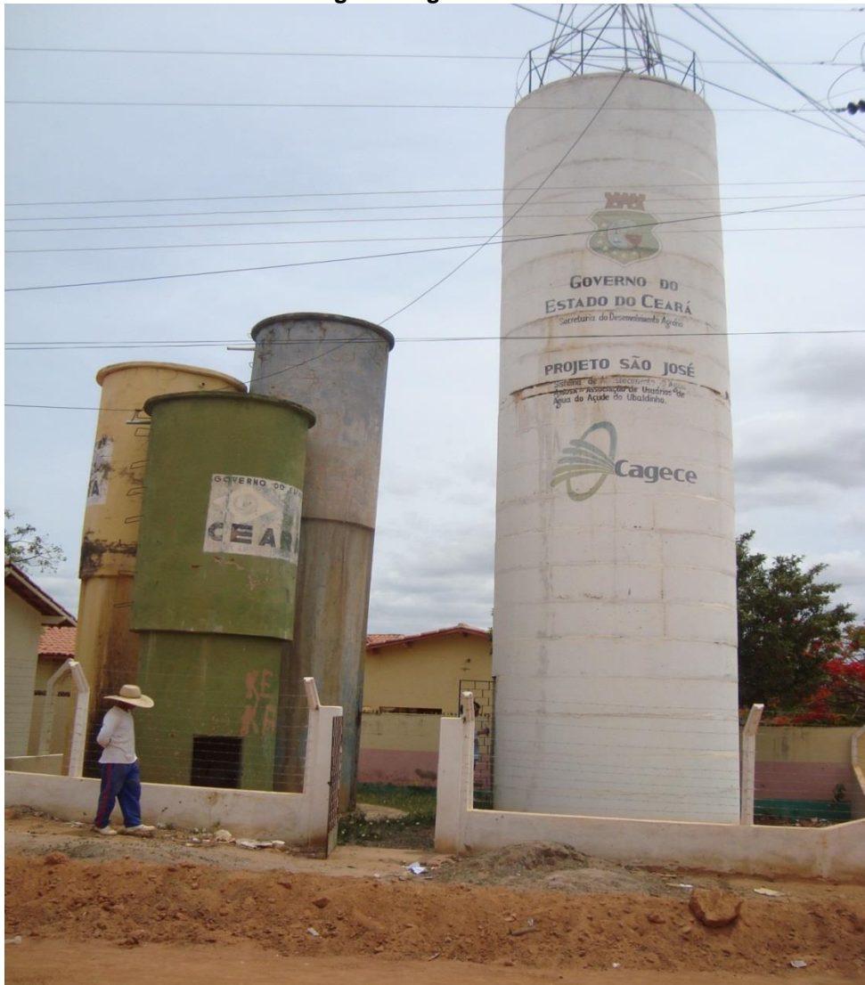
Figura 5.53: Reservatório Elevado (RELAT) em operação do Distrito de São Miguel – Agrovila
