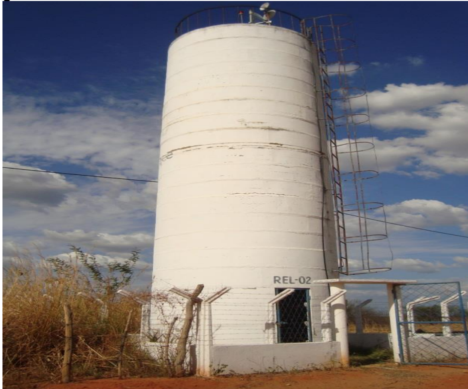
Figura 5.44: Reservatório Elevado 02 no distrito de Candeias
