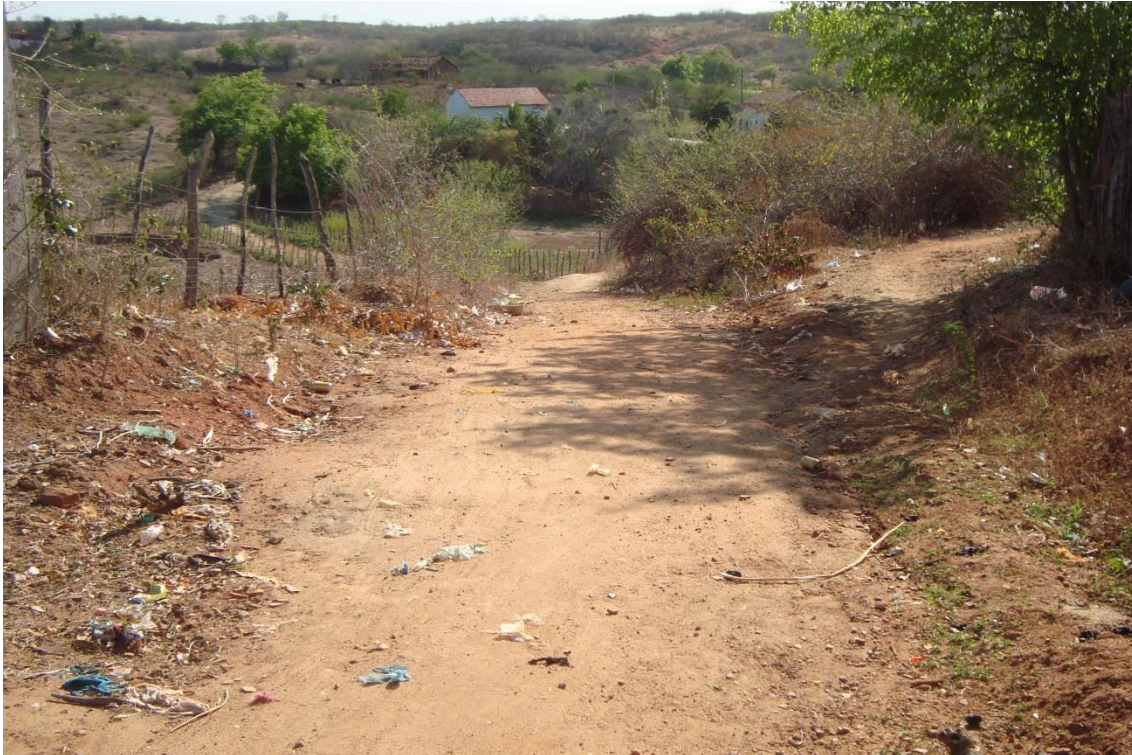
Figura 8.16: Via sem pavimentação com Indícios de erosão pluvial no distrito de Candeias.
