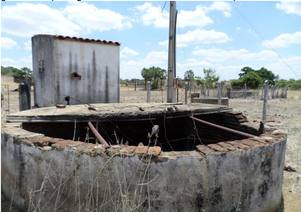
Figura 5.56: Poço de água doce desativado no Distrito de Assunção.
