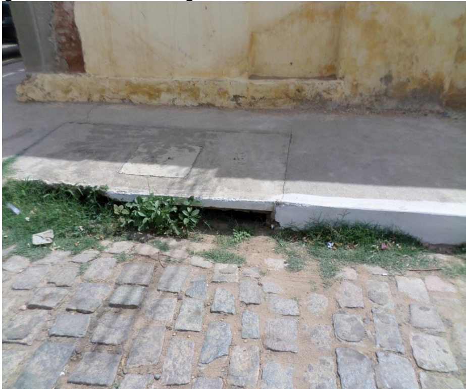
Figura 8.6: Boca de lobo retangular na Sede de Cedro
