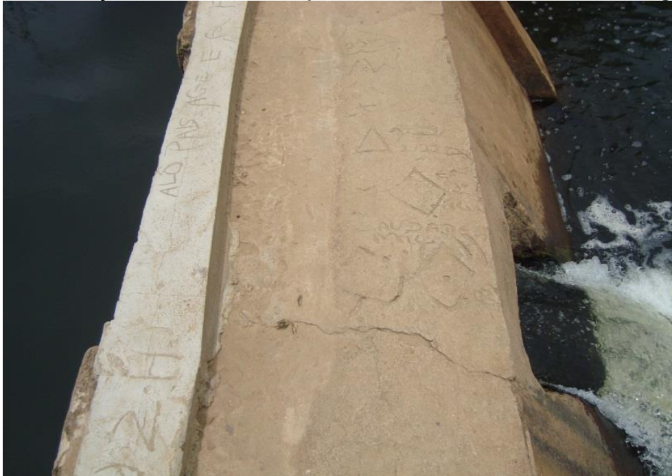
Figura 5.4: Construção de barreiras físicas para barramento no curso do Rio São Miguel
