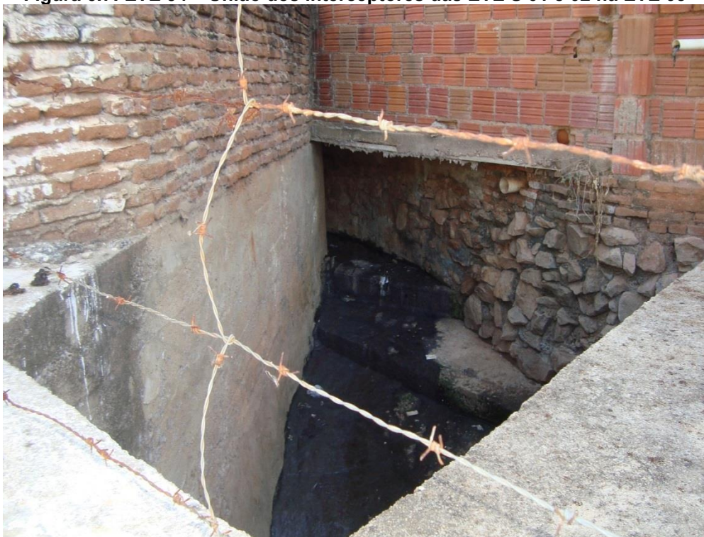
Figura 6.7: ETE 04 – União dos interceptores das ETE'S 01 e 02 na ETE 03
