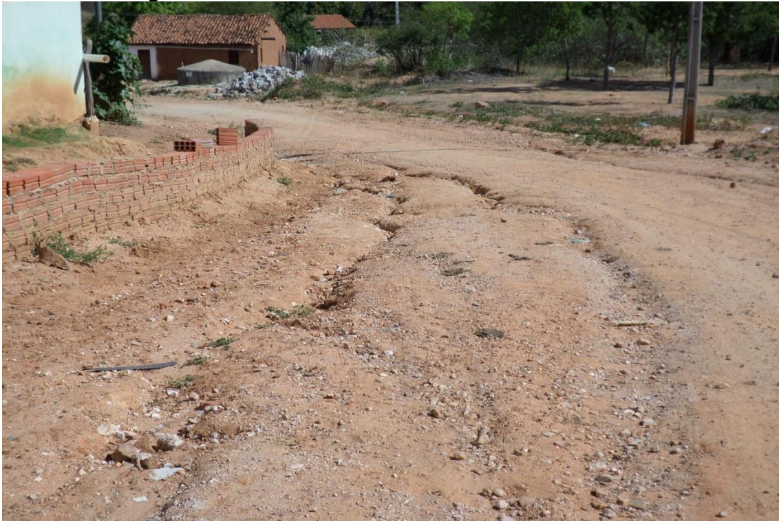
Figura 8.24: Processos erosivos da via do Vale do Machado
