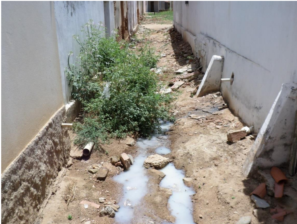
Figura 6.17: Águas cinza lançadas na via pública no Distrito de Várzea da Conceição
