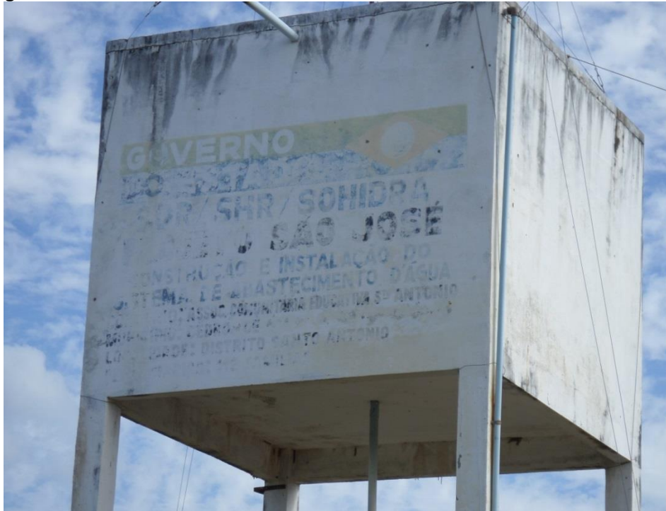
Figura 5.40: Reservatório Elevado do Distrito de Santo Antônio.
