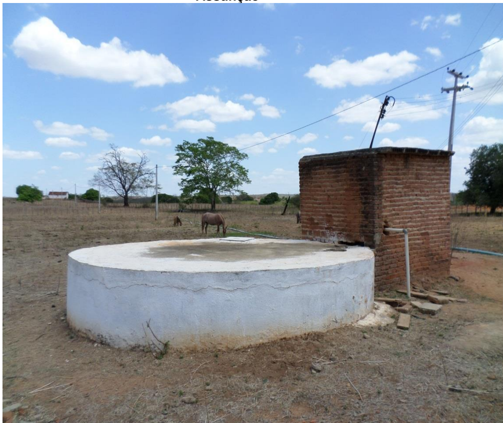
Figura 5.57: Casa de captação no Sítio Barreiras (Poço Amazonas) no Distrito de Assunção
