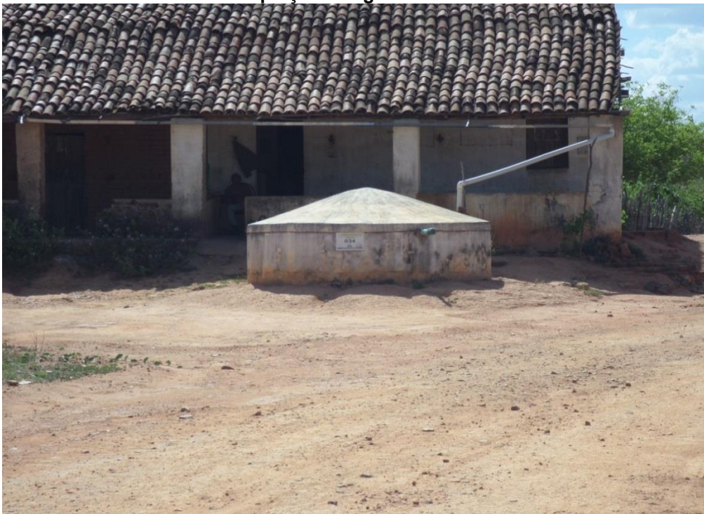
Figura 5.60: Residência situada no Distrito Vale do Machado e seu sistema de captação de água
