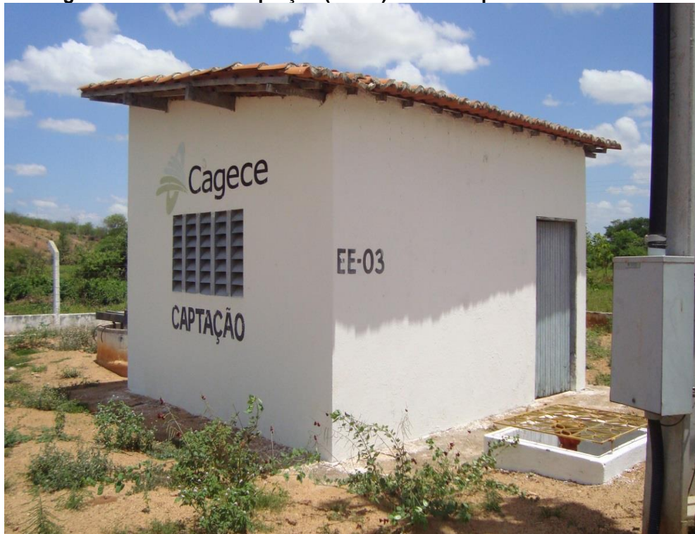
Figura 5.12: Casa de Captação (EE 03) do município de Cedro.
