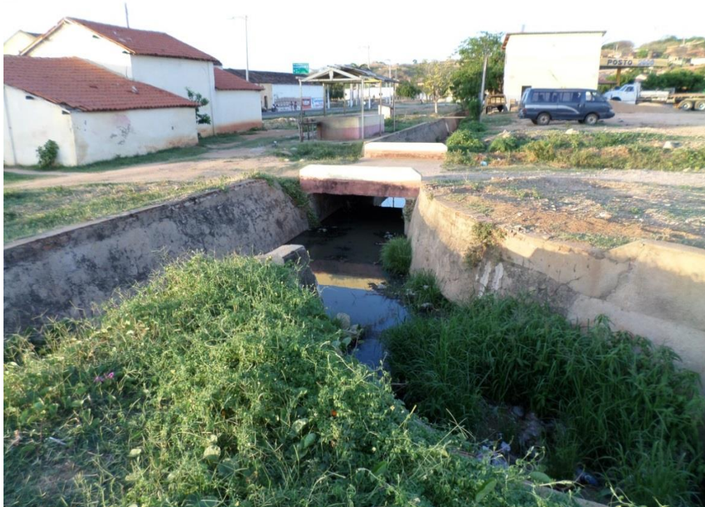
Figura 6.14: Canal da sede – corpo receptor do Açude Novo
