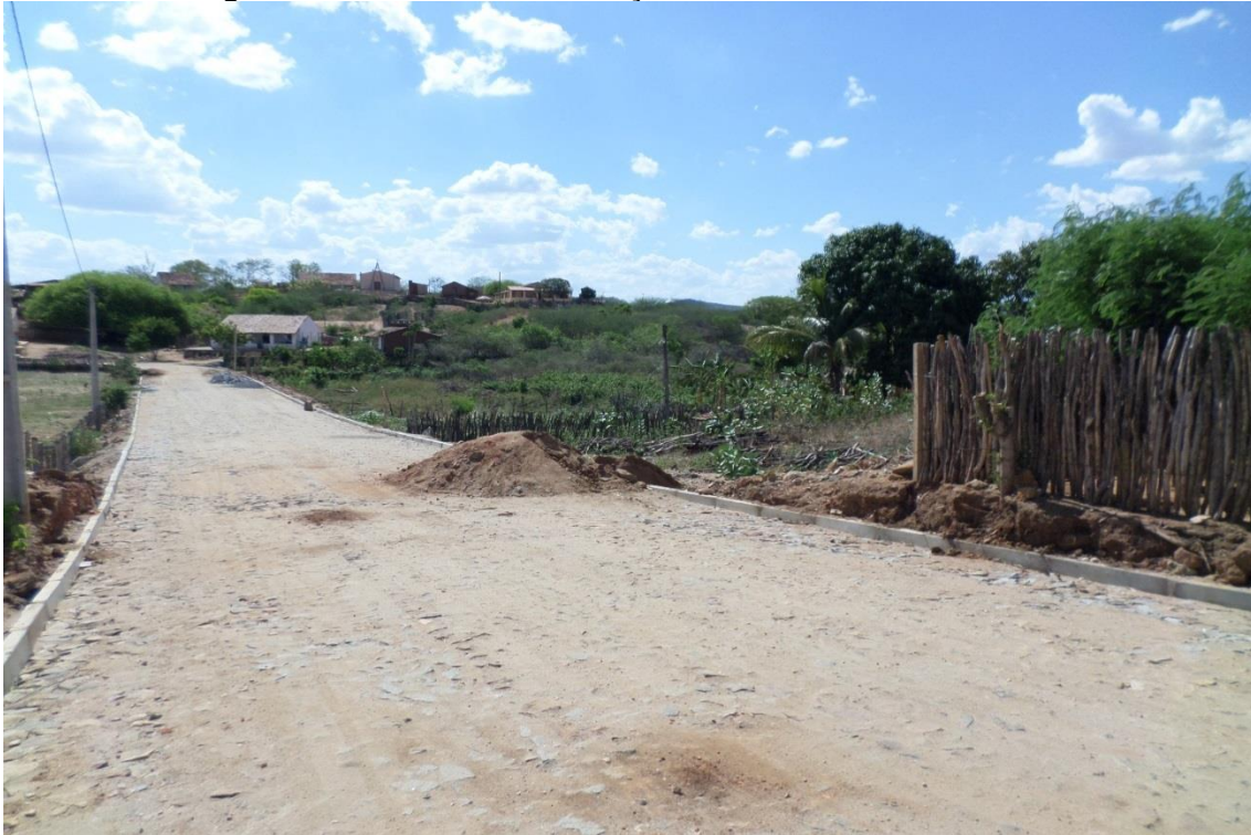
Figura 8.23: Obras de manutenção da via do Vale do Machado
