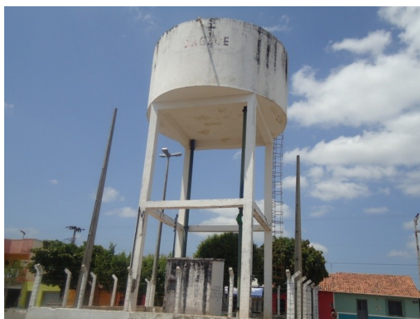
Figura 4.3 – Reservatório de água tratada com estrutura inclinada
