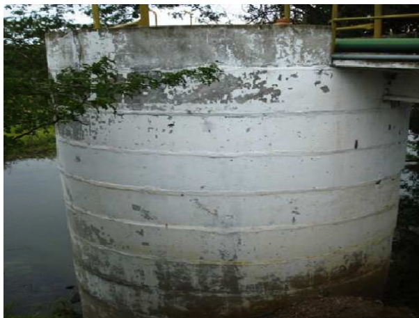
Figura 4.2 – Poço amazonas no leito do rio Banabuiu
