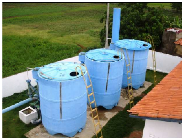
Figura 4.3 – Vista dos filtros e torre de equilíbrio
