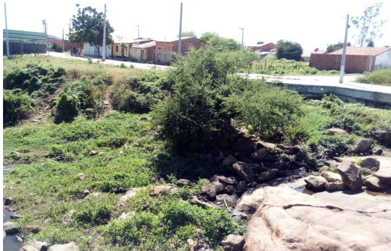
Figura 4.11 - Ocupação desordenada a margem de curso d'água, sede urbana
