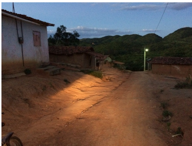
Figura 4.8 - Erosão do solo em rua não pavimentada
