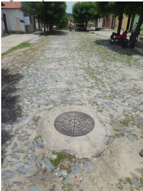
Figura 54: Poço de visita em rua do Distrito Sede.
