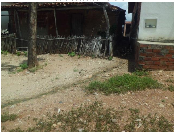
Figura 59: Vala negra com esgoto a céu aberto em logradouro da área urbana do município.
