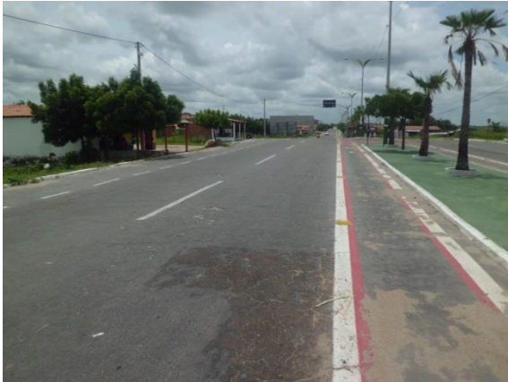
Figura 81: Pavimentação asfáltica em rua da área urbana do município.
