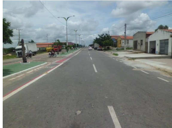
Figura 82: Pavimentação asfáltica em rua da área urbana do município.
