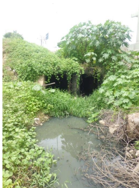
Figura 105: Estrutura de macrodrenagem na área urbana do município.
