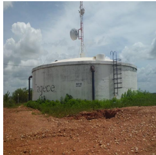
Figura 17: Reservatório apoiado.
