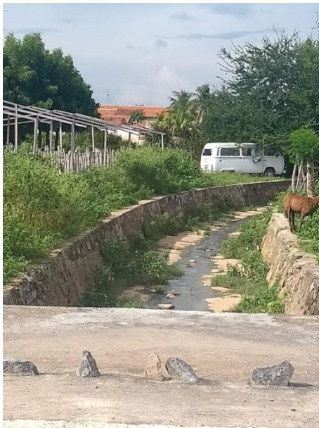
Figura 101: Canal e macrodrenagem na área urbana do município.
