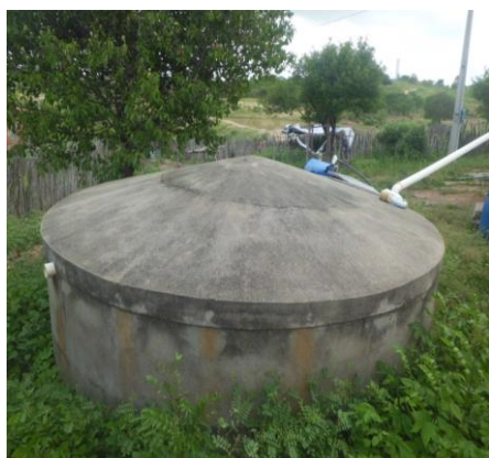
Figura 29: Cisterna em concreto.
