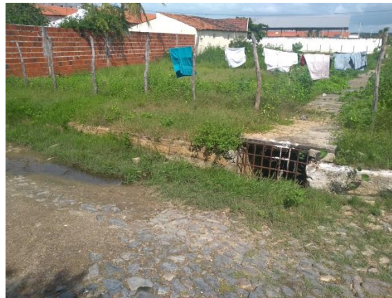
Figura 98: Boca de lobo com grelha em logradouro da área urbana do município.
