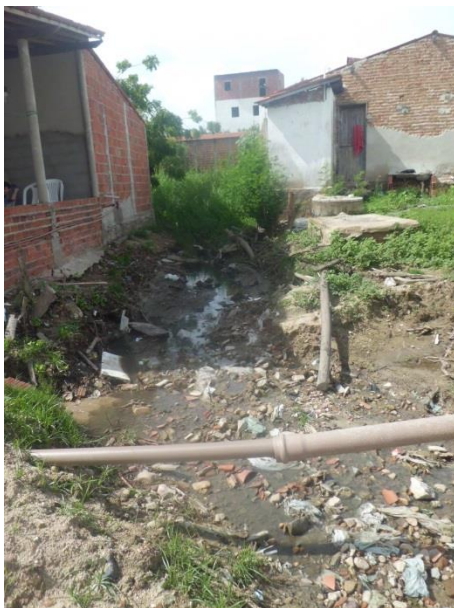
Figura 67: Vala negra com esgoto a céu aberto em logradouro da área urbana do município.
