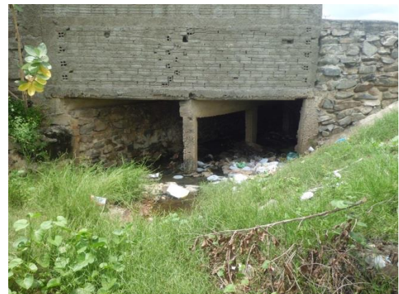
Figura 104: Estrutura de macrodrenagem na área urbana do município.
