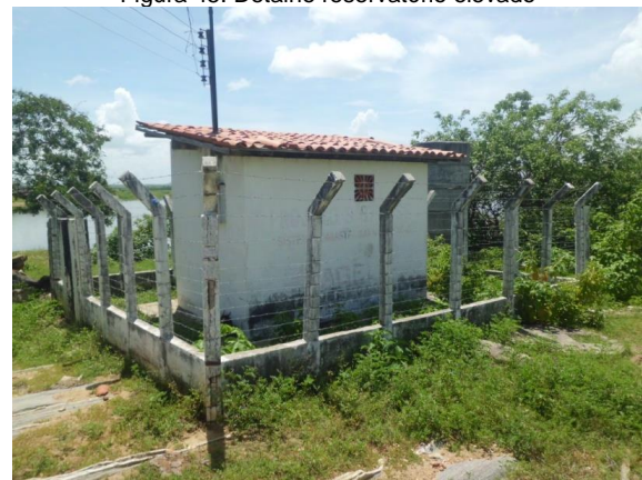
Figura 47: Vista externa casa de comando
