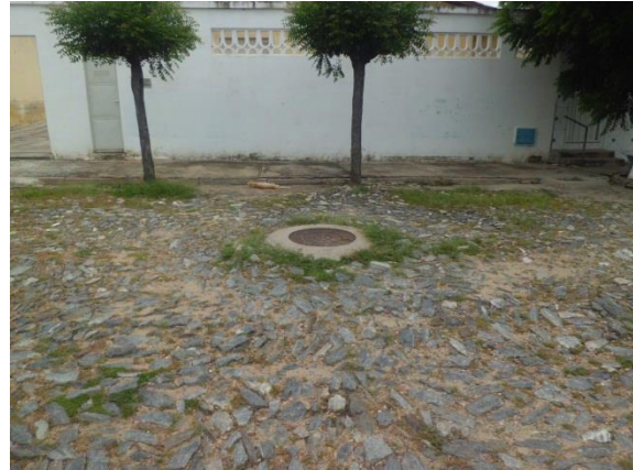
Figura 51: Poço de visita em rua do Distrito Sede.
