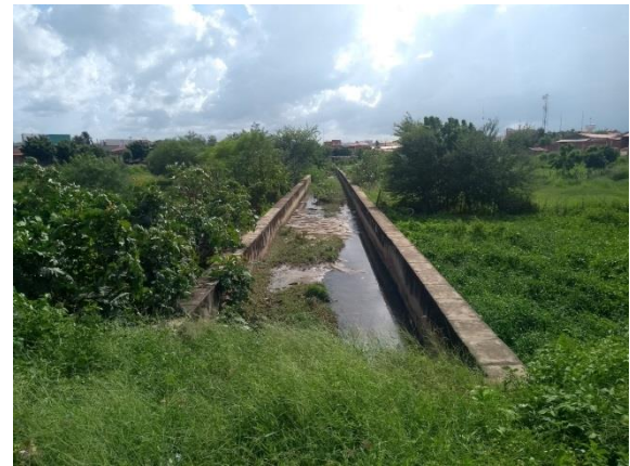
Figura 102: Canal e macrodrenagem na área urbana do município.
