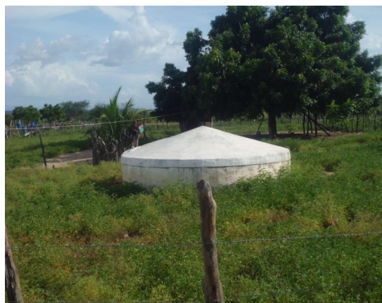
Figura 36: Cisterna em concreto.
