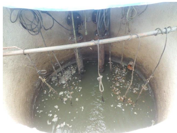
Figura 73: Interior do poço de sucção da estação de elevatória de esgoto.
