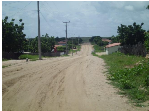
Figura 88: Logradouro sem pavimentação na localidade de Alegre.
