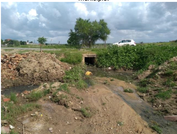
Figura 103: Estrutura de macrodrenagem na área urbana do município.
