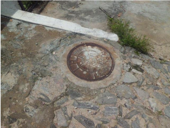
Figura 50: Poço de visita em rua do Distrito Sede.
