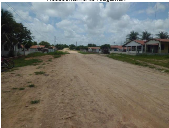
Figura 89: Logradouro sem pavimentação na localidade de Barragem.
