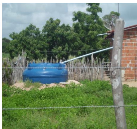
Figura 30: Cisterna em fibra de vidro.
