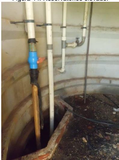
Figura 46: Interior reservatório elevado
