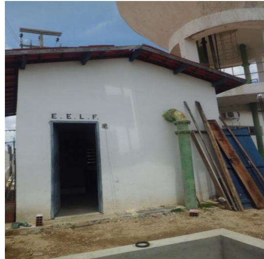
Figura 13: Estação Elevatória EELF-01.
