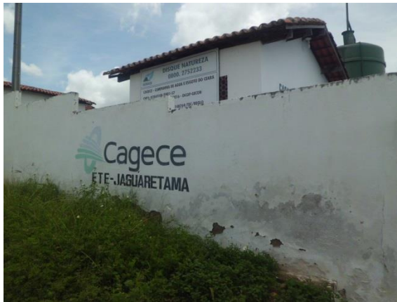
Figura 70: Entrada ETE Jaguaretama.
