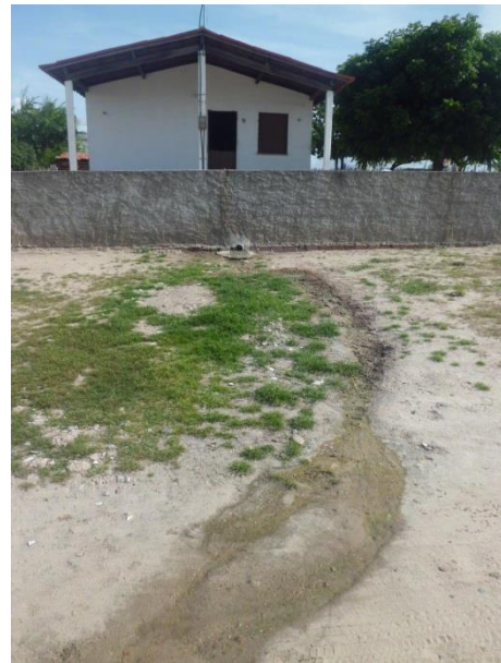
Figura 66: Água cinza sendo lançadas em logradouro no Reassentamento Alagamar.
