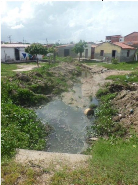
Figura 63: Vala negra com esgoto a céu aberto no bairro Nossa Senhora da Conceição da área urbana do município.
