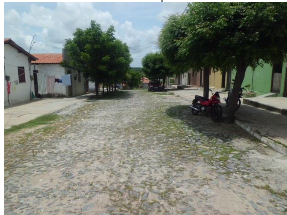
Figura 84: Pavimentação com rocha em rua da área urbana do município.
