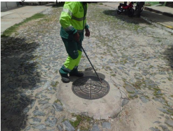
Figura 52: Poço de visita em rua do Distrito Sede.
