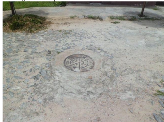
Figura 53: Poço de visita em rua do Distrito Sede.
