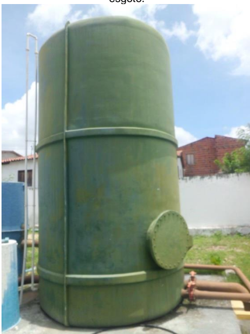
Figura 74: Reator UASB - ETE Jaguaratama.
