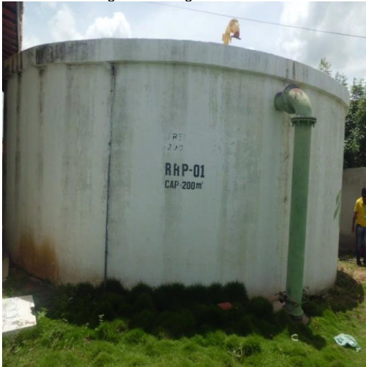
Figura 18: Reservatório Apoiado RAP-01.
