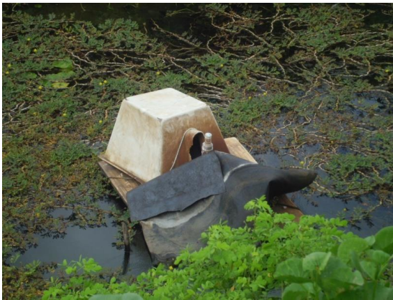
Figura 27: Captação superficial.
