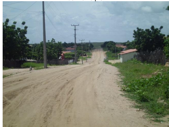
Figura 86: Logradouro sem pavimentação na localidade de Alegre.
