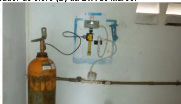
Figura 5.8: Minilaboratório (A) e dosador de cloro (B) da ETA de Marco.
