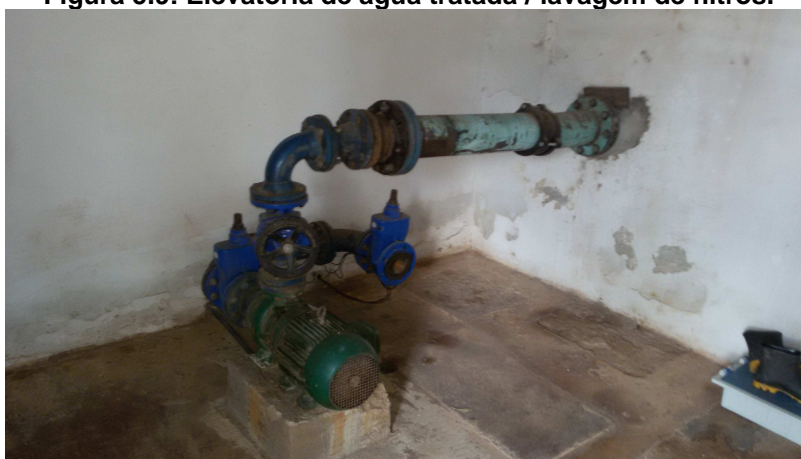
Figura 5.9: Elevatória de água tratada / lavagem de filtros.
