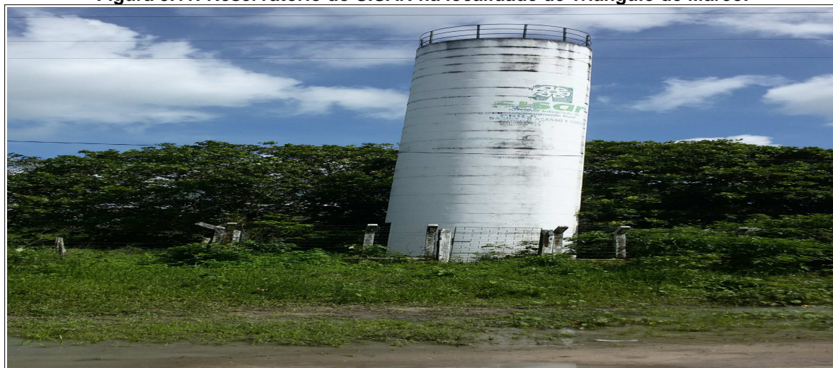
Figura 5.11: Reservatório do SISAR na localidade de Triângulo de Marco.
