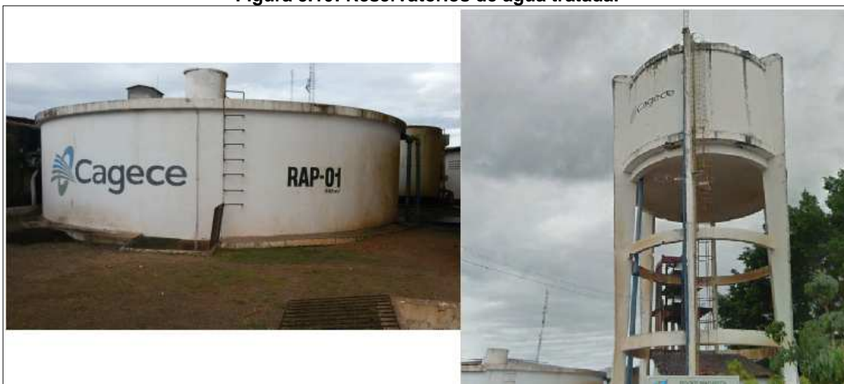
Figura 5.10: Reservatórios de água tratada.
