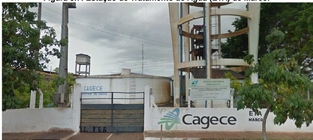
Figura 5.7: Estação de Tratamento de Água (ETA) de Marco.
