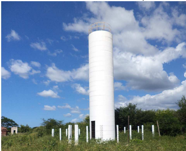
Figura 5.12: Reservatório instalado na localidade de Sedó, no distrito de Mocambo.
