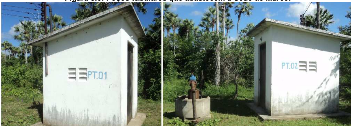
Figura 5.6: Poços tubulares que abastecem a Sede de Marco.
