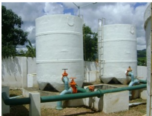
Figura 4.3 – Filtros da Estação de Tratamento de Água de Monsenhor Tabosa
