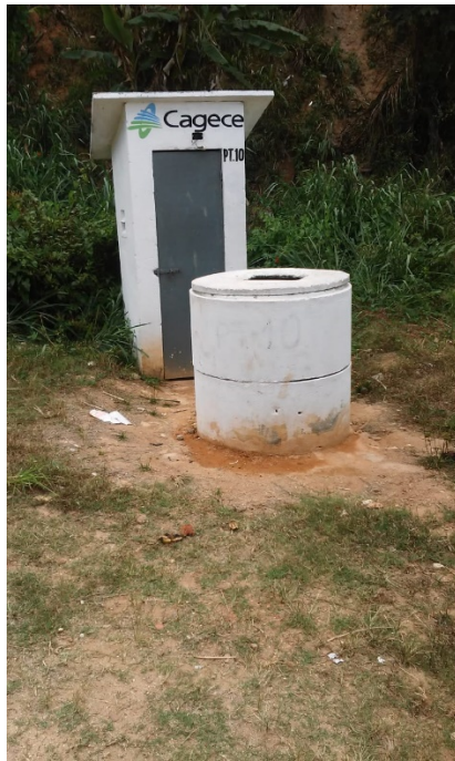
Figura 4.2 - Poço PT-10, rua Padre Quiliano
