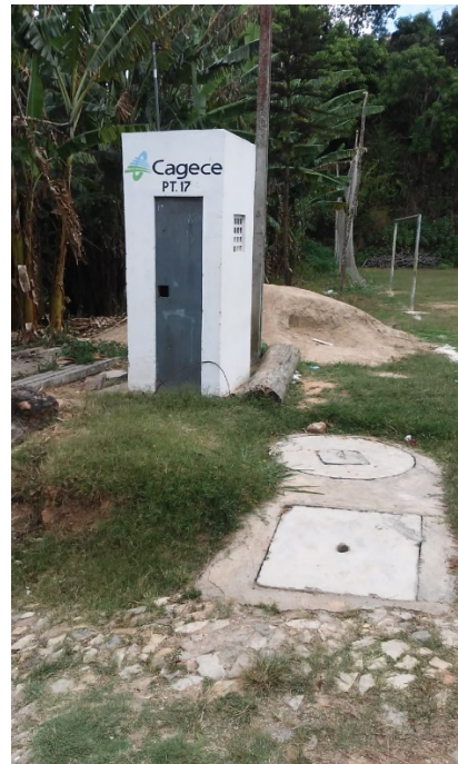
Figura 4.3 - Poço PT-17, rua Padre Quiliano
