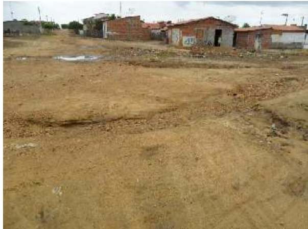
Figura 4.36 – Área com erosão por falta de drenagem no distrito Sede
