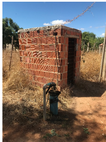
Figura 4.3 - Poço de Juá (PT-04)
