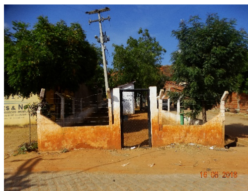
Figura 4.3 - Poço PT-02 - rua Guilherme Couto
