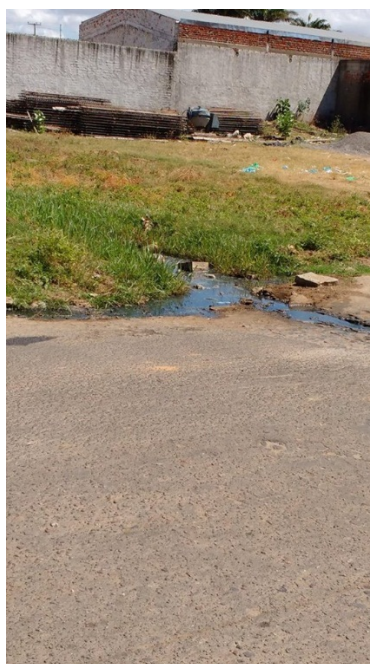
Figura 4.3 – Esgoto a céu aberto na Rua Antônio Guedes Neto.
