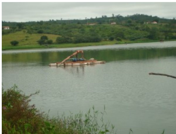
Figura 4.2 – Captação do sistema de abastecimento de Quiterianópolis
