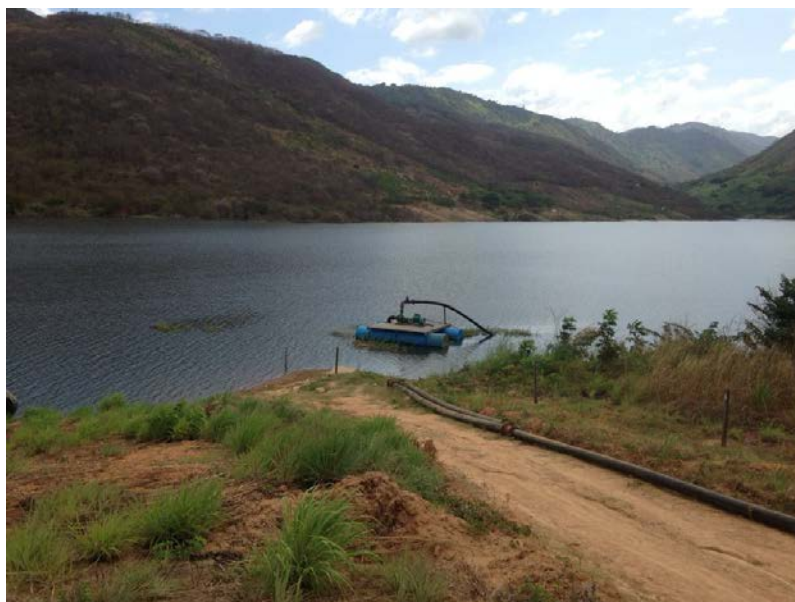
Figura 4.2 - Captação no açude Mundaú
