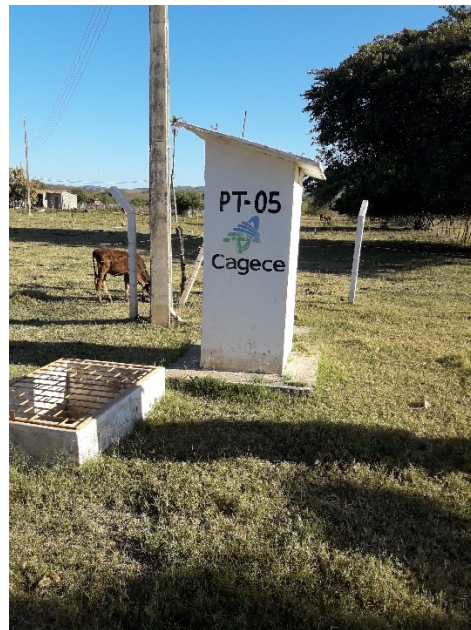
Figura 4.3 - Poço PT-05, Logradouro
