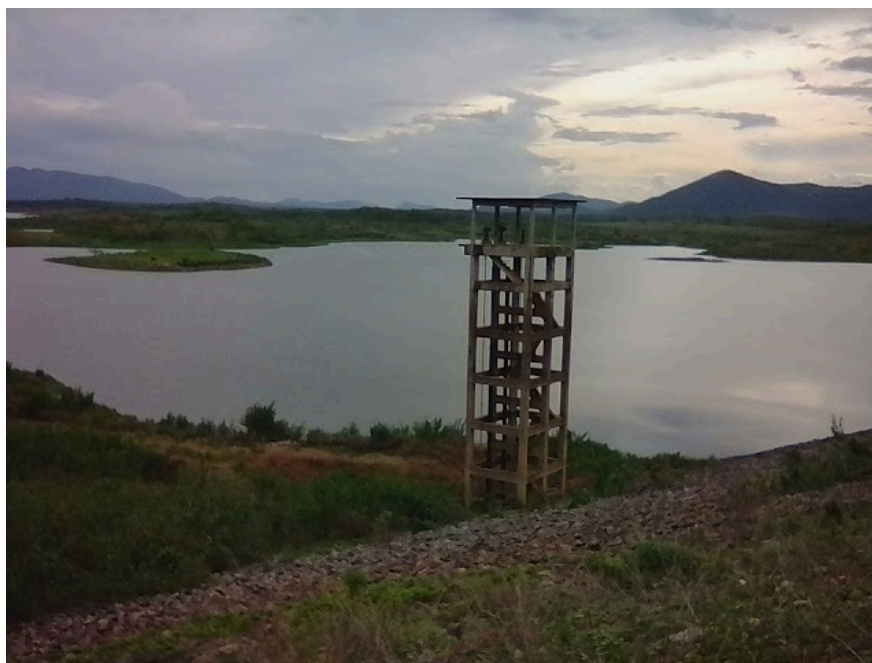
Figura 4.2 - Captação no açude Caxitoré
