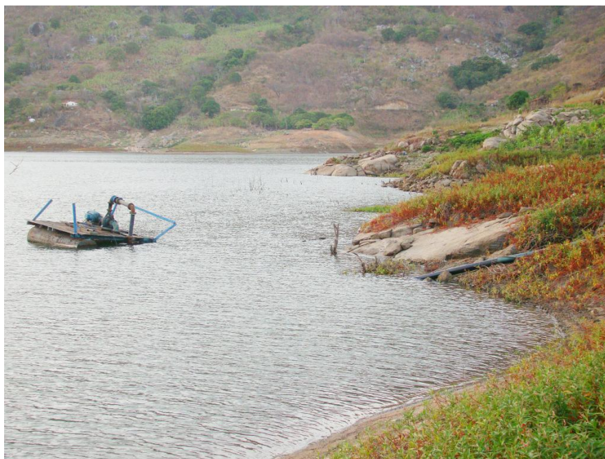
Figura 4.2 - Captação no açude Mundaú
