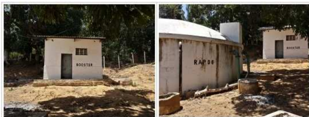
Figura 4.3.9: Booster no bairro Pedra Lipes.
