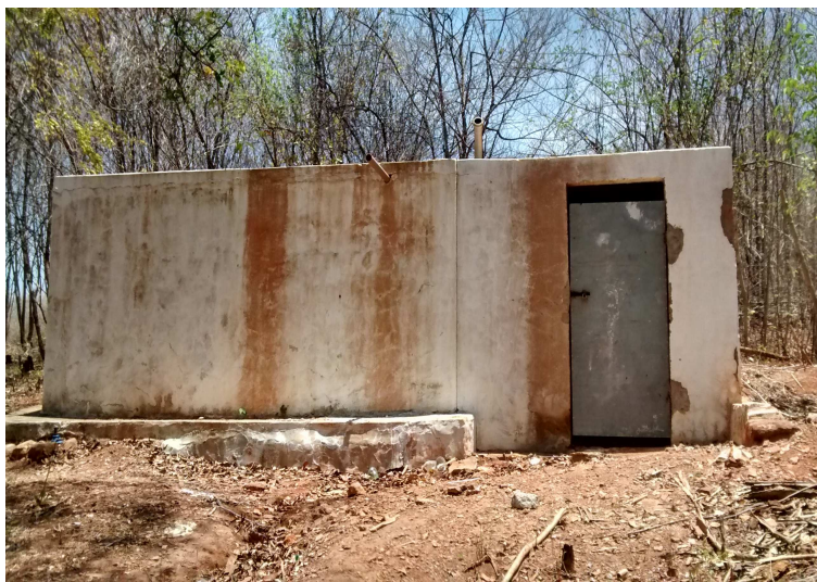
Figura 4.3.13: RAP-01 – distrito Lamedouro.
