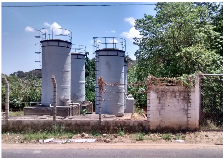
Figura 4.3.18: Digestores anaeróbios/Filtros operados pela Prefeitura.
