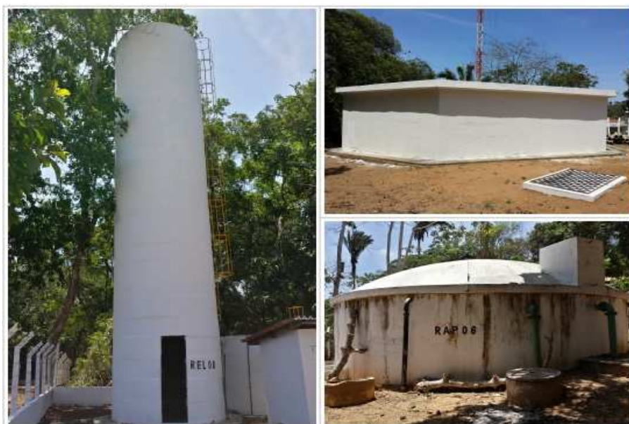
Figura 4.3.10: Reservatórios existentes na Sede.
