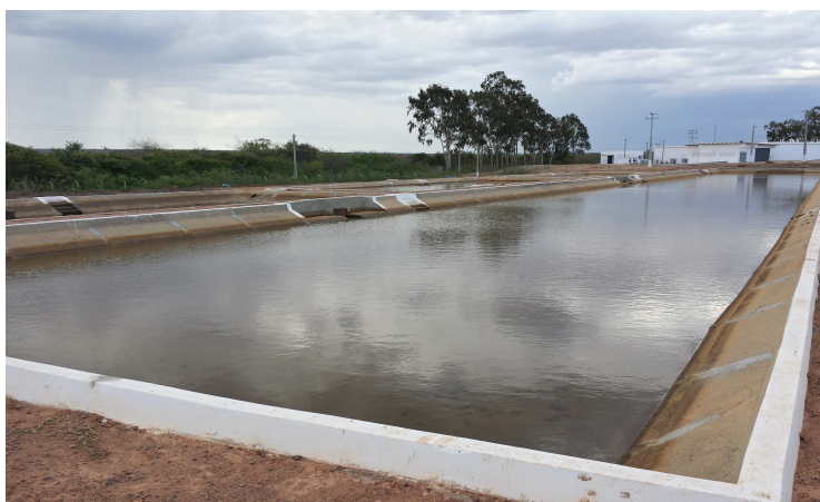
Figura 4.3.5: ETRG da ETA Jaburu.
