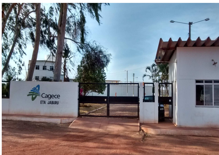
Figura 4.3.4: Fachada da ETA Jaburu.
