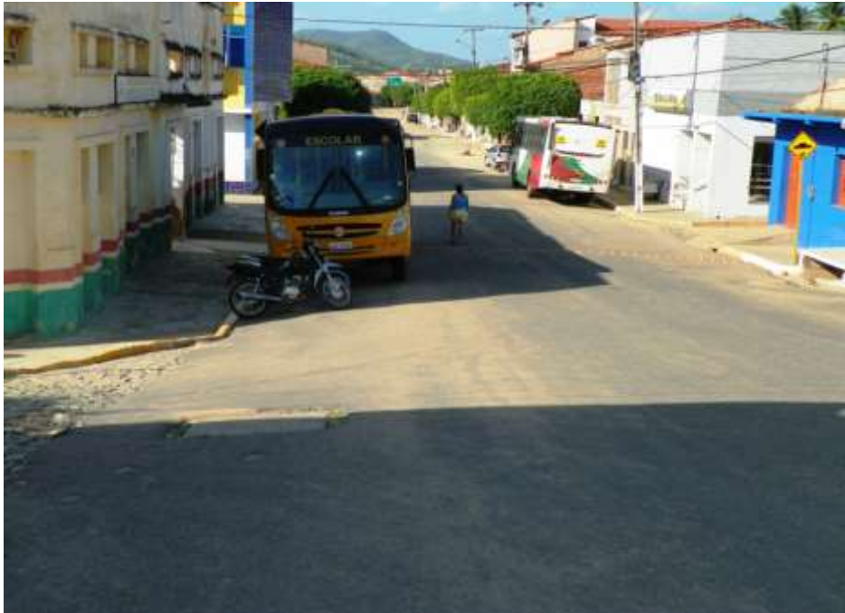
Figura 7.47 – Rede de esgoto na Rua José Liberalino Duarte, sede de Farias Brito. Fonte: Consórcio DGH-Cariri (2011).
