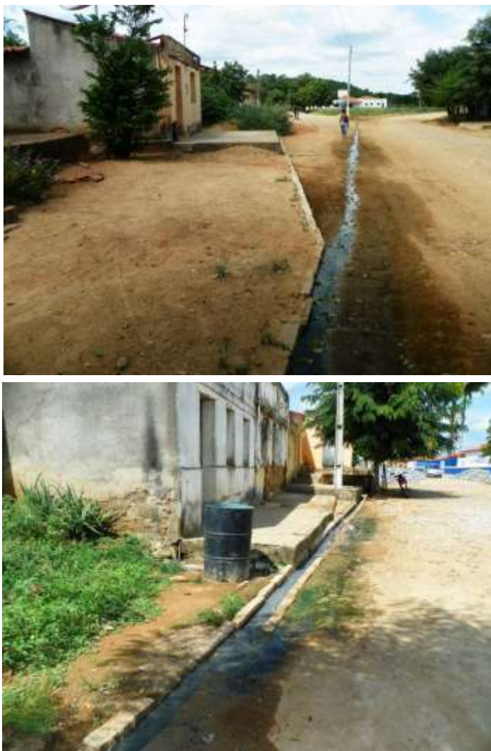
Figura 7.59 – Esgoto a céu aberto no distrito de Nova Betânia. Fonte: Consórcio DGH-Cariri (2011).
