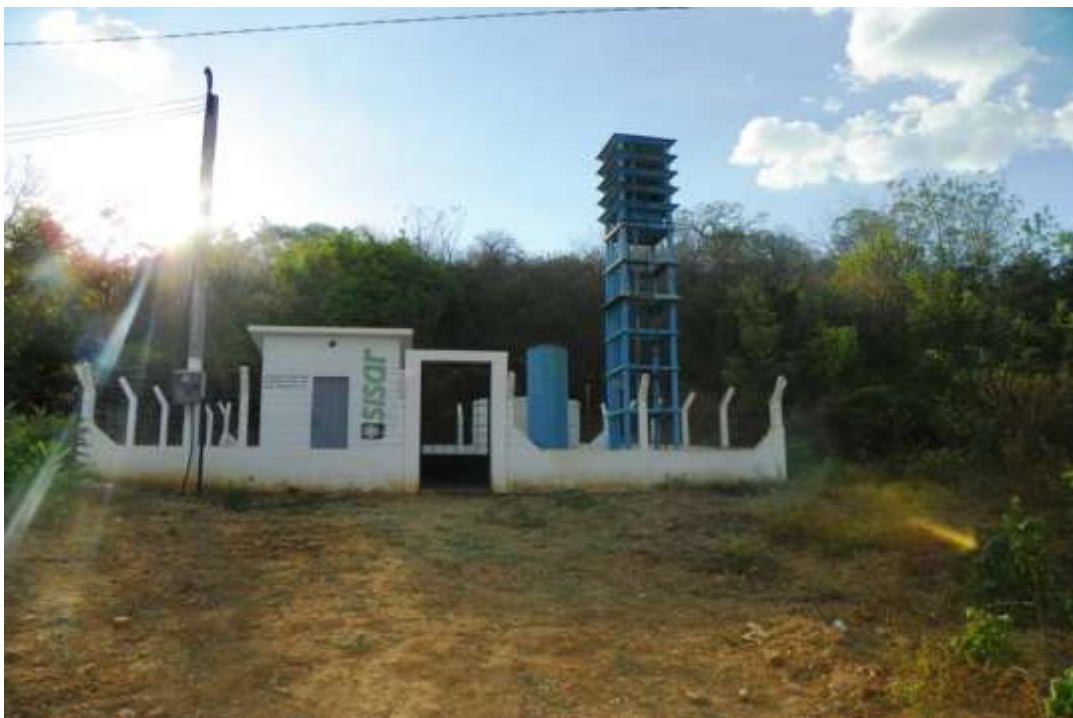
Figura 7.36 – Vista do poço ( Q = 5,1 \text{ m}^3/\text{h} ) e ETA da localidade de São João, no município de Farias Brito, de responsabilidade do SISAR.
