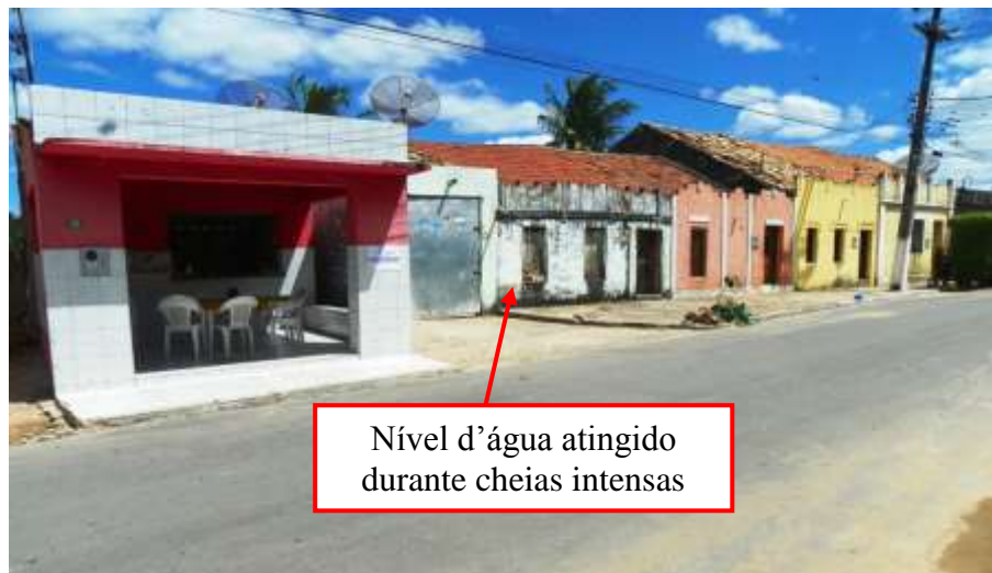
Figura 7.71 – Ponto de alagamento na Rua Apolônio de Oliveira. Fonte: Consórcio DGH-Cariri (2011).
