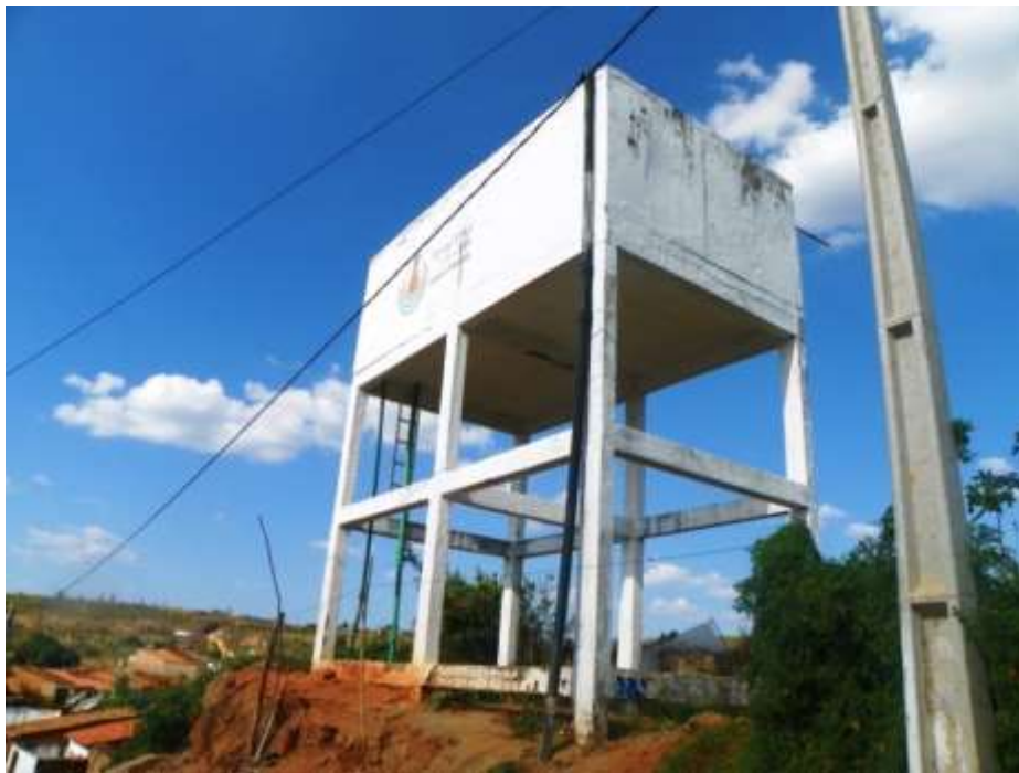
Figura 7.22 – Vista do poço ( Q = 6,2 \text{ m}^3/\text{h} ) e reservatório elevado de 45 \text{ m}^3 que atende ao distrito de Quincuncá, no município de Farias Brito, de responsabilidade do SISAR.
