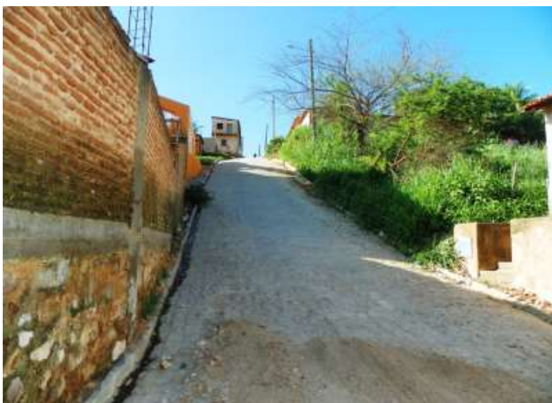
Figura 7.49 – Esgoto a céu aberto na Rua Gabriel Bezerra de Moraes na sede de Farias Brito.
