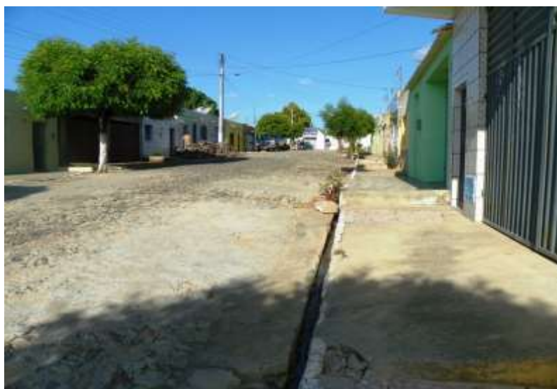
Figura 7.50 – Esgoto a céu aberto na Rua Liromar Fernandes de Oliveira na sede de Farias Brito.
