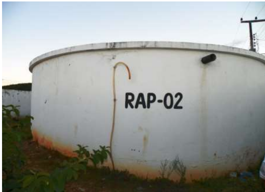
Figura 7.16 – Vista do reservatório apoiado RAP-02 (50 m 3 ).
