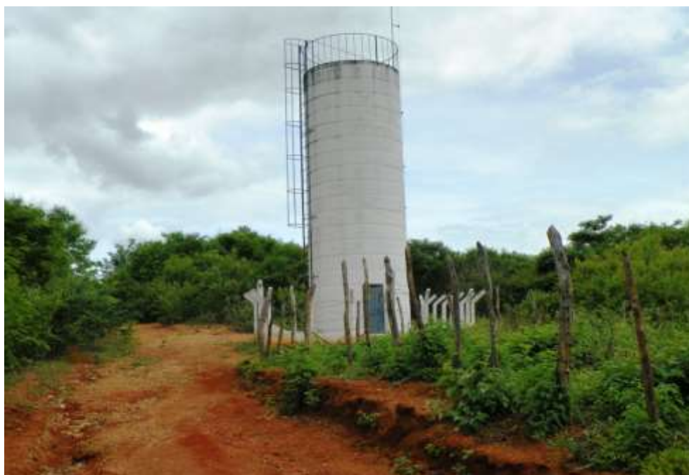
Figura 7.25 – Vista do poço ( Q = 6,0 \text{ m}^3/\text{h} ) e reservatório elevado de 28 \text{ m}^3 que atende ao distrito de Catingueira, no município de Farias Brito, de responsabilidade do SISAR.
