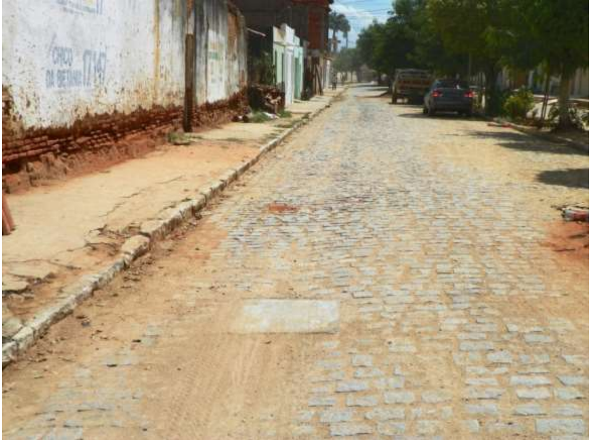
Figura 7.58 – Construção de rede de esgoto na Avenida Manoel Neri de Oliveira no distrito de Nova Betânia.
