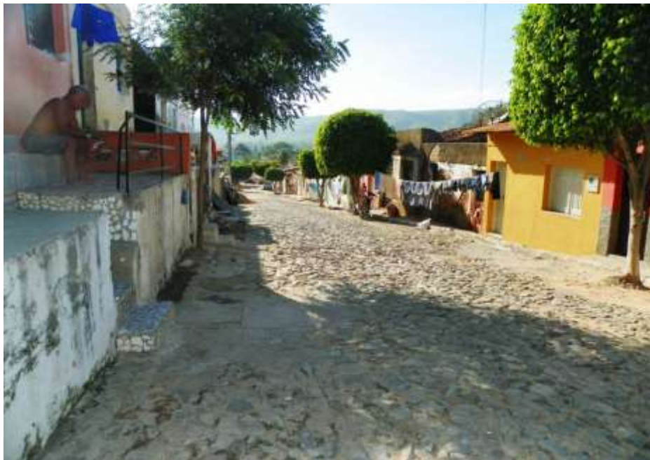
Figura 7.48 – Rede de esgoto na Rua Dr. Raimundo Alves Bezerra, sede de Farias Brito. Fonte: Consórcio DGH-Cariri (2011).
