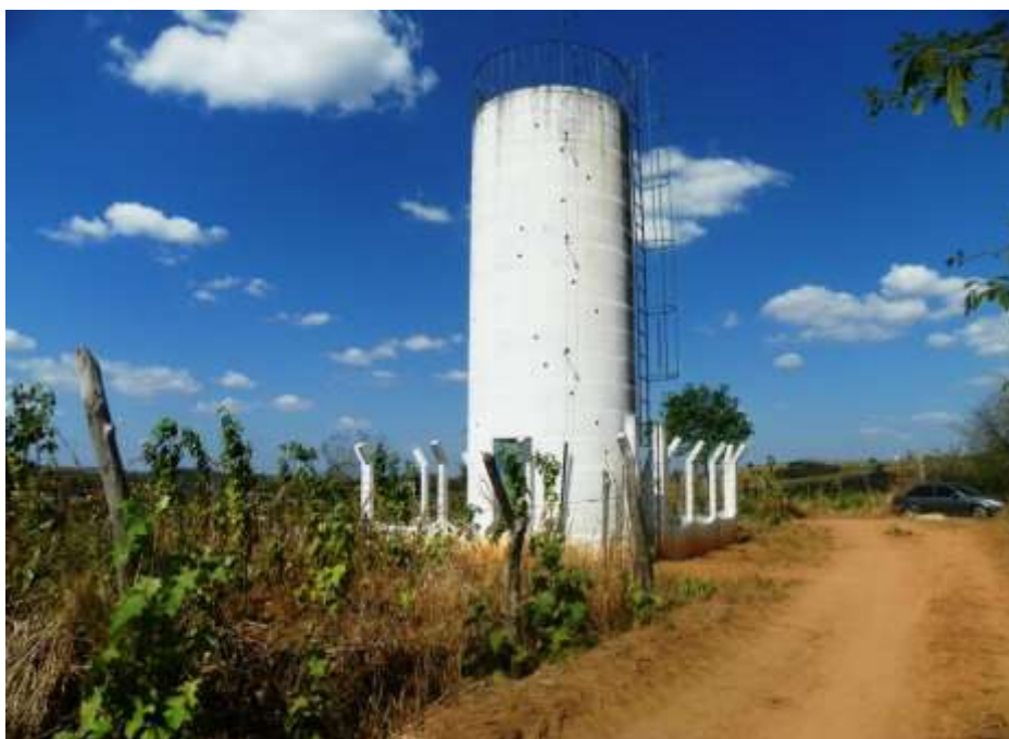
Figura 7.33 – Vista do poço ( Q = 6,3 \text{ m}^3/\text{h} ) e reservatório elevado de 30 \text{ m}^3 da localidade de Ribeirinha, no município de Farias Brito, de responsabilidade do SISAR.
