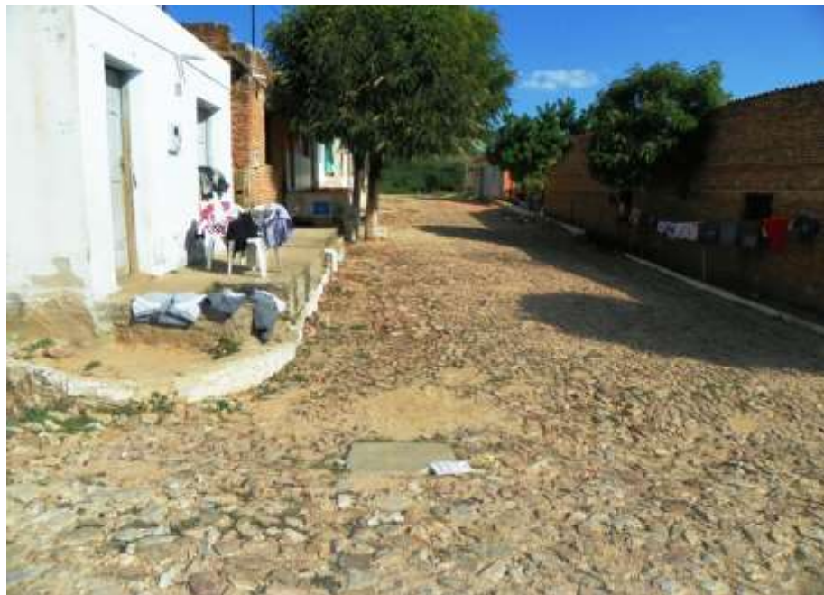
Figura 7.46 – Rede de esgoto na Rua Mizaél Liberalino de Menezes, sede de Farias Brito.
