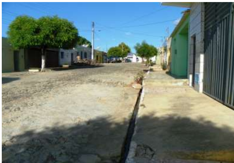
Figura 5.3 – Esgoto a céu aberto na Rua Liromar Fernandes de Oliveira na sede de Farias Brito.
