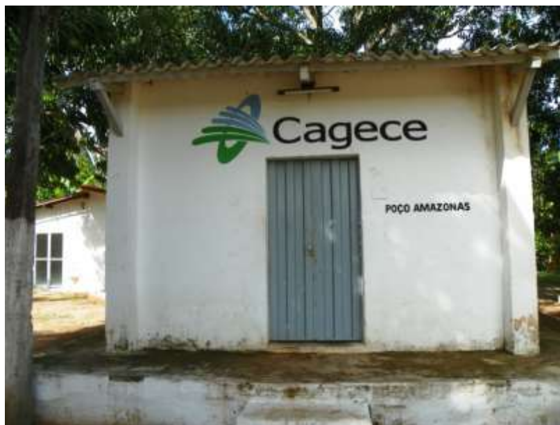
Figura 5.1 – Vista do poço amazonas (PA) que faz parte do manancial da sede de Farias Brito.
