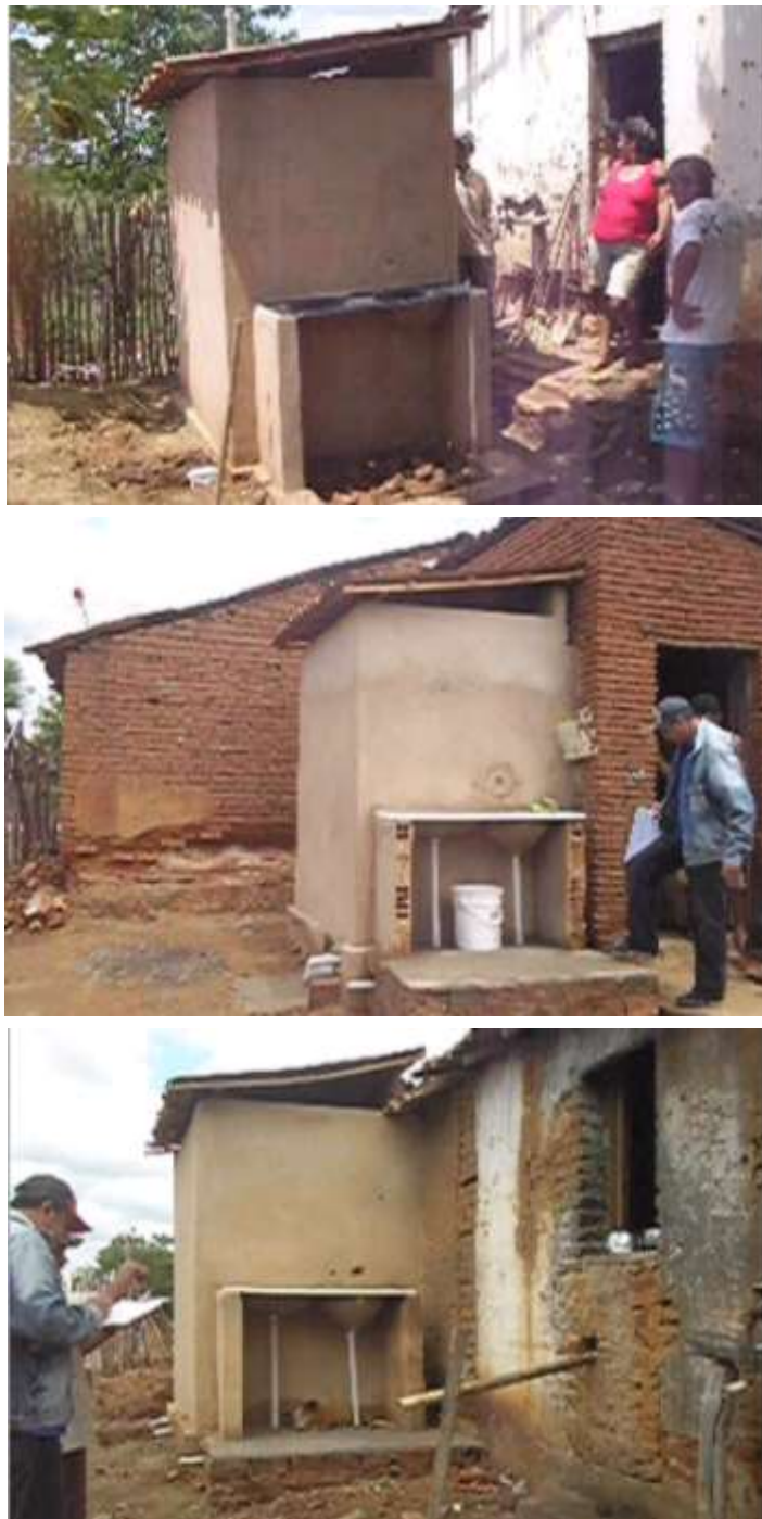
Figura 5.16 – Vista de algumas das melhorias sanitárias domiciliares (MSD) da localidade de Catingueira, no município de Farias Brito.
