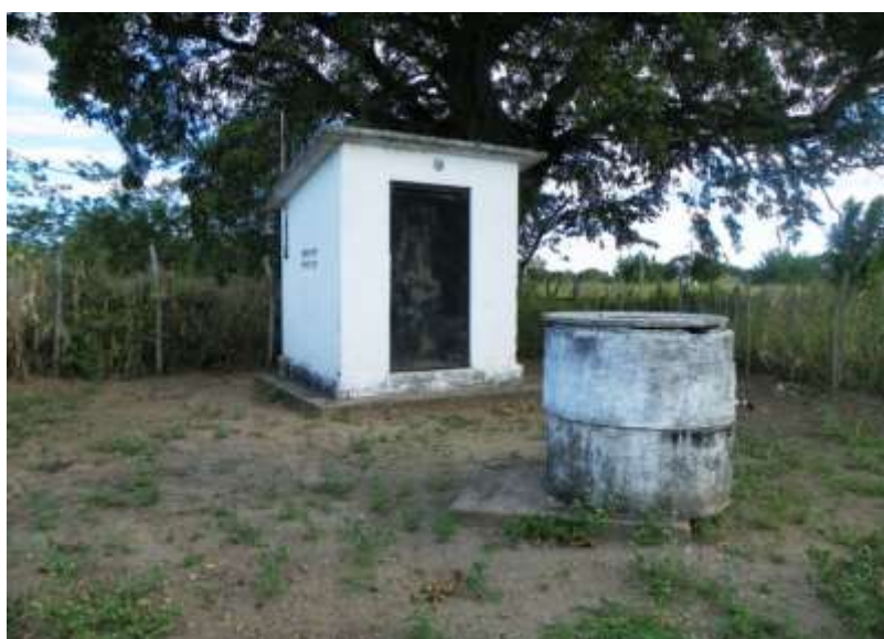
Figura 5.4 – Vista dos poços tubulares PT-01 e PT-02 que abastecem o distrito de Cariutaba.
