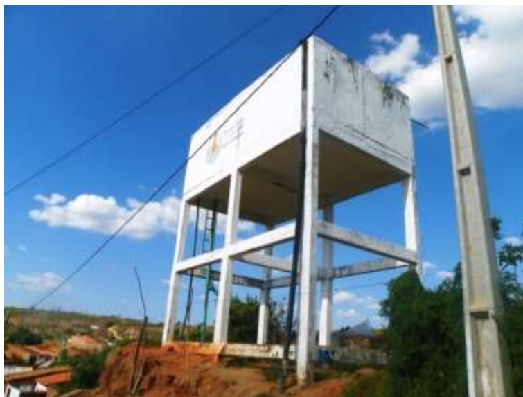
Figura 5.8 – Vista reservatório elevado de 45 m 3 que atende ao distrito de Quincuncá, no município de Farias Brito, de responsabilidade do SISAR.
