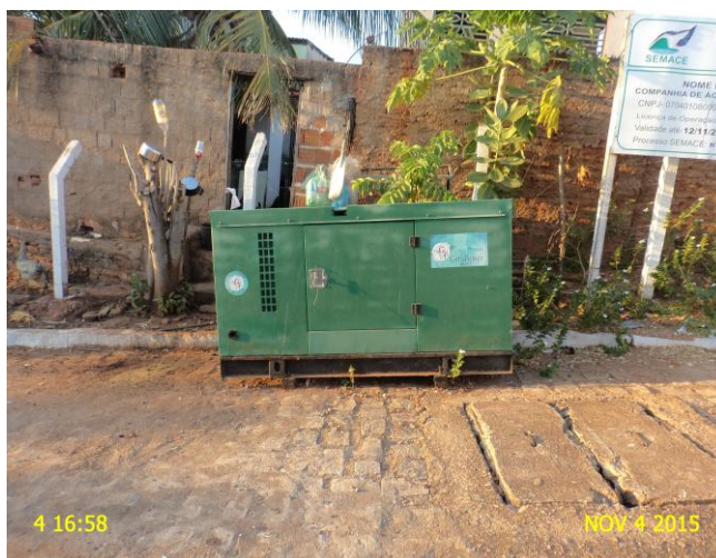
Foto 3 – Grupo gerador a ser instalado.
